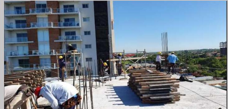
Replanteo y armadura de los pilares losa del quinto piso
