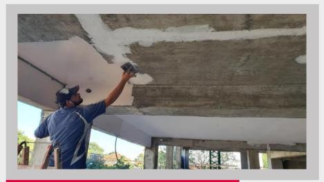
Trabajos de prolijado y enduido de los fondos de losa en estacionamientos
