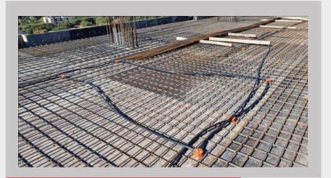
Armaduras e instalación eléctrica en losa de la azotea
