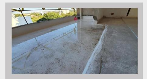
Prueba de aislación en balcón del piso 4
