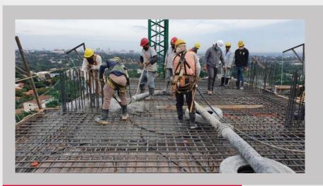
Inicio del hormigonado de la losa del piso 13
