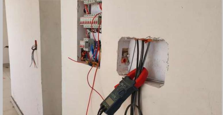
Cableado y montaje de tablero en el cuarto piso
