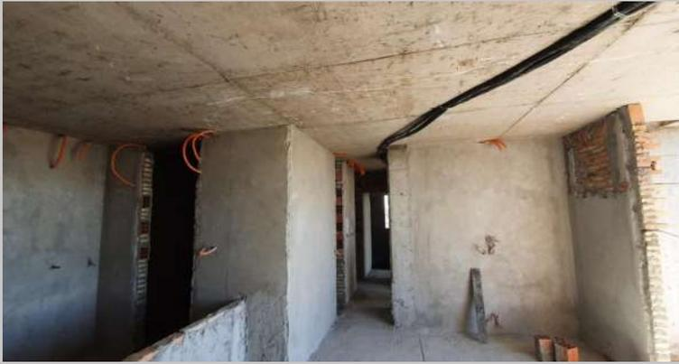
Revoque de paredes e instalación de ductos AA en el 6B
