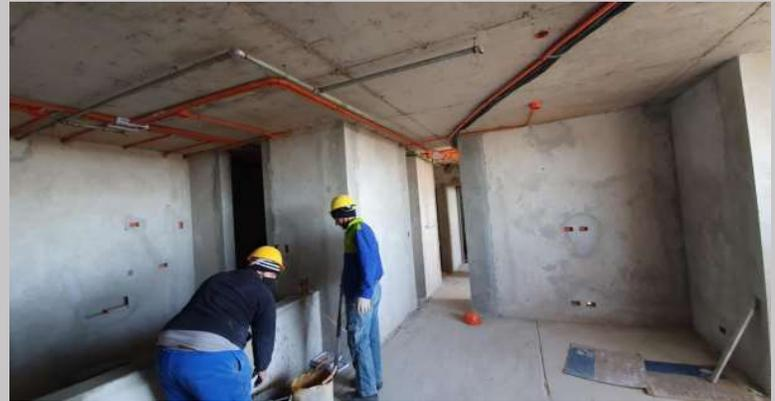
Revoque e instalaciones bajo losa piso 5
