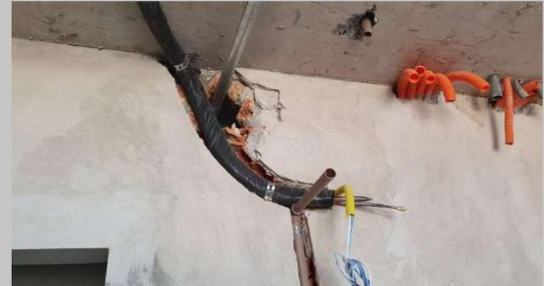
Instalación de AA y desagüe de evaporador en dptos. del quinto piso
