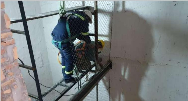
Colocación de malla separadora entre ascensores
