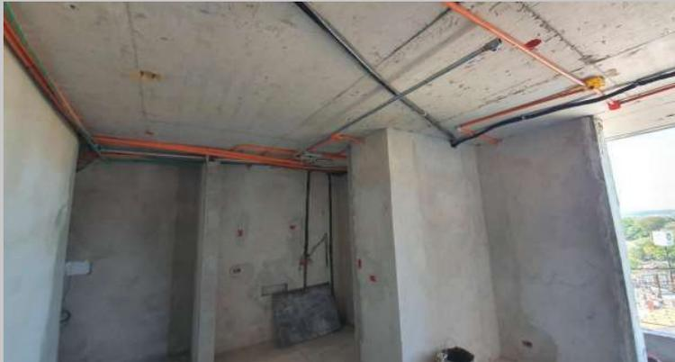
PCI y eléctrica bajo losa del piso 5
