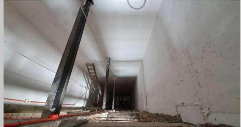
Montaje de perfiles centrales, revoque y blanqueado en caja de ascensores
