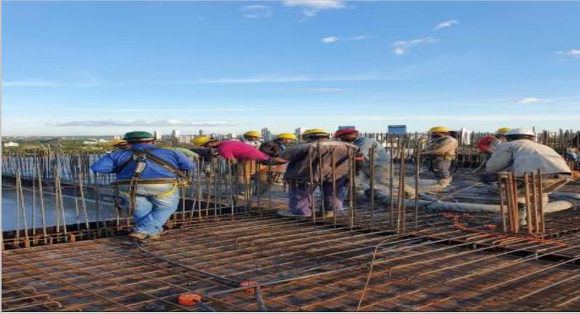
Jornada de hormigonado de la losa techo del piso 9 o losa de azotea
