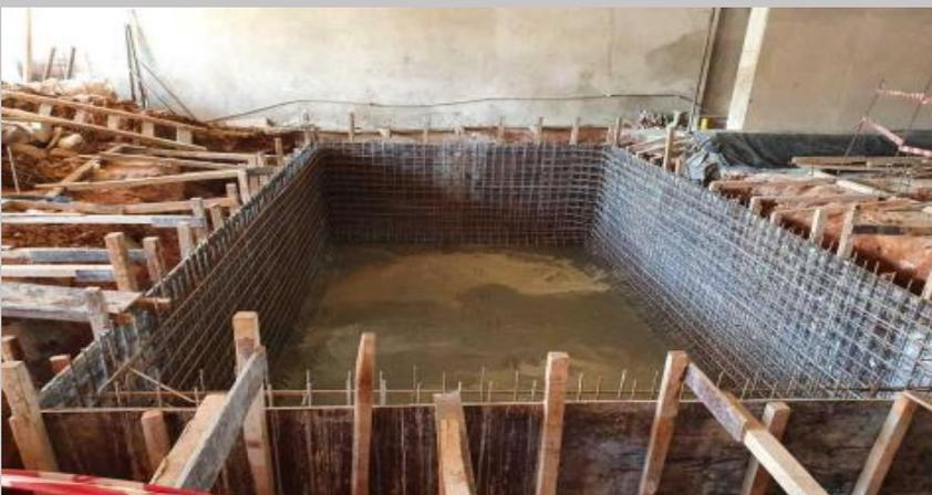
Encofrado y armaduras de los tabiques del tanque
