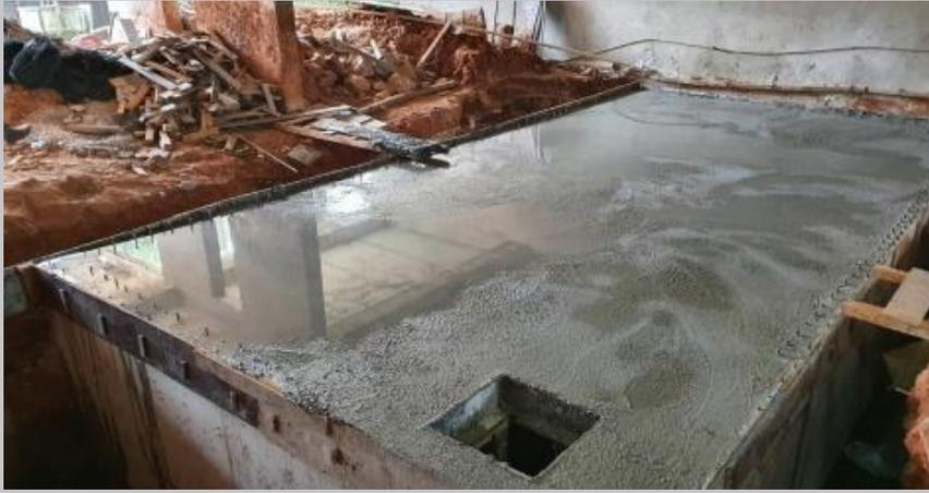
Tanque de agua inferior ya totalmente hormigonado
