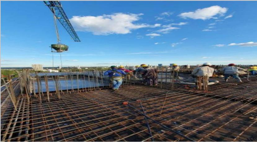
Hormigonado del fondo de la piscina en losa azotea
