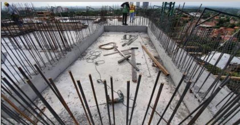
Losa fondo de piscina con los arranques para las paredes
