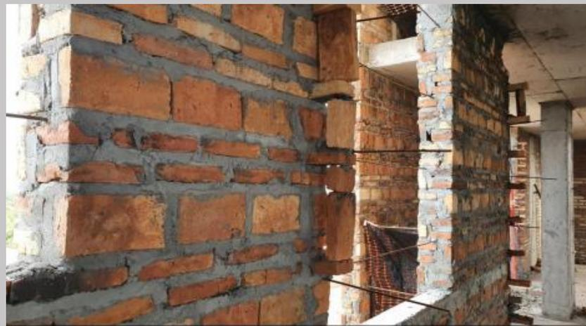
Una toma donde se ven las paredes linderas de 0,20 común con el envarillado
