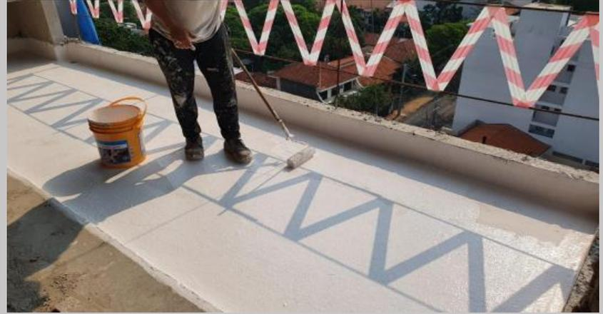
Aislación de la losa de los balcones
