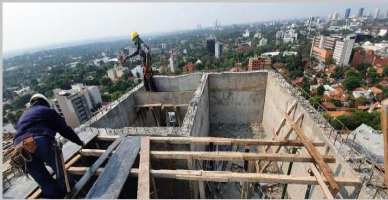
Encofrado losas tapa del tanque y tapa de caja de ascensores
