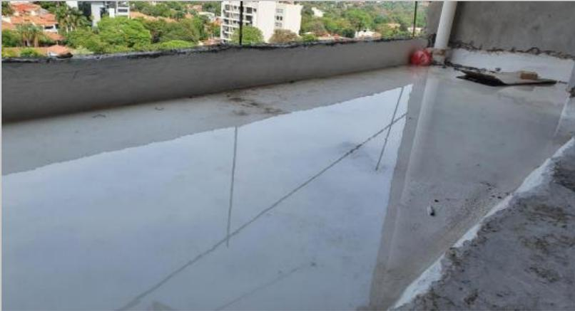
Prueba de agua de la aislación en balcones por 48 hs
