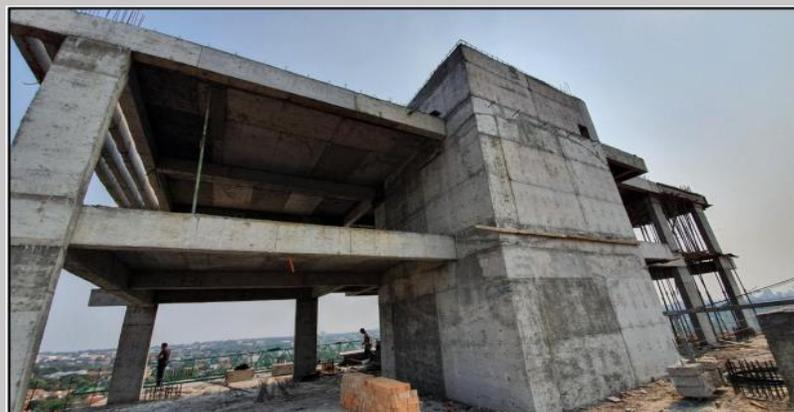
Losa del piso gimnasio/sauna – su losa techo y tabiques del tanque de agua hormigonados
