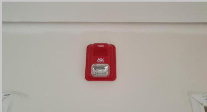
Instalación del pulsador de alarma audio visual en palieres
