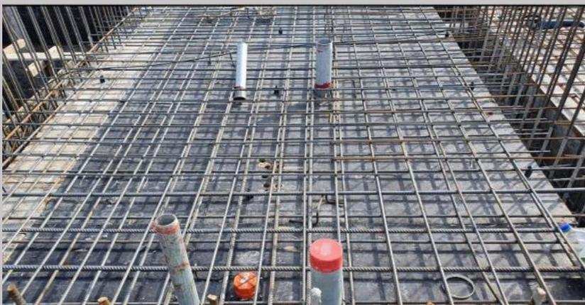
Losa fondo del tanque de agua con los pasantes hidráulicos previos al hormigonado.
