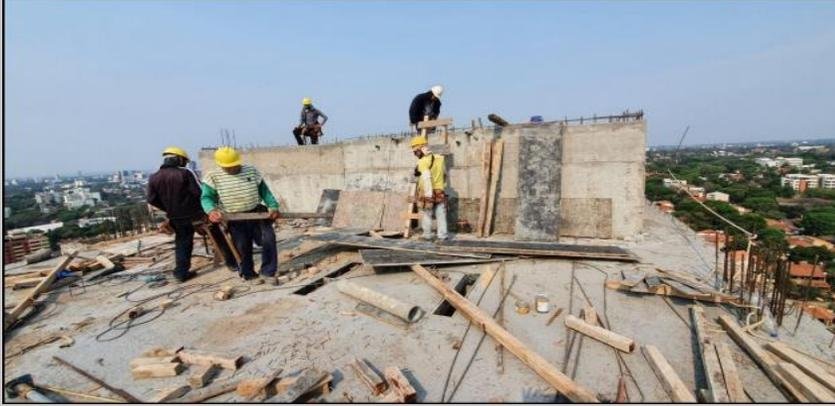
Tabiques del tanque de agua ya desencofrados
