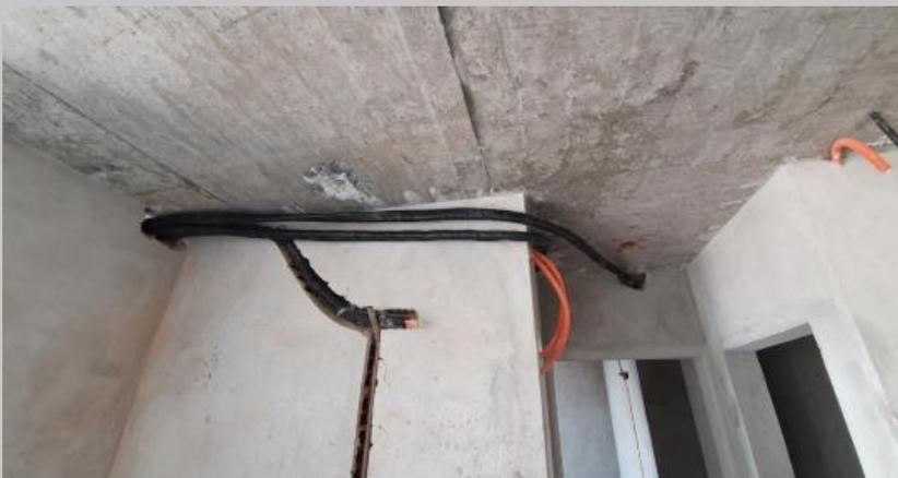
Ducteado de AA y desagüe en el 7C
