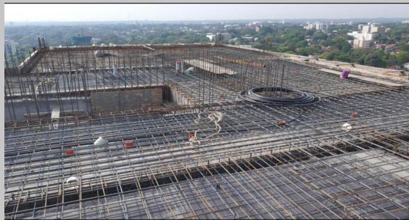
Losa sector gimnasio y sauna –losa fondo tanque ya listas para la carga
