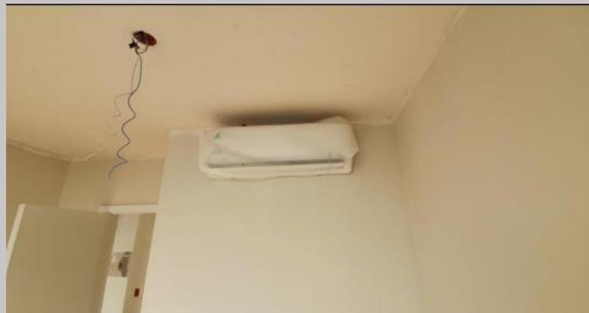
Montaje de evaporadores en el piso 3
