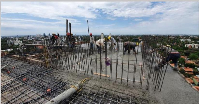
Hormigonado de la losa piso del gimnasio - sauna
