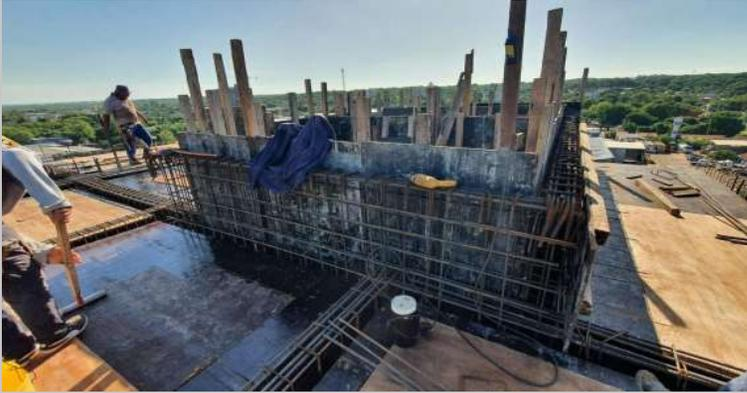
Armado de vigas de losas y tanque superior de agua
