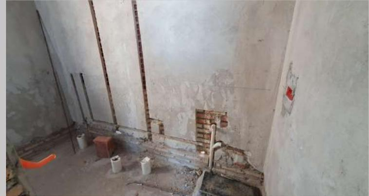
Desagües e inicios de replanteo instalación de agua en baños piso 2
