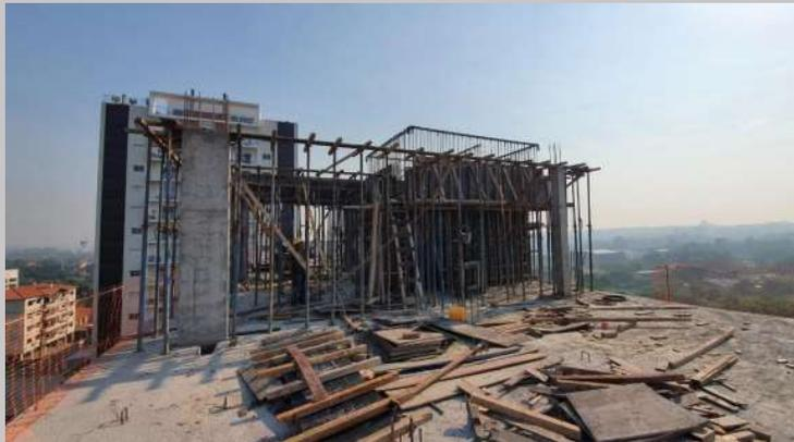
Avance del encofrado de losa quincho, caja de escalera y armaduras tanque superior
