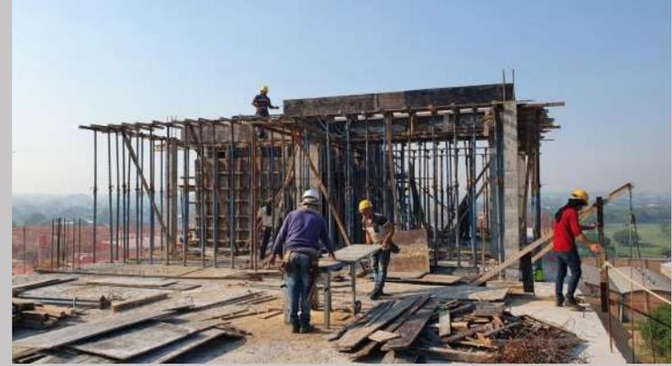
Encofrado losa techo de quincho
