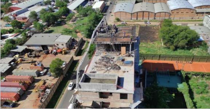
Hormigonado de la losa techo del quincho azotea
