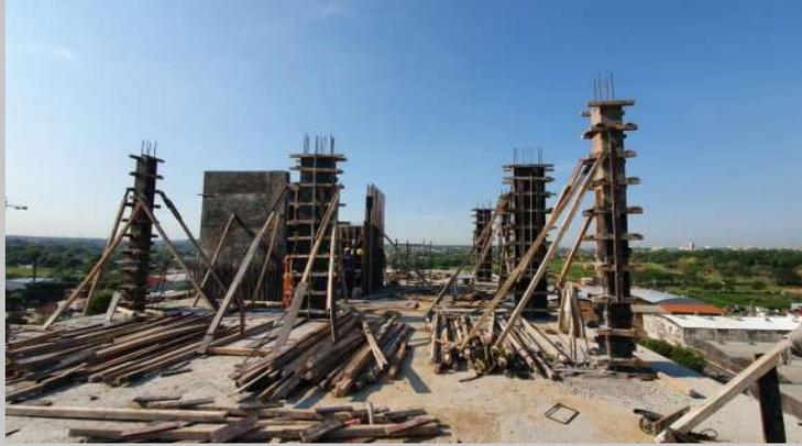
Armadura y encofrado pilares para quincho y tabique caja de escalera y ascensor
