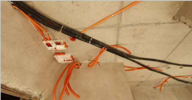
Ducteado de AA y electroductos bajo losa techo piso 2
