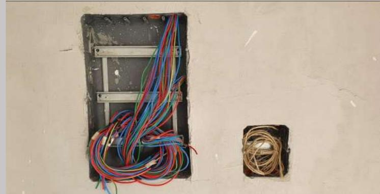
Cableado de los circuitos en el 1A
