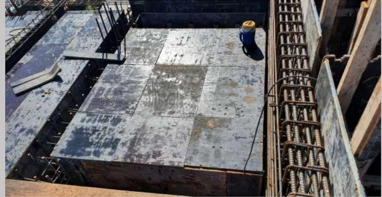
Encofrado losa tapa de ascensor
