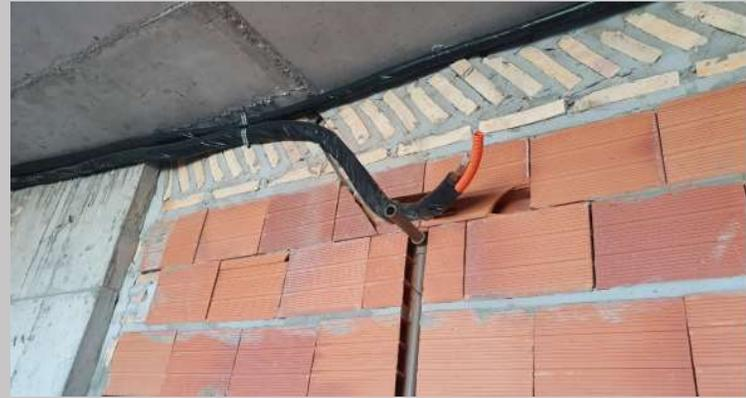
Ductado de las líneas de alimentación de cobre y desagüe para AA piso 3
