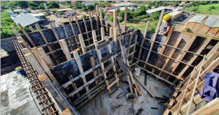
Encofrado tabiques tanque superior
