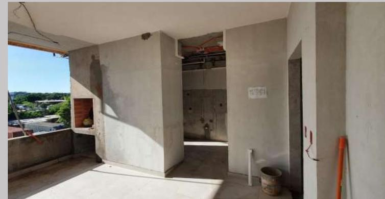
Piso, enduido de paredes y losa, cableado 1G
