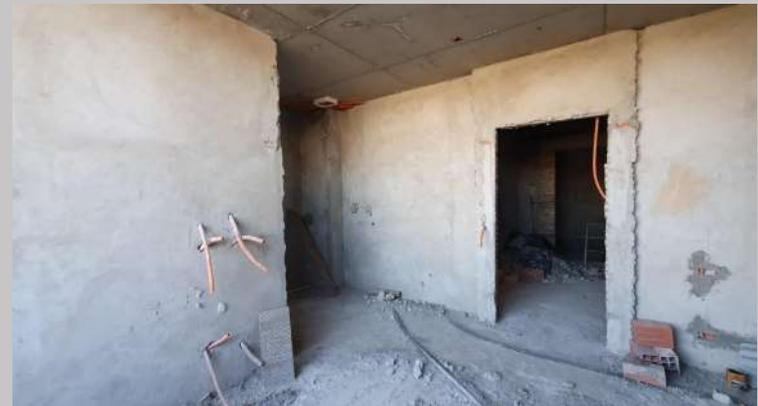
Revoque e instalación de electroductos 2D
