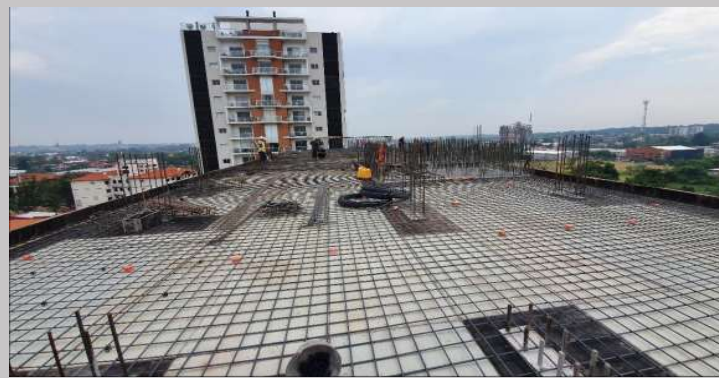
Encofrado y armado losa azotea y arranque de piscinas
