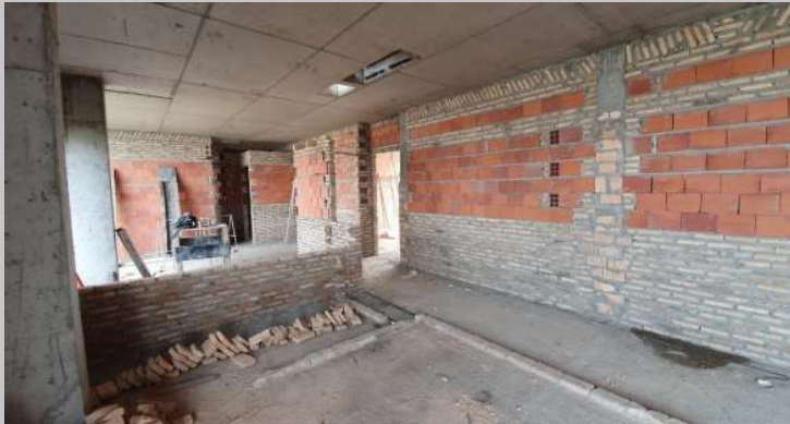
Avance de los cerramientos de mampostería piso 3
