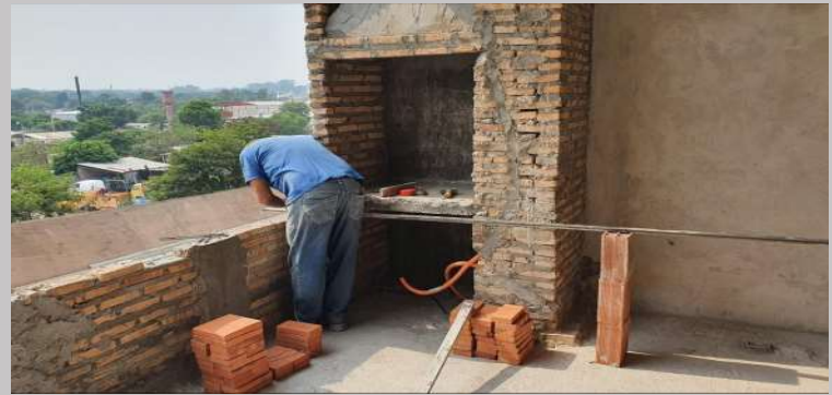
Vista del avance en las parrillas del segundo piso
