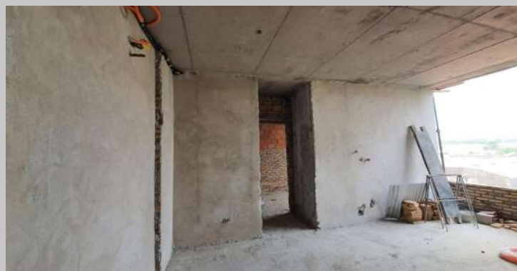
Avance del revoque interior en piso 2
