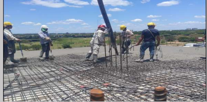
Hormigonado losa piso de azotea
