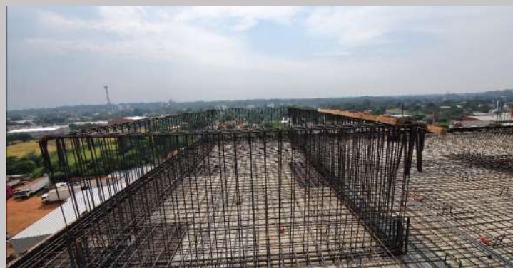
Armadura de la piscinas en la azotea
