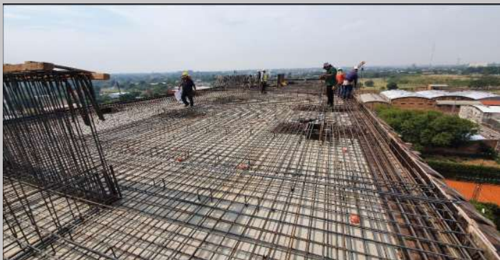
Armadura y encofrado losa piso azotea ya lista para ser hormigonada
