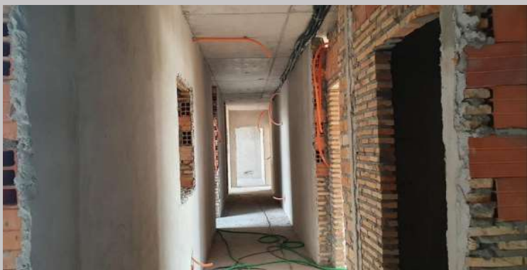
Una vista actual de la zona del palier piso 2
