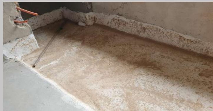
Aislación de losas de balcones piso 1
