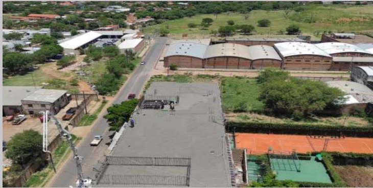
Losa piso azotea ya hormigonada
