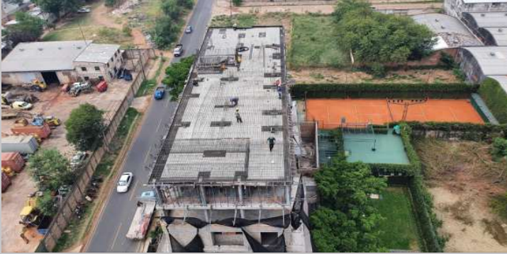
Vista del nivel de losa azotea antes de ser hormigonada
