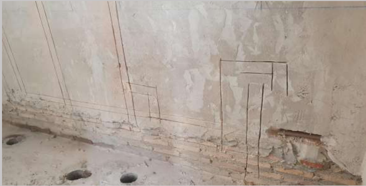
Replanteo para inicio de la instalación de agua en baños del piso 2
