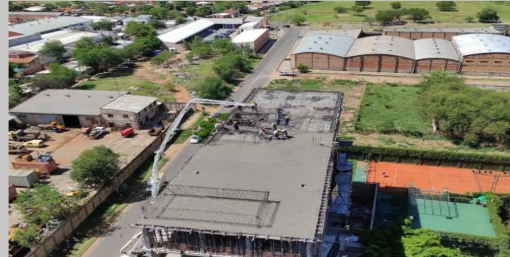
Una vista del avance en el hormigonado
