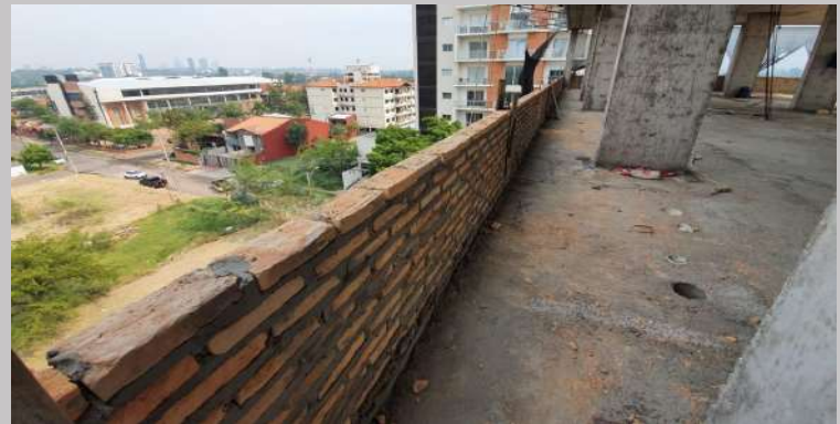
Parapeto perimetral piso 4
