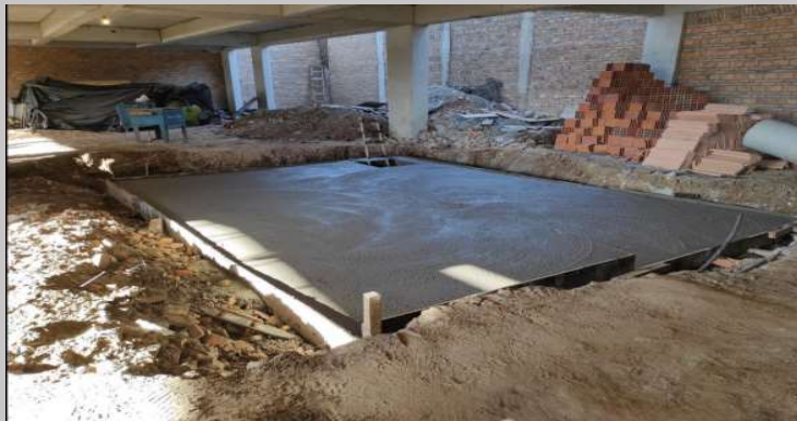
Tapa de tanque ya terminada
