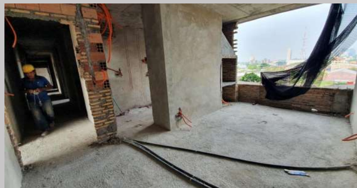
Vista actual del avance en el revoque dptos. Del piso 2
