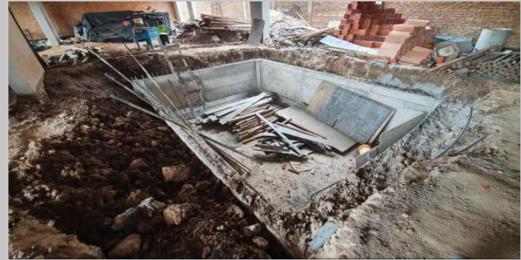
Tabiques y losa fondo del tanque de agua inferior
