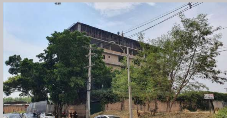
Vista actual de la fachada posterior
