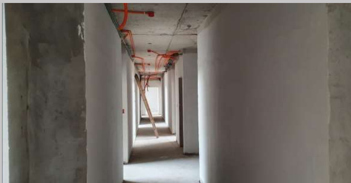
Enduido de paredes una mano piso 1
