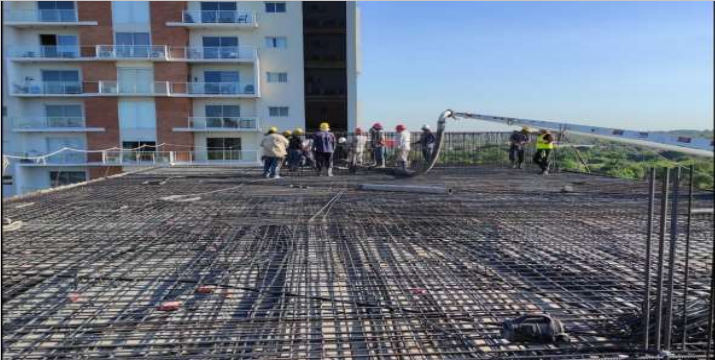
Hormigonado del nivel de azotea
