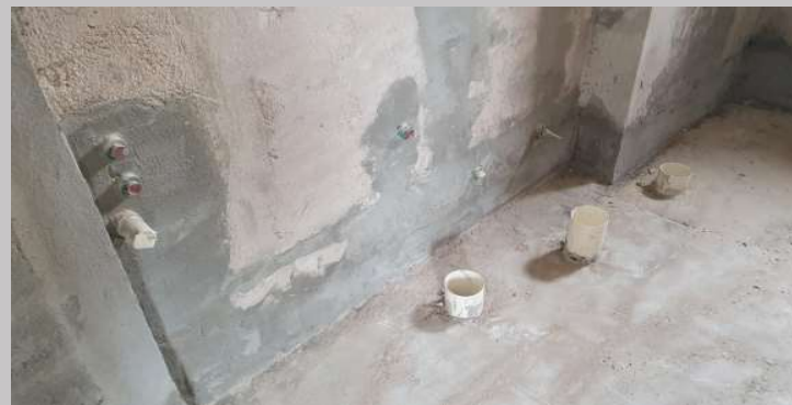
Instalación de agua y desagües baños piso 1
