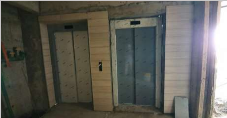
Revestimiento frente ascensores en el piso 8
