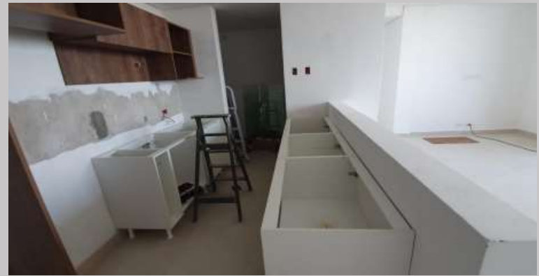
Montaje mueble de cocina en el 5B
