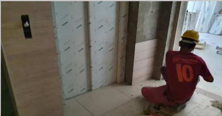
Revestido frente ascensores piso 5
