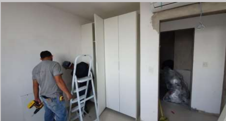
Montaje de placares en el 5ª
