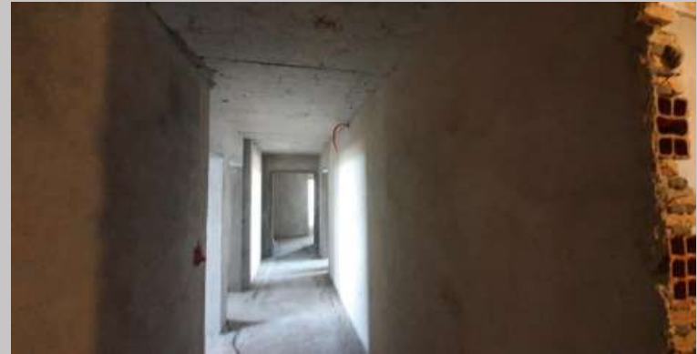
Vista actual palier del piso 7
