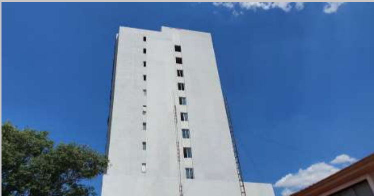
Vista de la fachada lateral derecha
