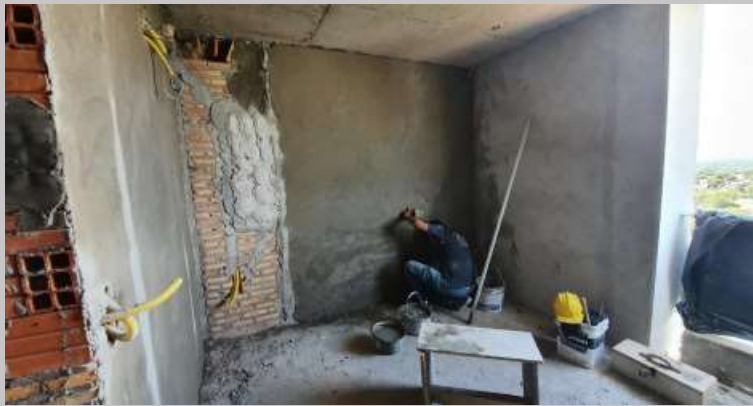
Inicio del revoque en el piso 8
