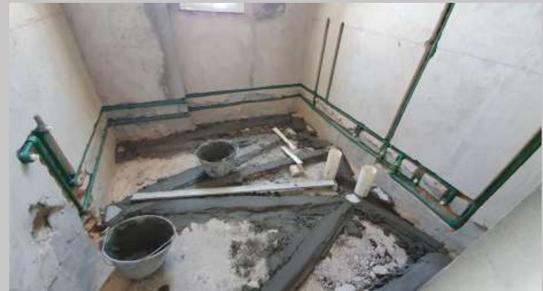
Instalaciones en baños y carpetas en baños del piso 7
