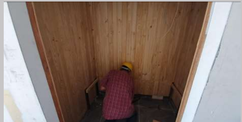
Avances en el montaje del sauna
