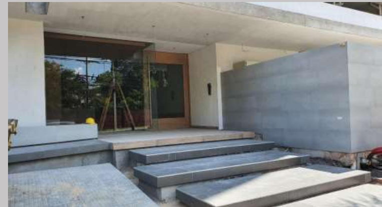
Terminaciones sector acceso principal
