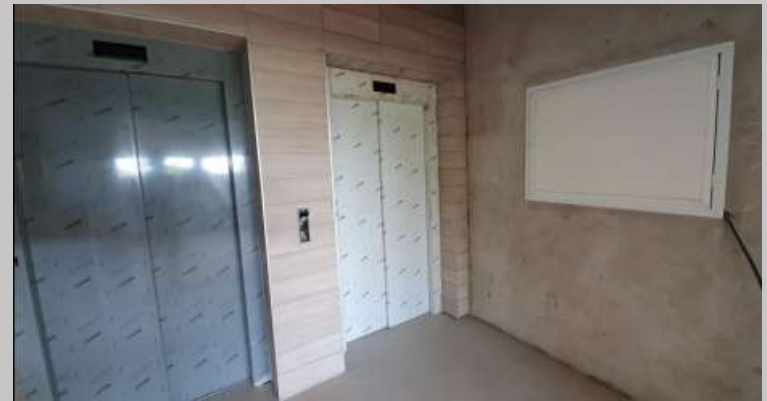
Revestido sector ascensores en el piso 3
