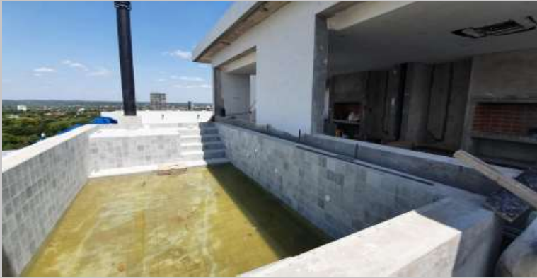
Piscina con revestimiento terminado
