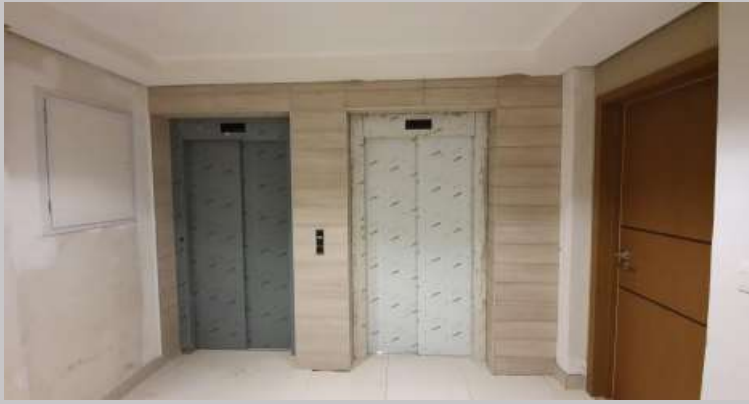
Revestido frente ascensor piso 1
