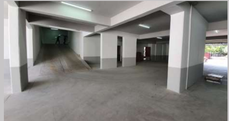
Sector circulación y acceso a estacionamiento
