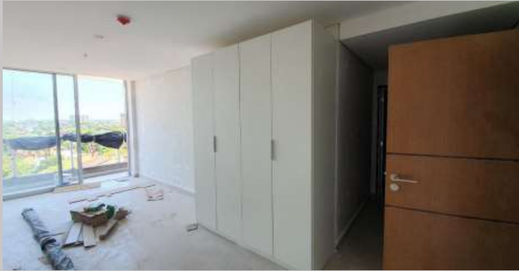
Montaje de placar en el 4E
