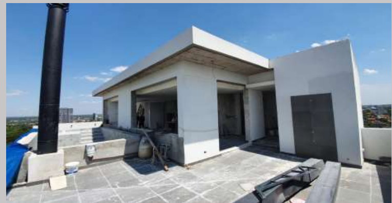
Vista del avance actual
