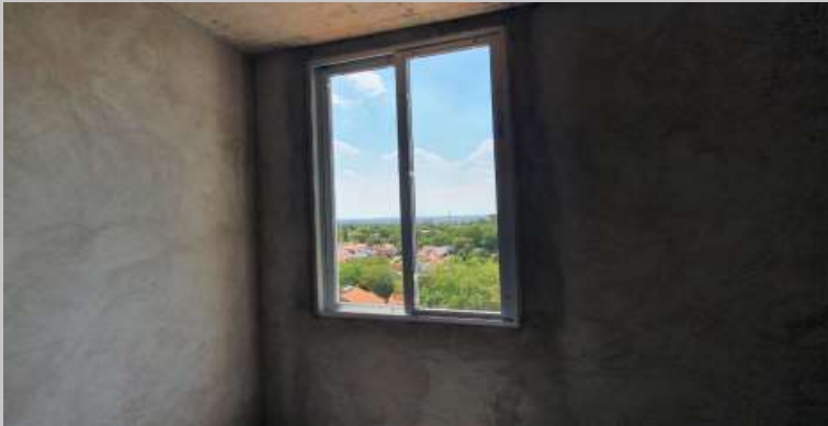
Aberturas en el 7º
