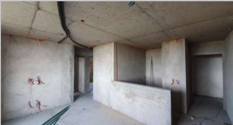
Revoque de paredes interiores en el 7C
