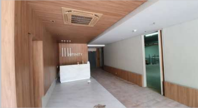
Trabajos en sector de la recepcion
