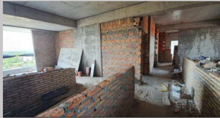
Cerramientos de mampostería en piso 9
