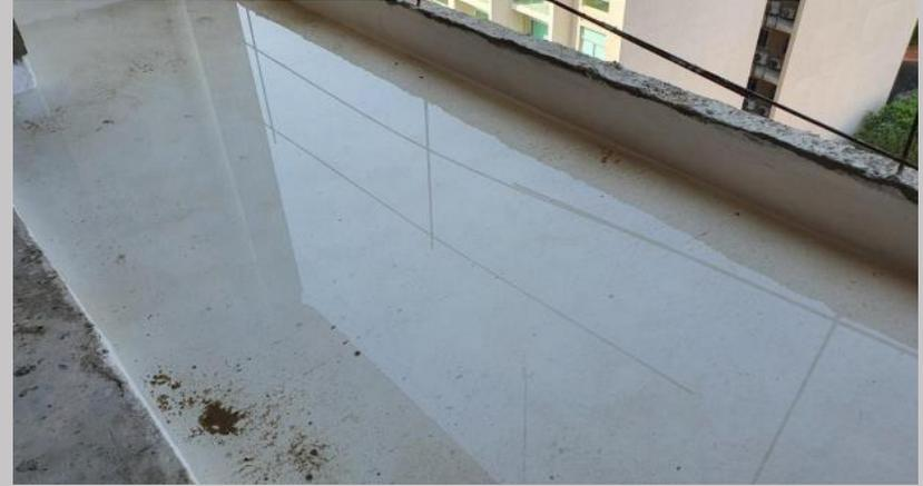
Prueba de agua en balcones del piso 6
