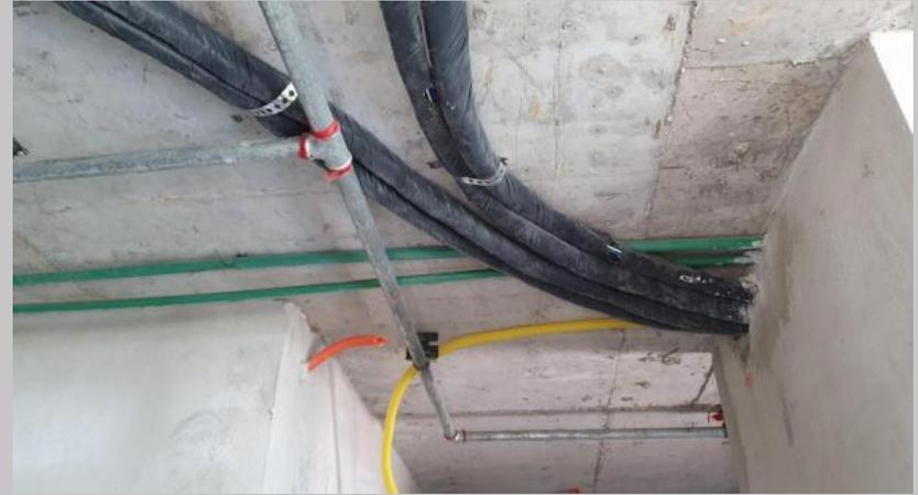
Instalaciones de AA, PCI e hidráulica para el piso 6
