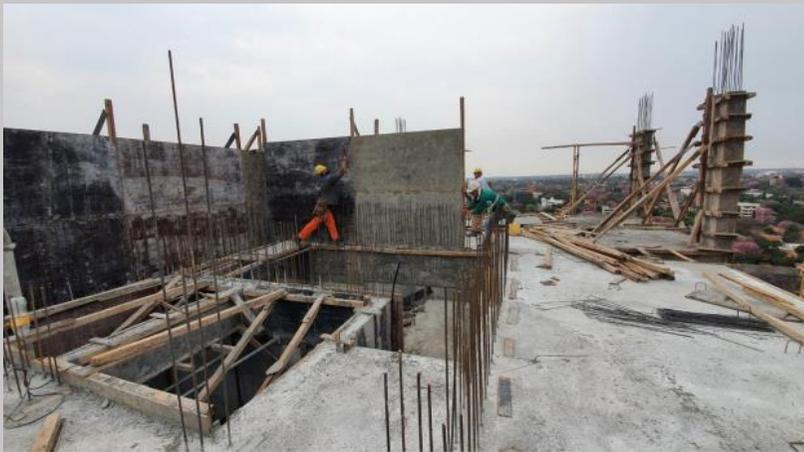
Trabajos sobre losa techo de quincho ya hormigonada- tabiques y pilares
