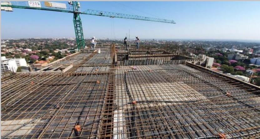
Armaduras e instalaciones para la losa techo de quincho (piso gimnasio- sauna)
