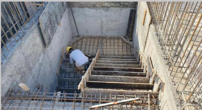
Encofrado y armaduras para la losa piso sobre quincho
