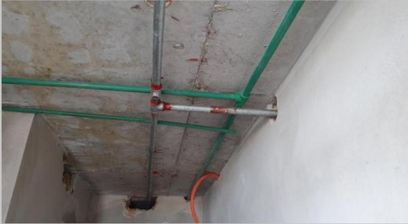
Tenido hidráulico y de PCI en el piso 7
