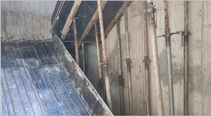
Encofrado y armaduras para el siguiente tramo de la escalera
