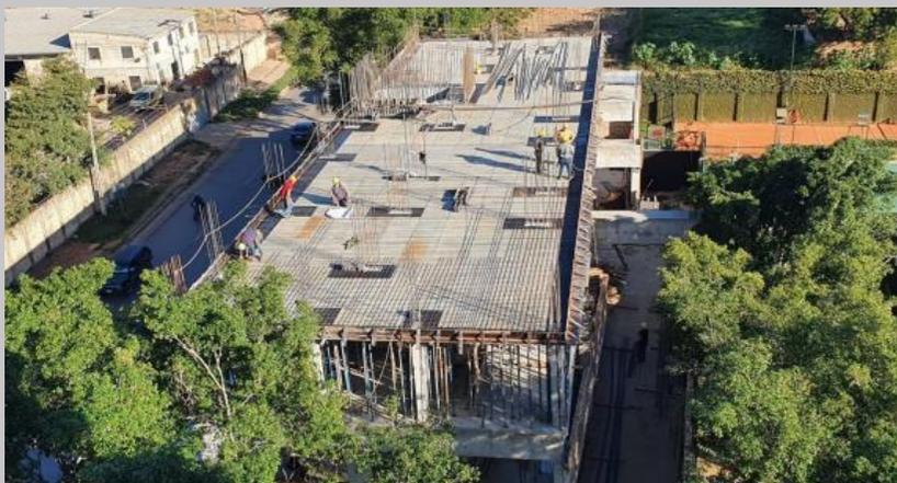
Encofrado y armado de la losa del segundo piso
