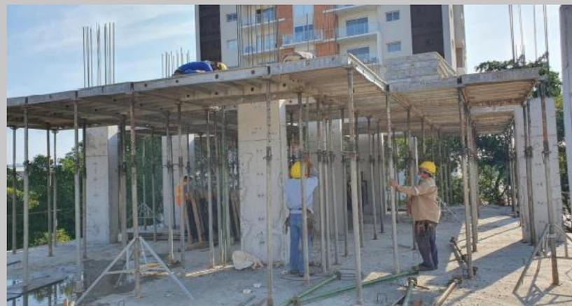
Inicio del encofrado para la losa del segundo piso
