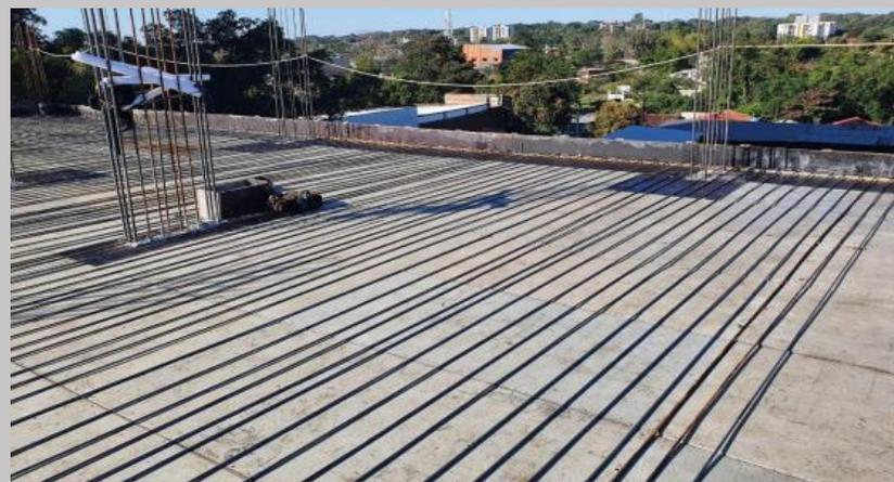
Armado inferior para la losa el piso 2
