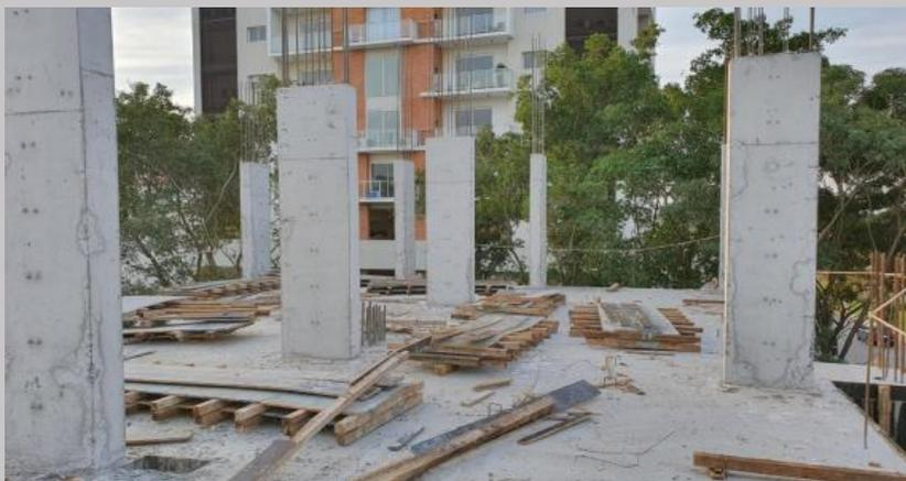
Pilares ya hormigonados hasta sus asientos de losa
