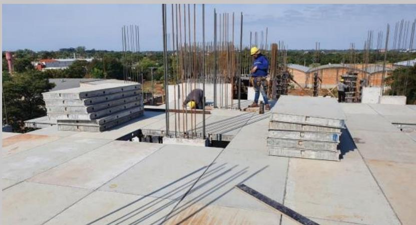
Encofrado de placas metálicas para los fondos de losa
