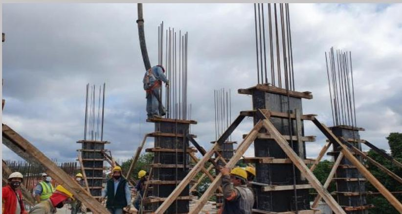
Jornada de hormigonado de los tramos de pilares para la losa del segundo piso
