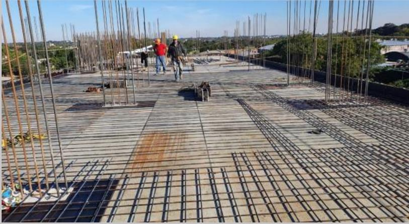
Trabajo actual de armado inferior de losa
