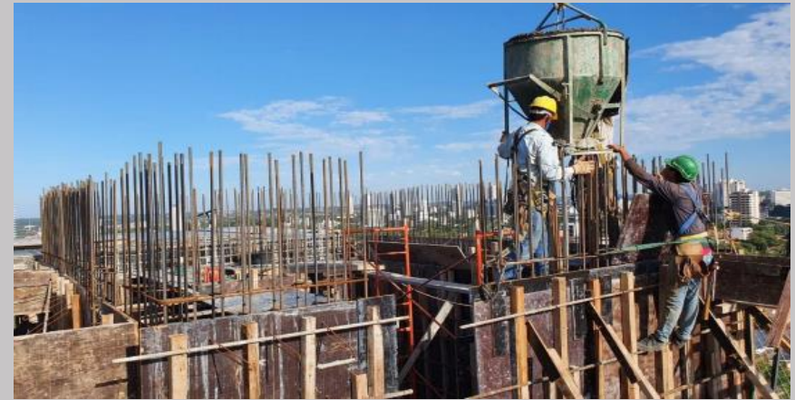
Hormigonado de los tabiques en su ultimo tramo
