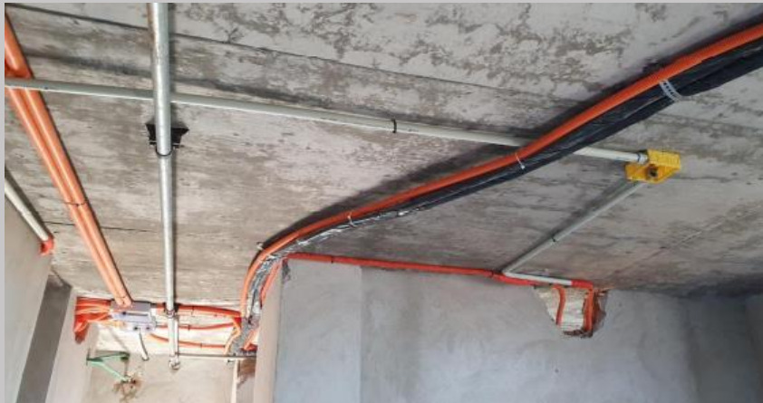
Avance de las instalaciones en el cuarto piso
