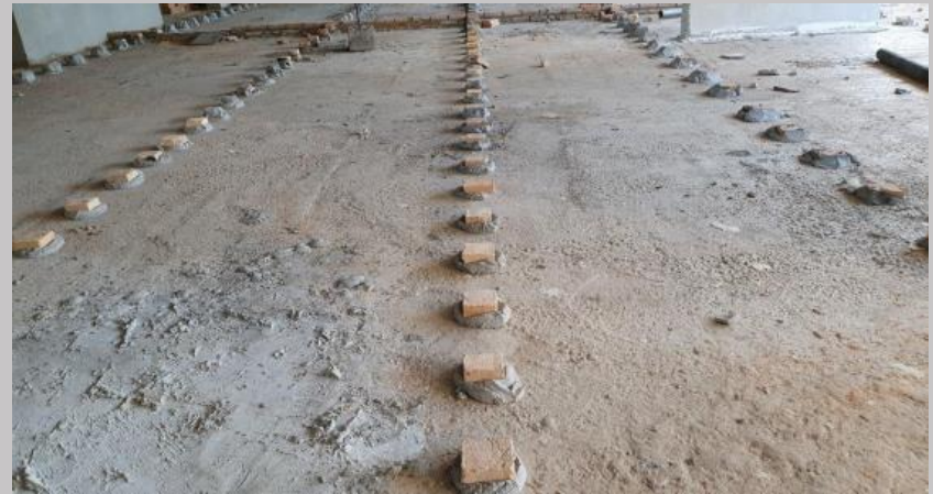
Replanteo de niveles de carga para contrapiso en E1
