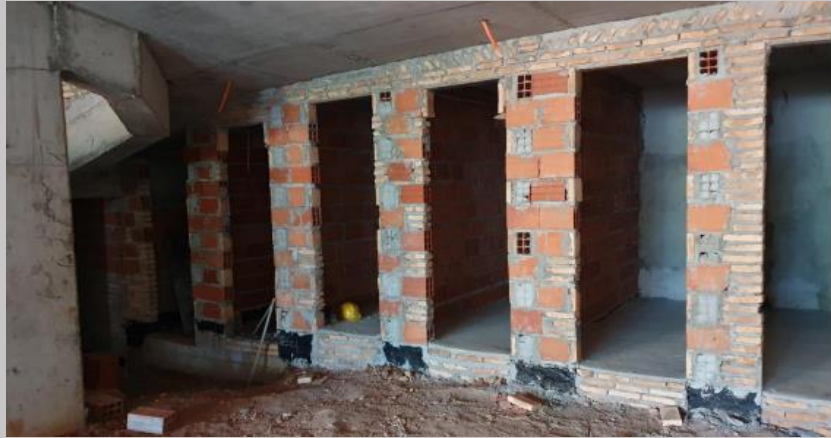
Bauleras bajo losa rampa de la planta baja
