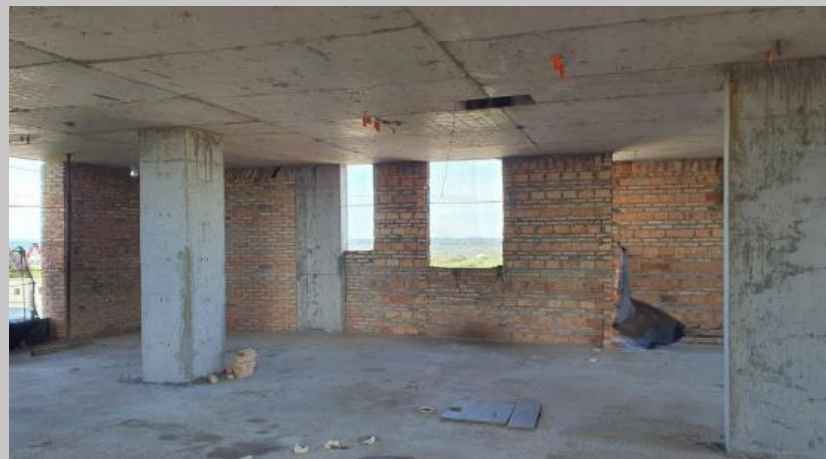
Mamosterías linderas piso 7
