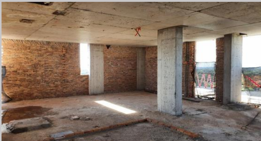
Mamosterías linderas piso 6
