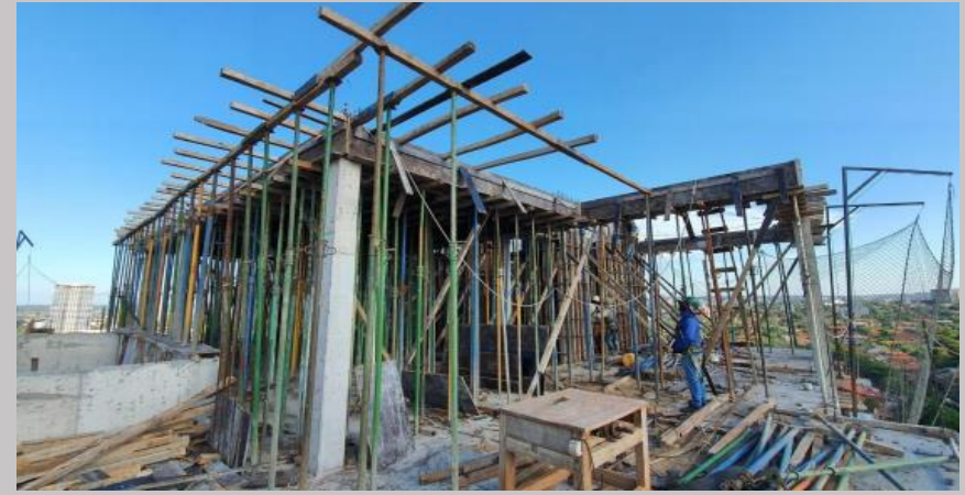
Avance del encofrado para las losas y vigas del techo quincho en azotea
