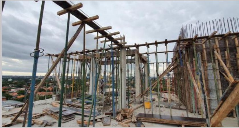
Inicio del encofrado losas y vigas quincho azotea
