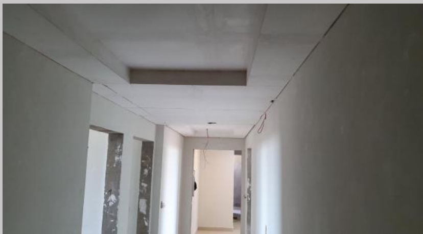
Vista actual del palier del piso 1
