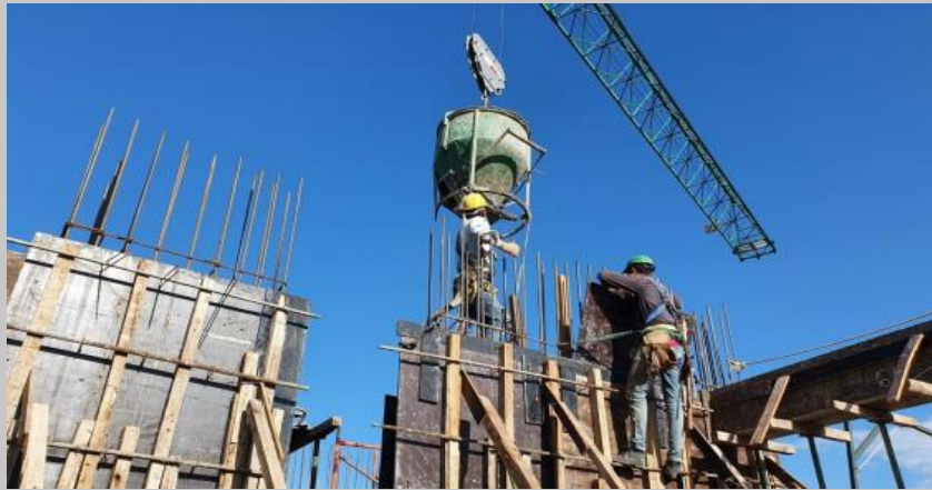
Hormigonado del tabique de caja de ascensores y escaleras
