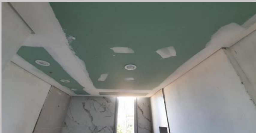
Placa hidrófuga de Durlock en baños piso 1
