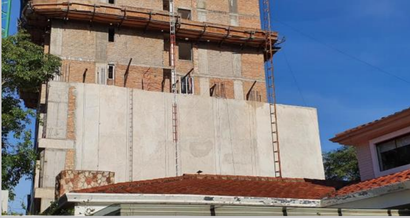
Vista del avance del revoque en una de las fachadas laterales
