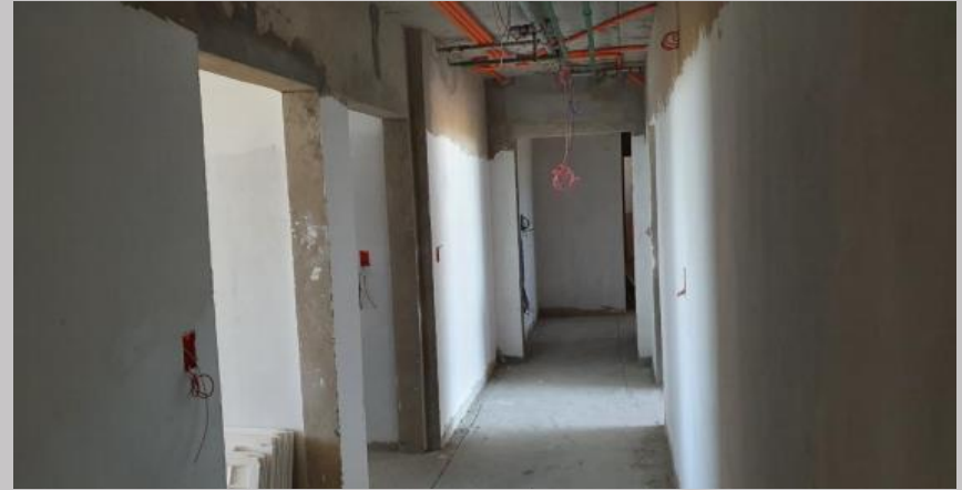
Vista actual del palier en el piso 3
