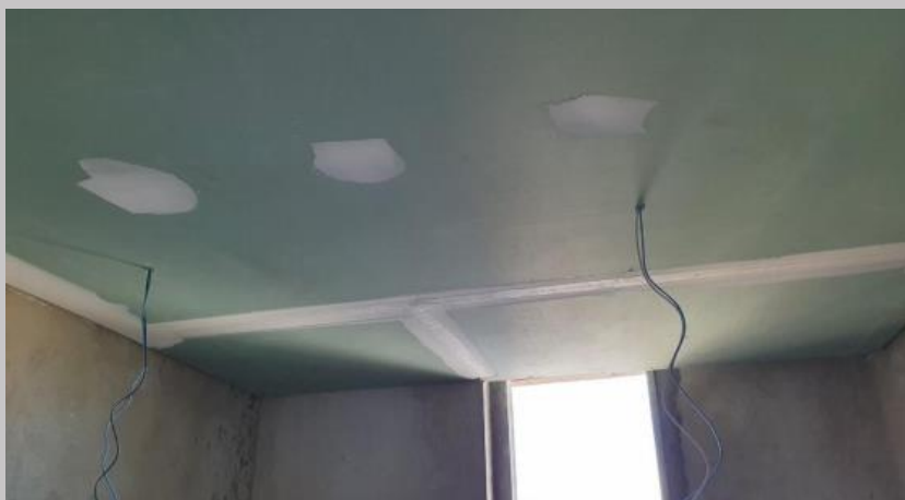
Cielorraso hidrófugo en baño del 2C
