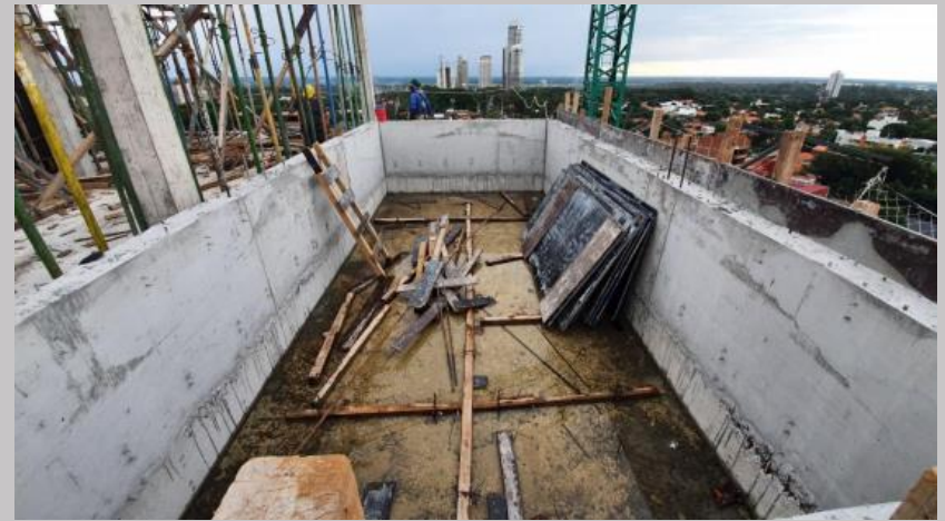
Tabiques y fondo de piscina ya hormigonados
