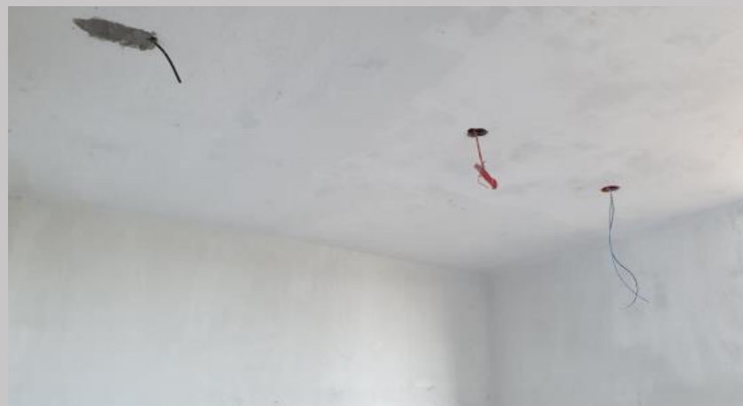
Enduido de primera mano en paredes y losa del 2E
