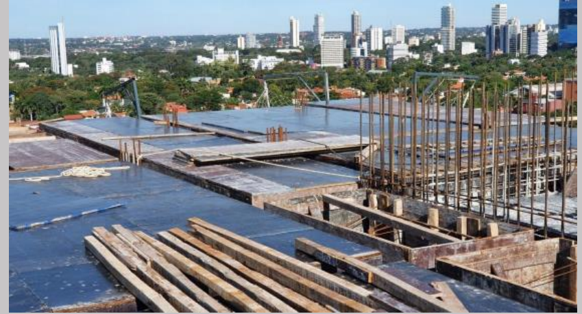
Fondos de losa y vigas techo quincho en azotea
