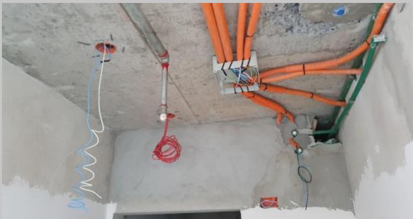
PCI, alimentación de agua y eléctrica bajo losas del piso 3
