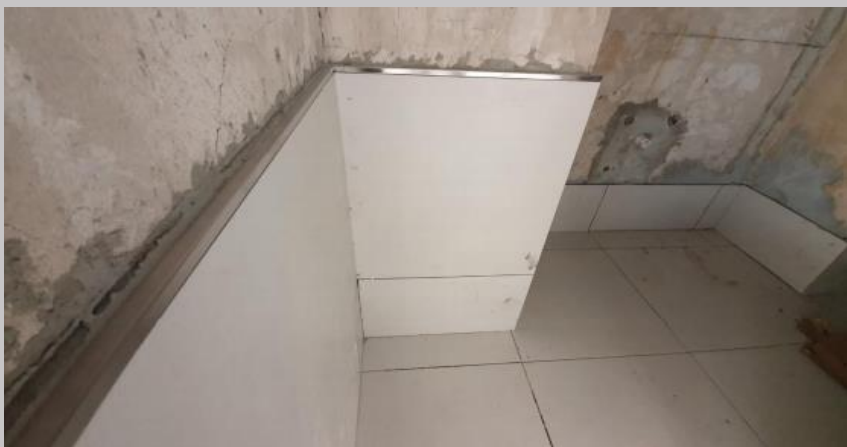
Detalle del listón de terminación en revestidos de los baños
