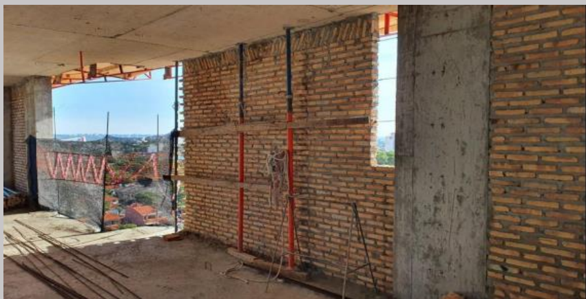
Cerramiento en linderos del piso 8
