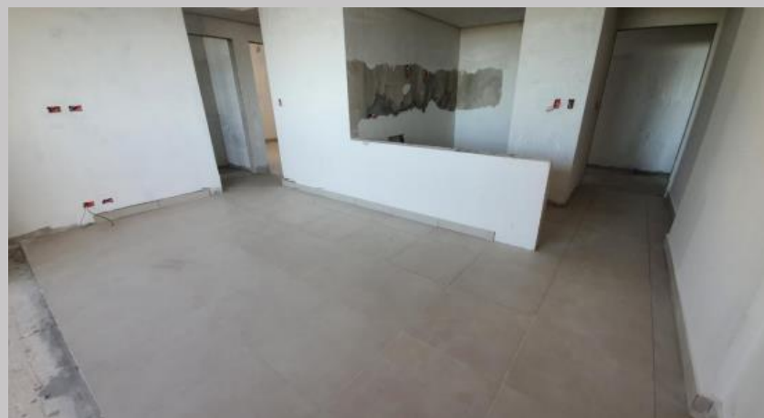
Colocación de piso en el segundo nivel de planta tipo
