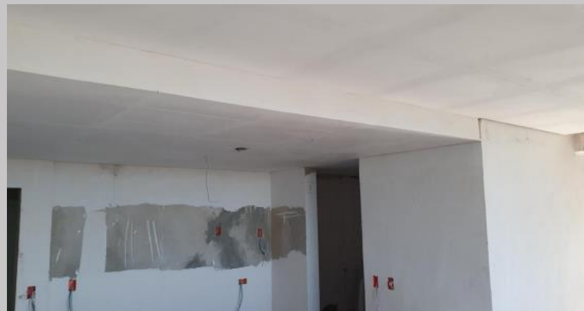
Cielorraso, cableado y enduido 1 mano en el 3B
