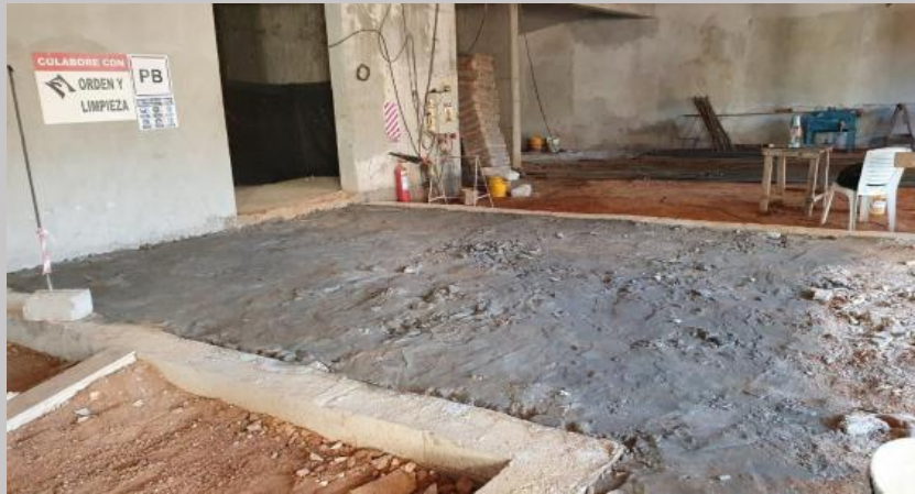
Un sector de contrapiso en planta baja
