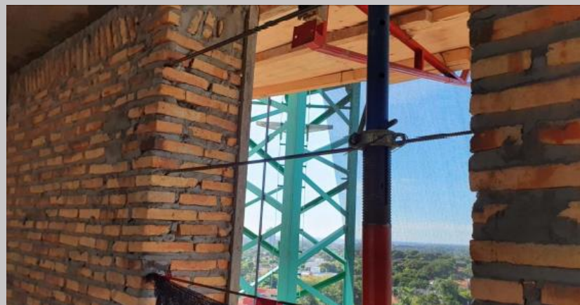
Una vista de las mamosterías linderas de 0,30 con común y envarilladas
