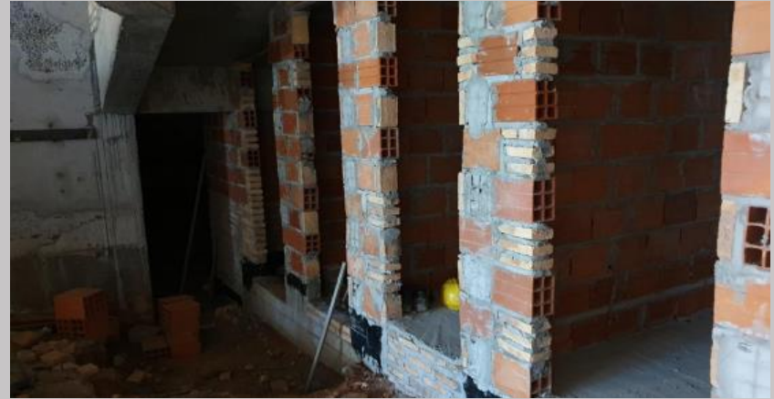
Bauleras, deposito y baño planta baja
