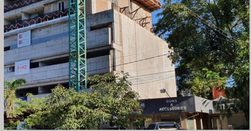
Revoque de fachada
