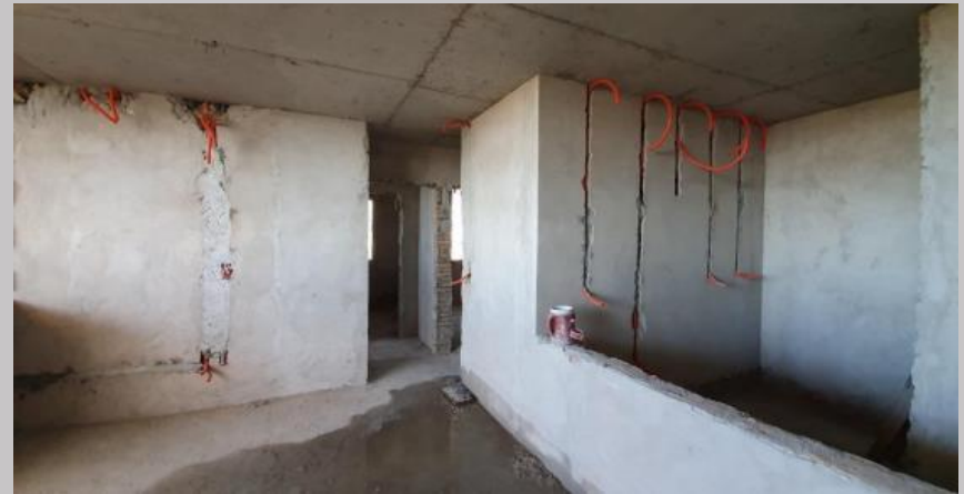
Revoque de paredes e instalaciones en el 5C
