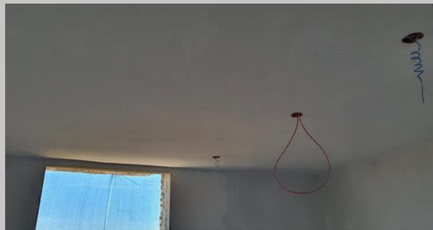
Enduido de paredes y fondo de losas tercer piso
