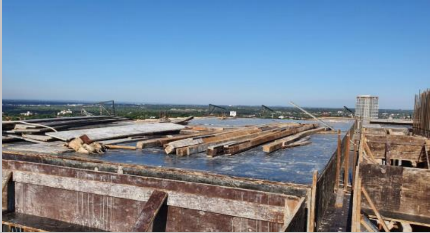
Encofrado losas y vigas techo quincho
