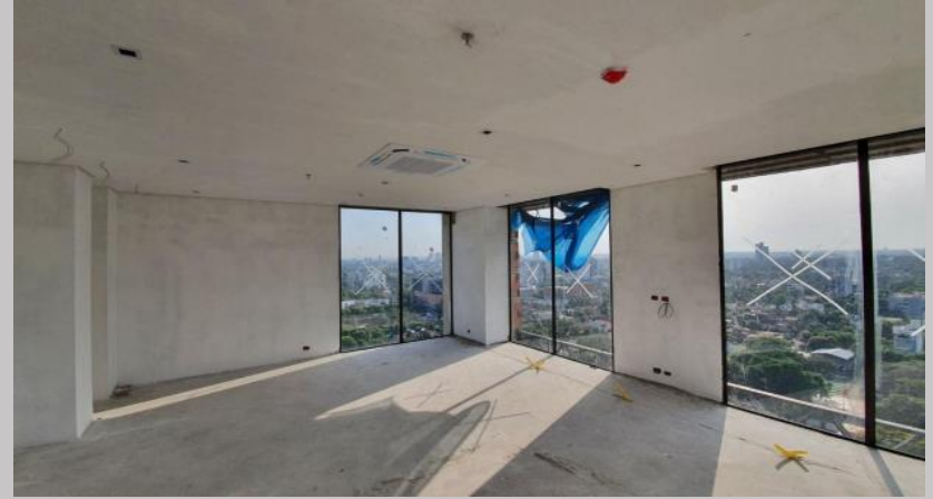
Azotea nivel 2- ambientes
