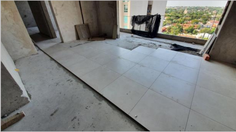
Colocación de piso en departamentos nivel 8
