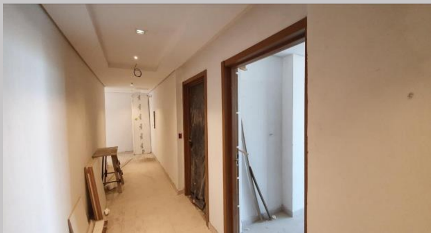
Avances palier piso 5
