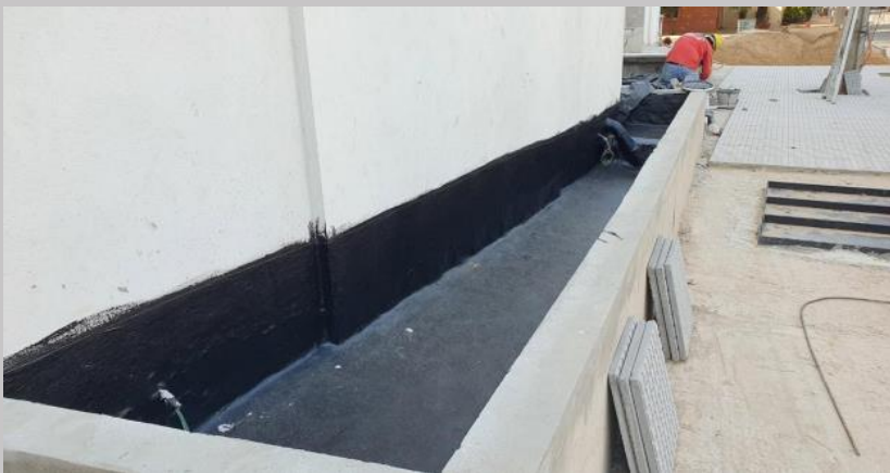
Canteros extintores y aislación
