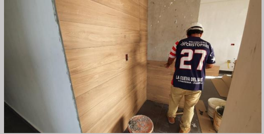
Avance en los revestimientos
