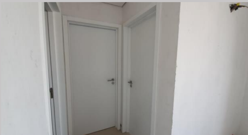
Puertas interiores piso 6
