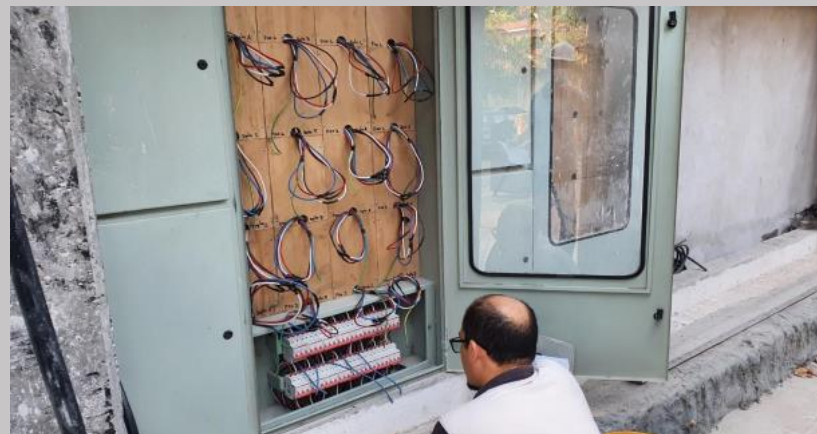
Trabajos de instalacion de llaves TM en gabinete de medidores Ande
