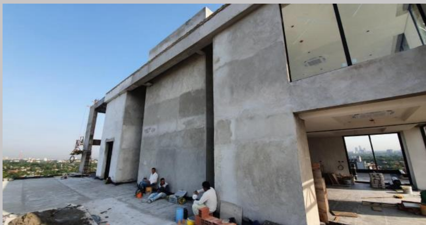
Vista desde exterior azotea 1
