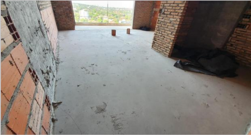
Contrapiso y carpeta piso 11
