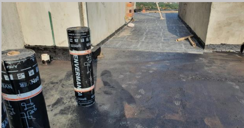
Aislación con membrana 4mm en azotea
