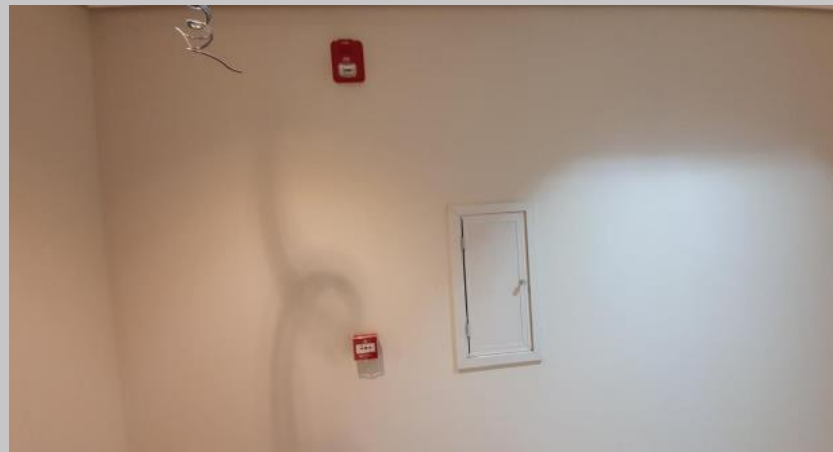
Pulsadores de alarma de PCI y alarma audio visual piso 4
