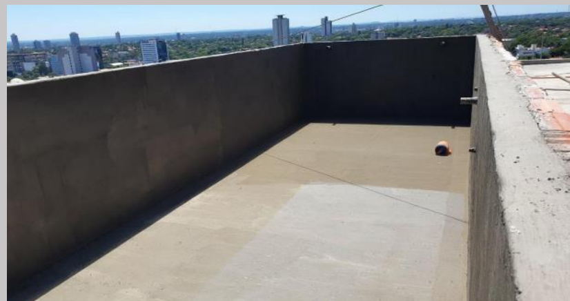
Aislación y pruebas de agua en piscina
