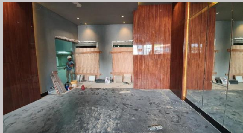
Terminaciones en recepción
