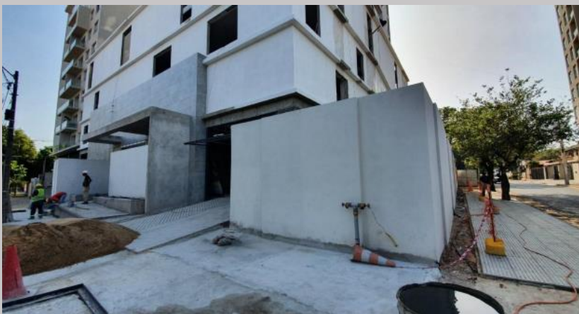
Trabajos de terminaciones en zona del acceso principal
