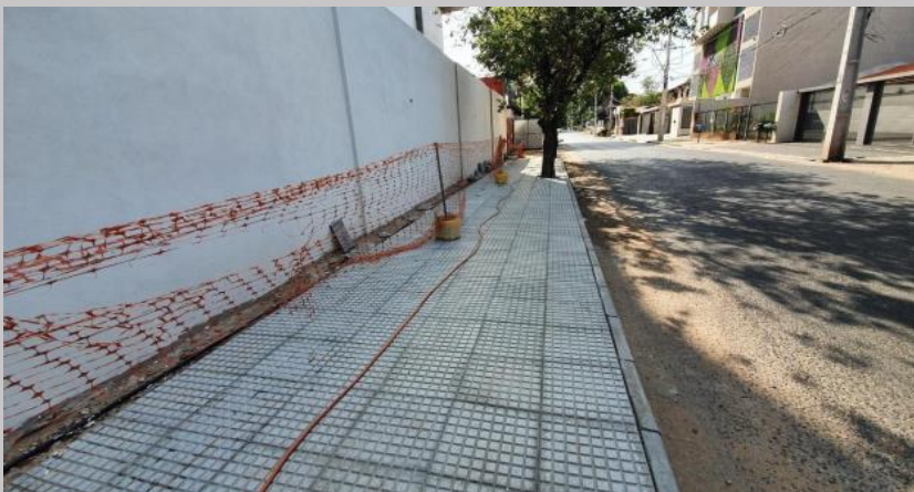
Colocación de piso vereda sobre Pacheco
