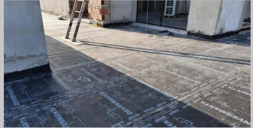
Trabajo actual de aislación en exterior de azotea nivel 1
