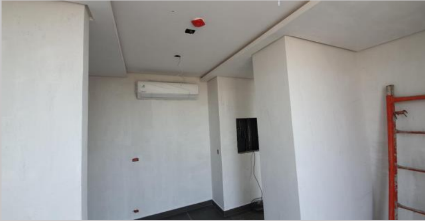
Piso, cielorraso, instalaciones y enduido en ambientes de azotea 1
