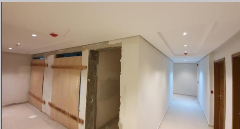
Vista actual avances en palier del piso 4
