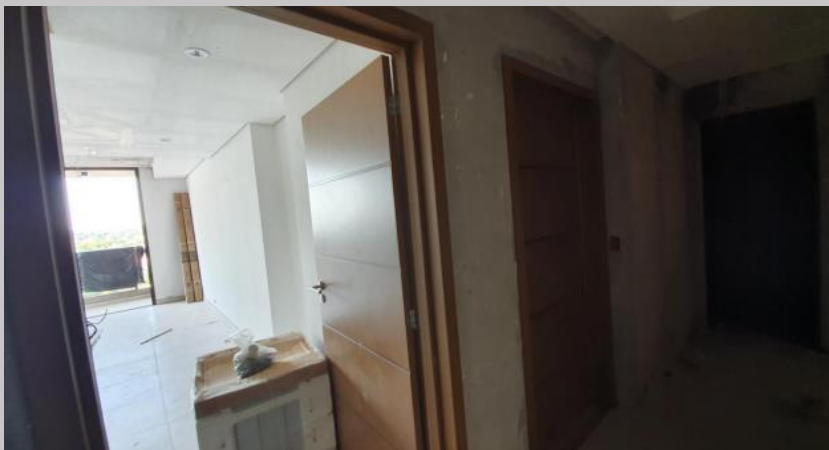
Puertas en el piso 6
