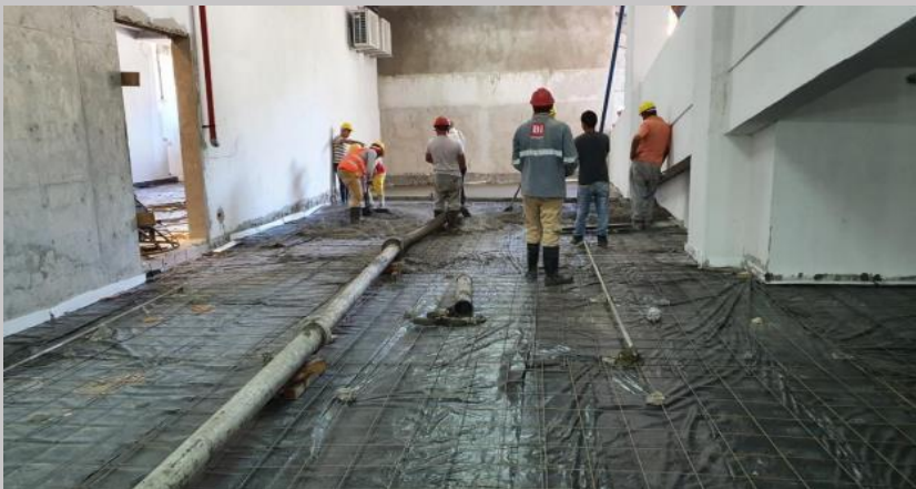
Piso de hormigón en sector estacionamiento de PB
