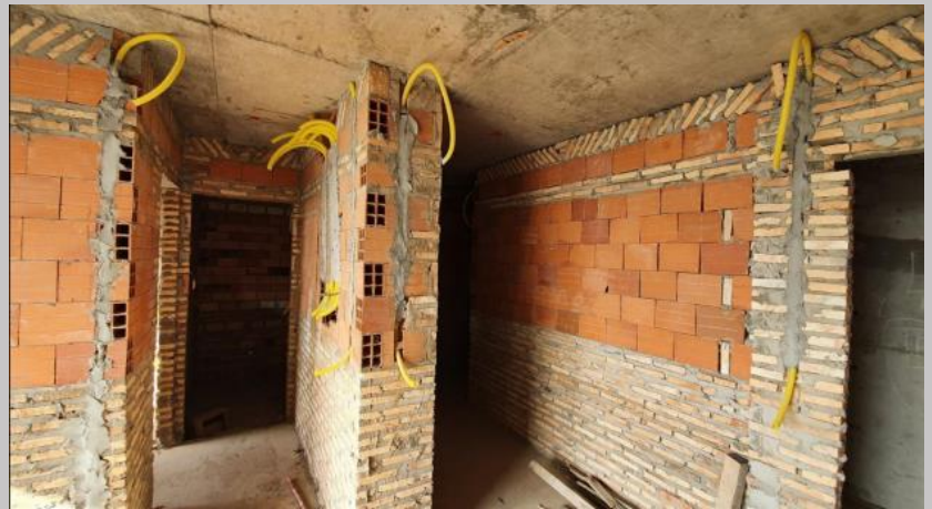
Cerramiento de mampostería en el 9E
