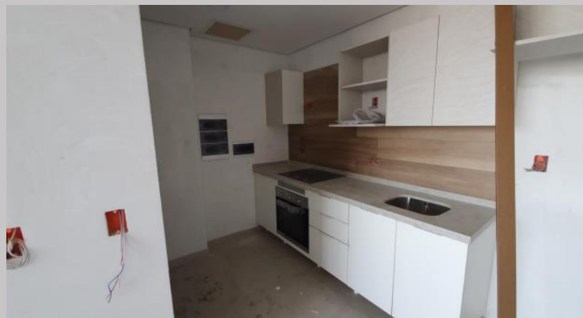
Montaje muebles de cocina en el 5C
