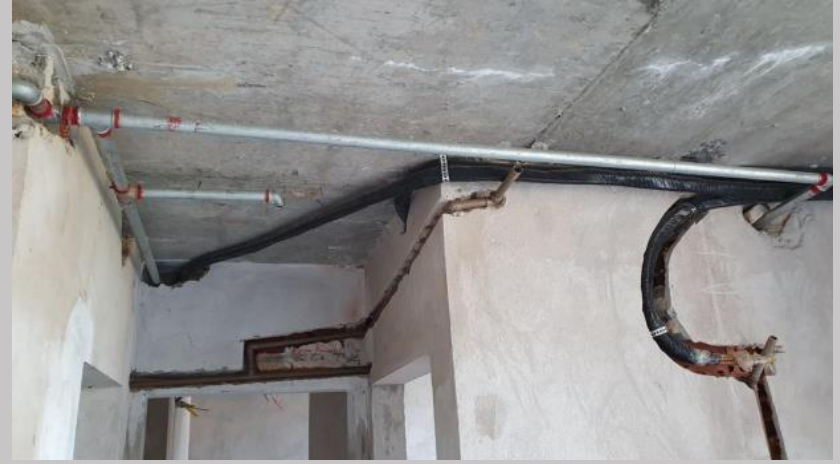
Instalaciones AA y PCI piso 8
