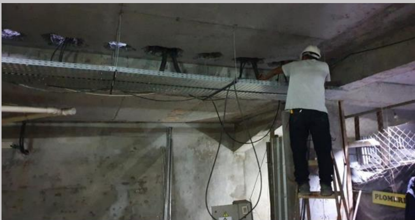
Tendido de cables en bandeja hacia PD Ande y Trafos
