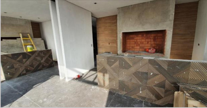
Piso y revestimientos sector parrilla azotea 1
