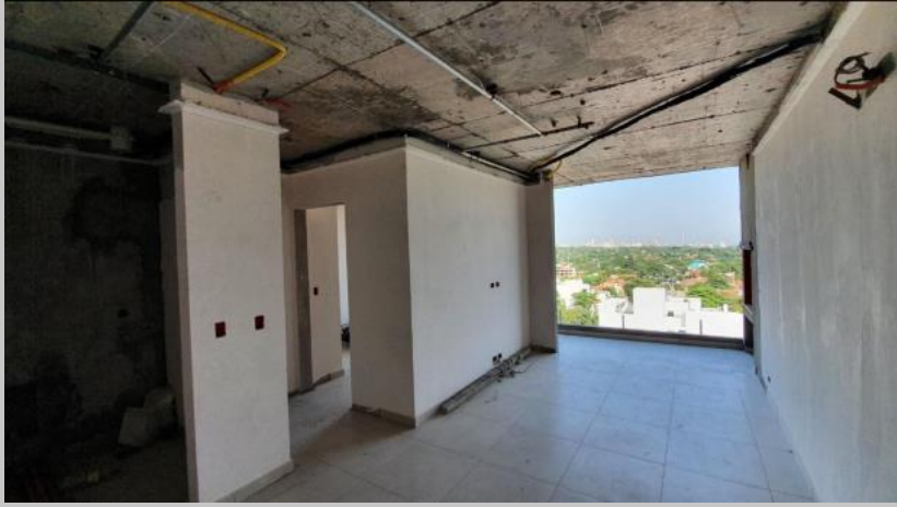
Piso, enduido e instalaciones en el 7B
