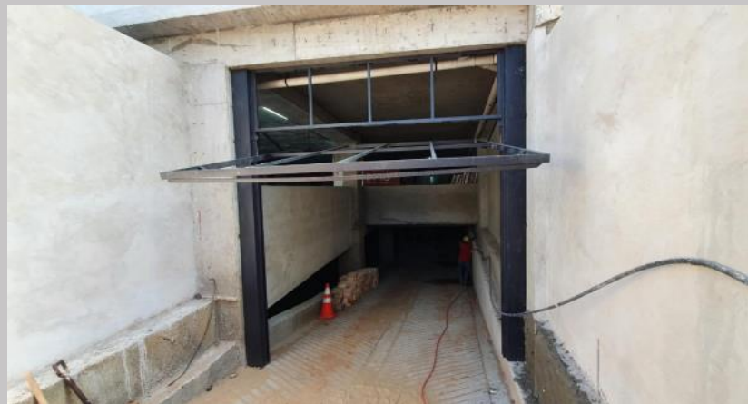
Portones basculantes en acceso SS y PB
