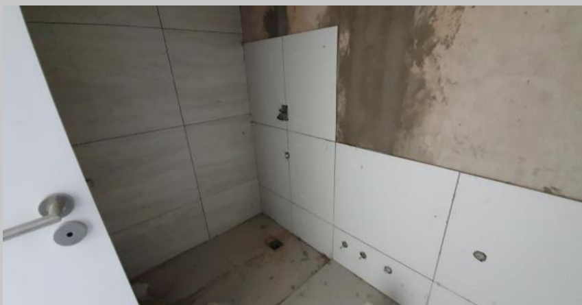
Revestido de baños piso 6
