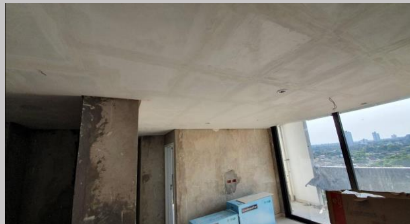
Cielorraso en el 6F
