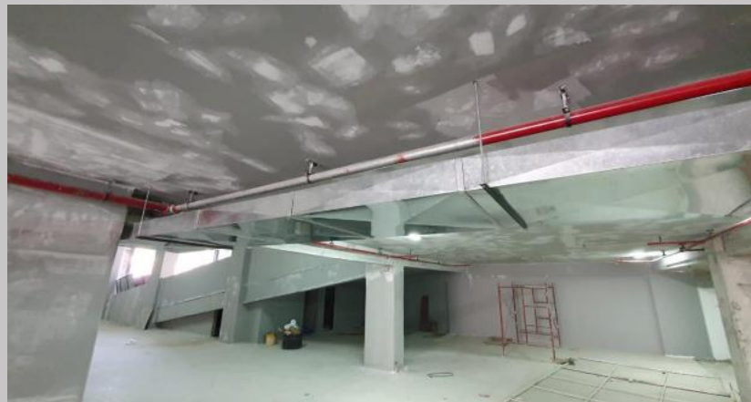
Ductos para presurización de caja de escalera
