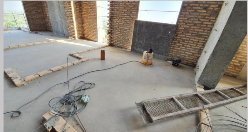
Contrapiso y carpeta en el piso 12
