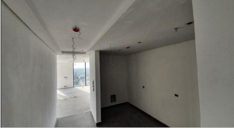
Vista actual ambientes del nivel de azotea 2 y sus terminaciones
