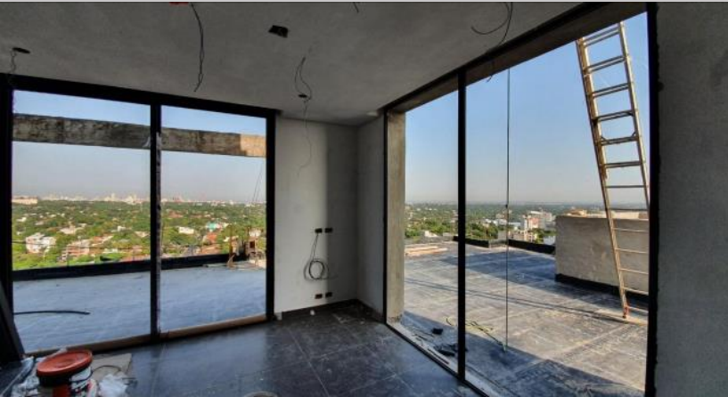
Avance en sectores de azotea nivel 1
