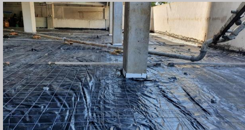
Trabajos de piso de hormigón helicóptado en estacionamientos
