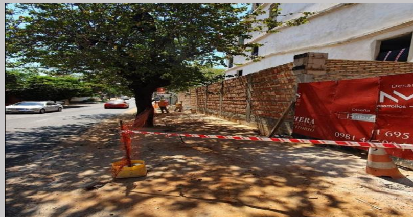
Inicio de trabajos en sector de vereda hacia Pacheco
