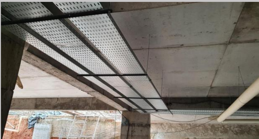
Montaje de la bandeja de cables a tableros y PD en sub suelo
