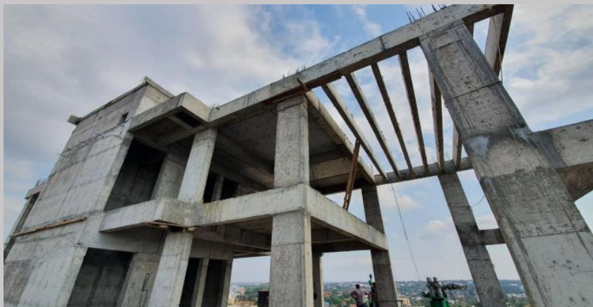
Estructura en altura- tanque de agua- tapa ascensores- 100% terminada
