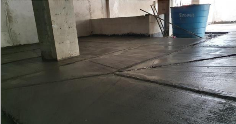
Carga de contrapiso y pendientes con hormigón aliviando en estacionamiento de PB
