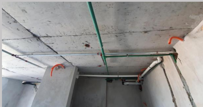
Tendido de PCI e hidráulica en el piso 6
