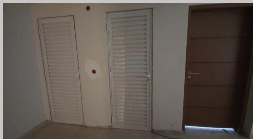
Terminaciones en sector de acceso a las baulera en palieres
