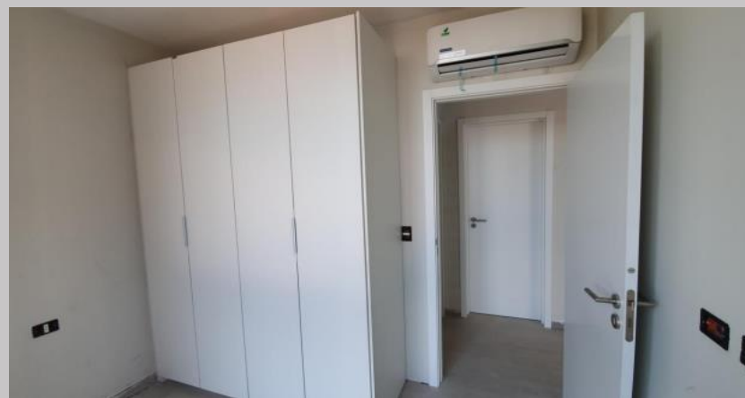
Montaje de placar, puertas y evaporador en el 2C
