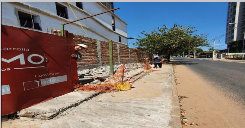
Preparación para configurar zona de vereda y niveles hacia calle Pacheco
