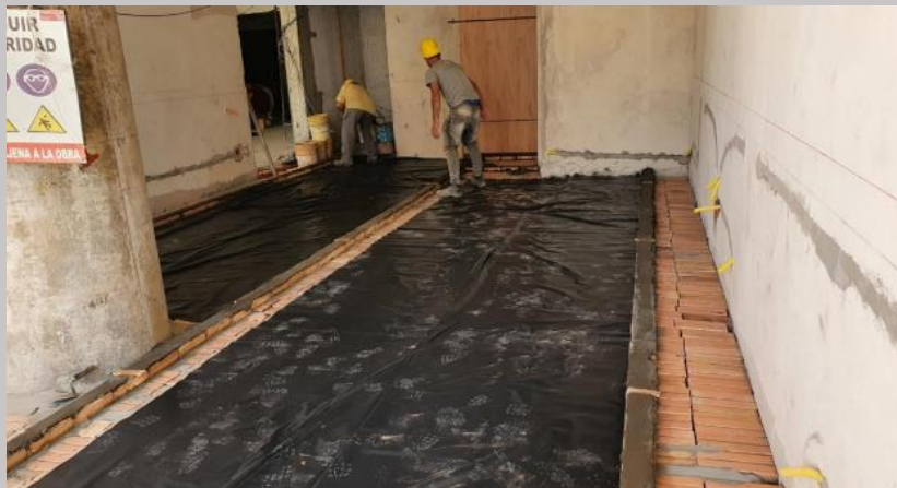
Preparación para carga de contrapiso hasta nivel piso terminado acceso de PB
