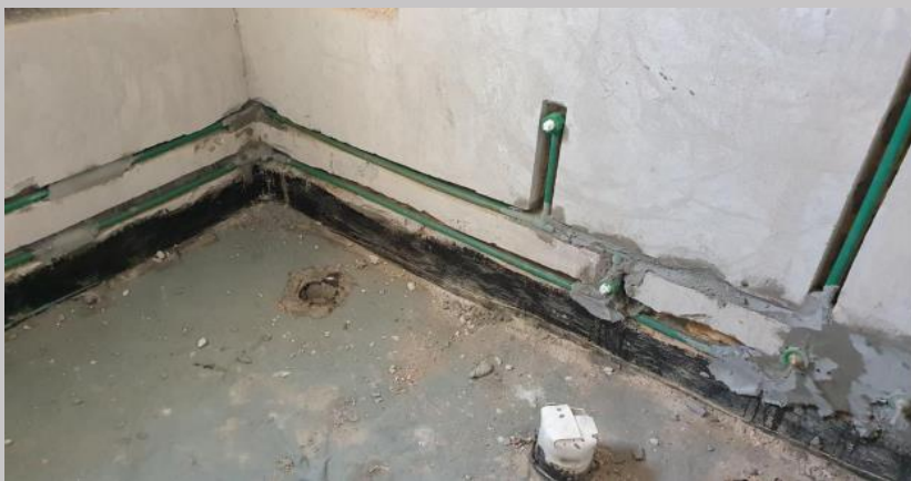
Desagües e instalación de agua en el 7F
