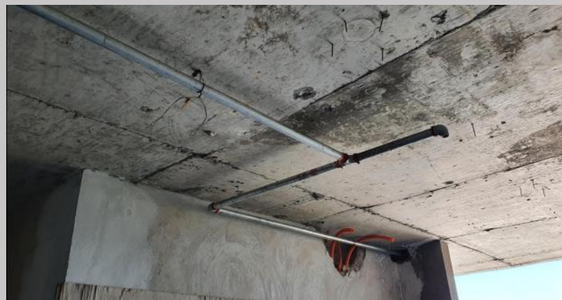
Tendido de PCI en el piso 8
