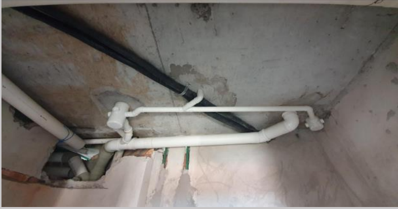
Cloacales en baños del piso 8
