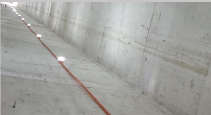
Preparaciones previas al montaje en las cajas de ascensores
