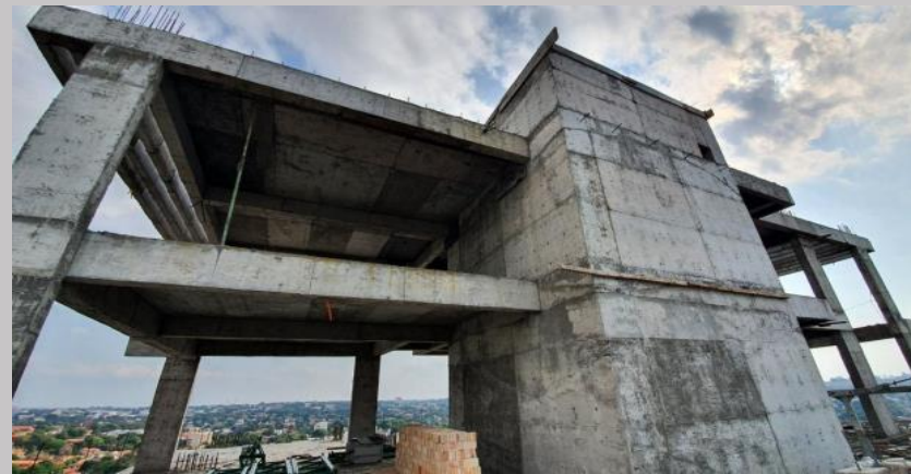
Sector piso y techo de gim y sauna con estructura terminada
