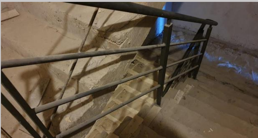
Baranda en escalera ya hasta el piso 10
