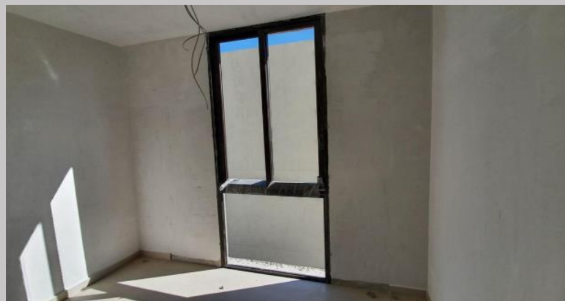
Colocación de aberturas en el 5A
