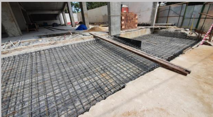
Armadura de la losa
