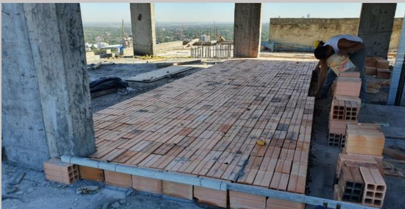
Preparación para la configuración de niveles y contrapisos en azotea
