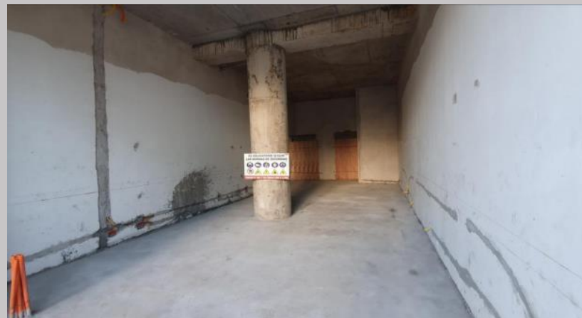
Sector del acceso principal ya con el contrapiso y carpeta
