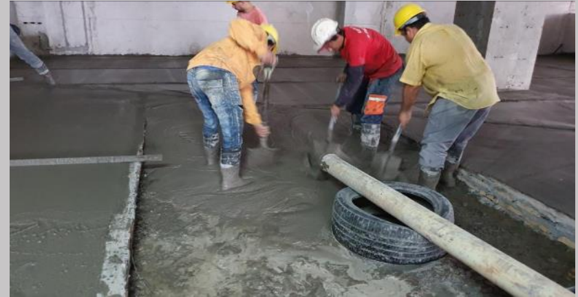
Carga de contrapiso en estacionamiento de la PB
