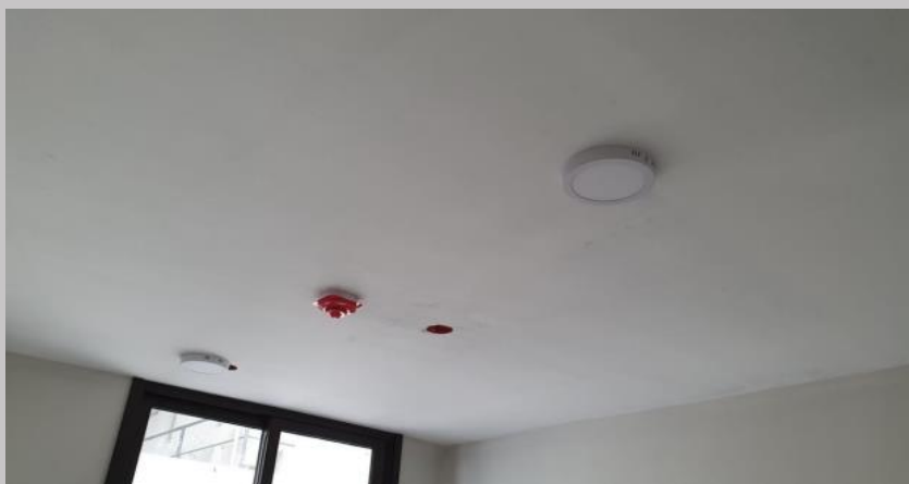
Montaje de artefactos de iluminación en el 3A
