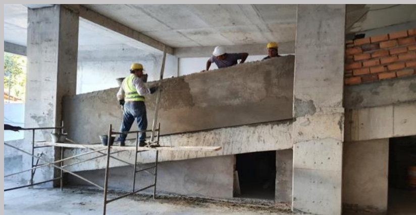
Revoques de terminación en costados de rampas a estacionamientos
