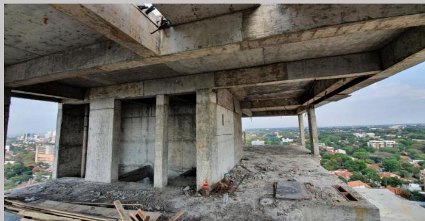
Vista del sector para gim y sauna ya totalmente desencofrado
