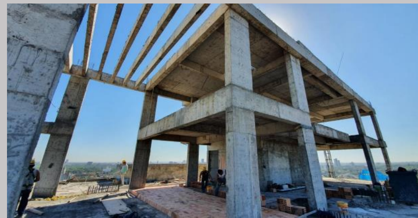
Vista de la estructura terminada en altura
