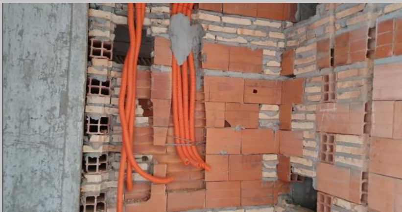
Electroductos en el piso 9
