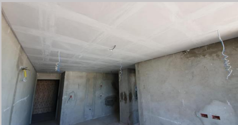
Cielorraso en el 6B
