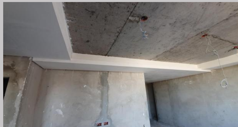
Colocación de cielorraso en le 6C
