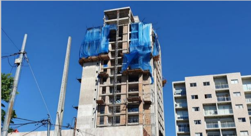
Vista general desde la fachada posterior
