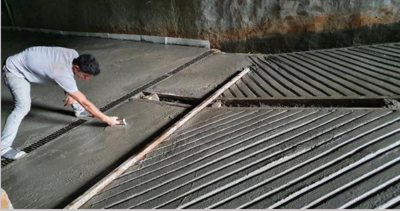
Terminación de rampa acceso al sub suelo
