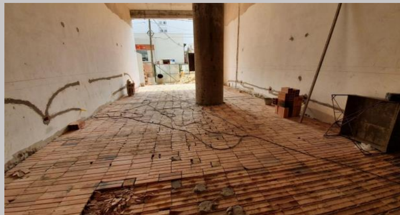
Colocación de ladrillos huecos hasta nivel requerido de fondo contrapiso en acceso
