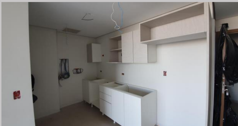
Montaje de muebles de cocina en el 4C
