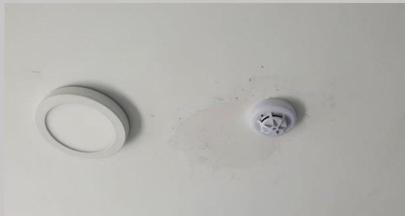
Colocación de detectores H/C pisos 1 al 5
