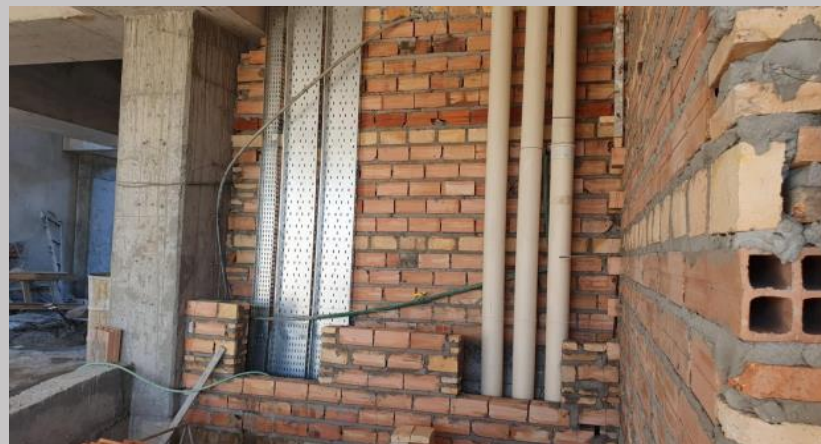
Cerramientos de montantes en estacionamientos
