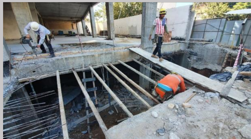
Preparación del encofrado para la zona faltante de rampa acceso y losa en planta baja
