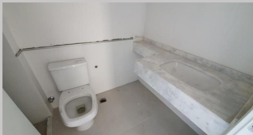
Montaje de artefactos de baño, mesada y bacha en el 3°
