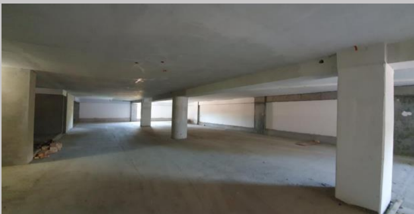
Vista actual del nivel E1 de estacionamiento
