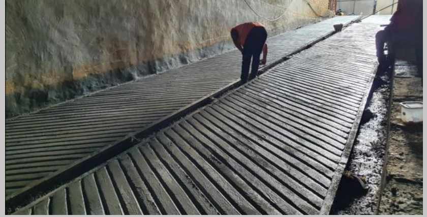
Terminación tipo espina de pescado en rampa acceso sub suelo
