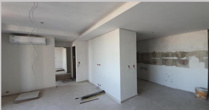
Cieloraso, enduido, cableado y evaporador de AA en el 5C
