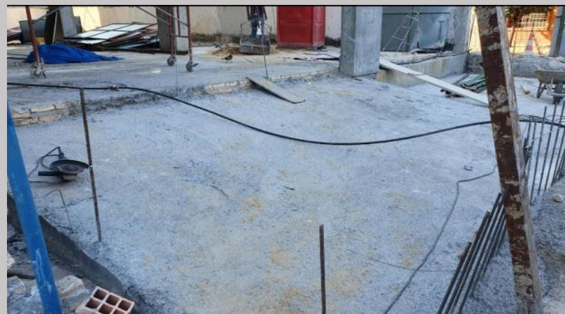
Losa rampa acceso a planta baja y sector faltante de techo SS ya hormigonados
