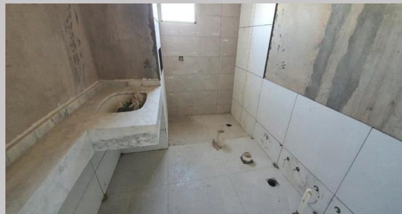
Revestimientos y mesada en el 5C
