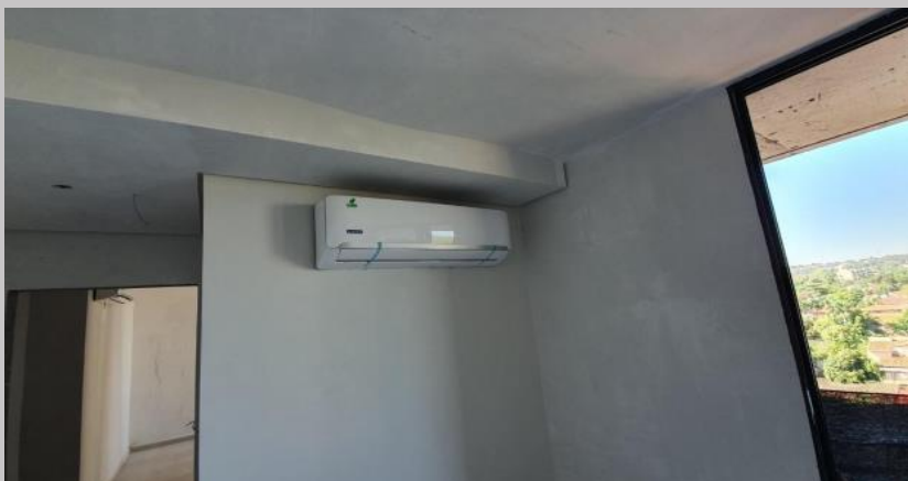
Evaporadores de AA en departamentos del piso 5
