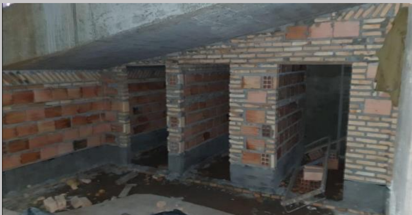
Avances en el sector de baño y depósitos bajo rampa de acceso al sub suelo
