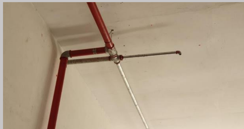
Tendido de la red de PCI en planta baja
