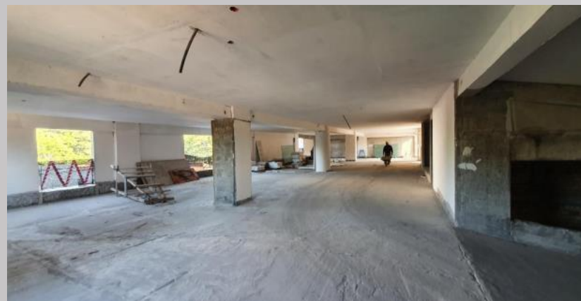
Nivel E2 de estacionamiento
