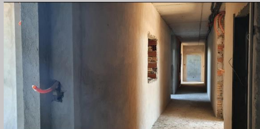
Avance del cargamento con el cargado del nivel de la losa
