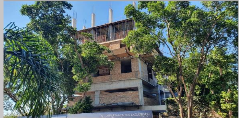
Vista de una de sus fachadas laterales
