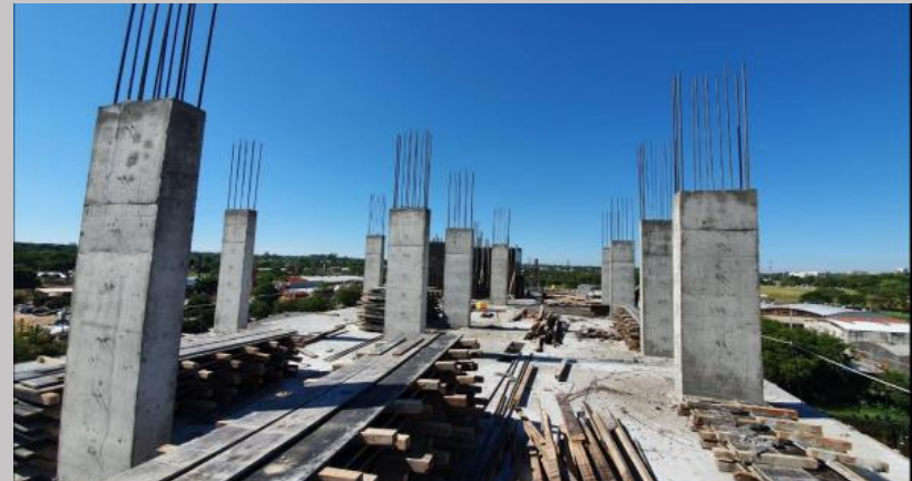
Pilares para el siguiente nivel –piso 5
