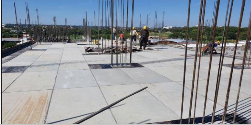
Encofrado para las losa del piso 4
