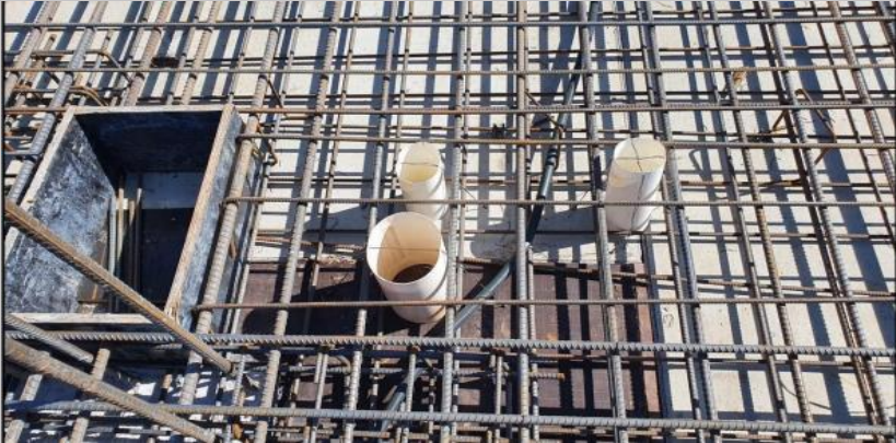
Colocación de los pasantes sanitarios y cajas de ductos
