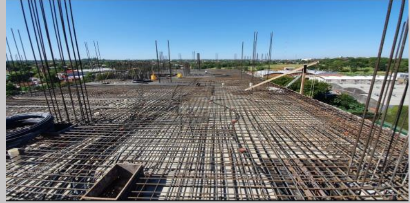
Armaduras, cajas de montantes e instalaciones previas al hormigonado
