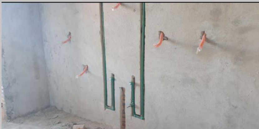
Instalación hidráulica 1B
