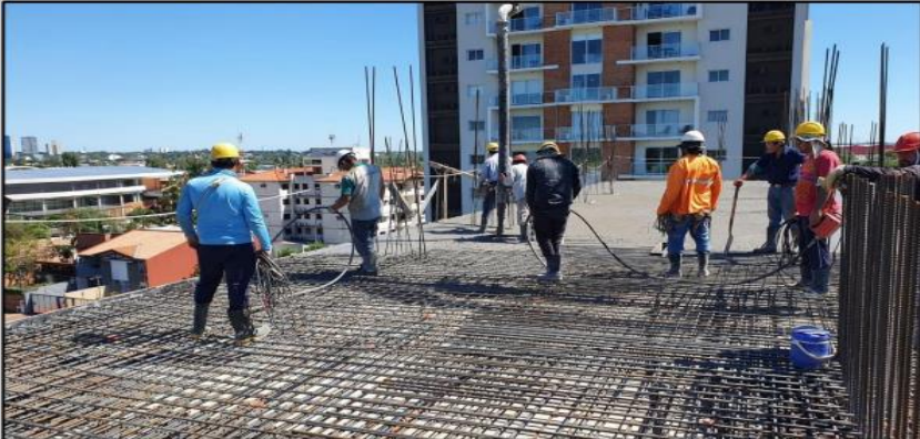
Jornada con el hormigonado del piso 4
