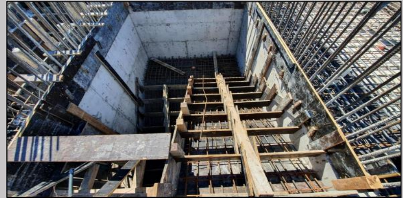
Escalera para llegar a este piso ya lista a hormigonar
