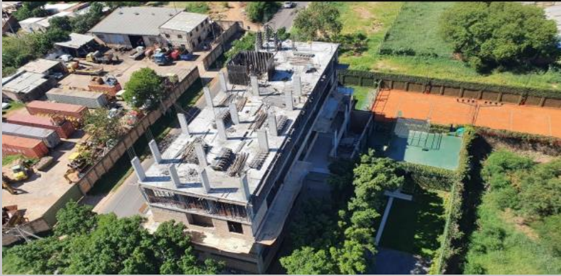
Vista panorámica del avance actual de la estructura
