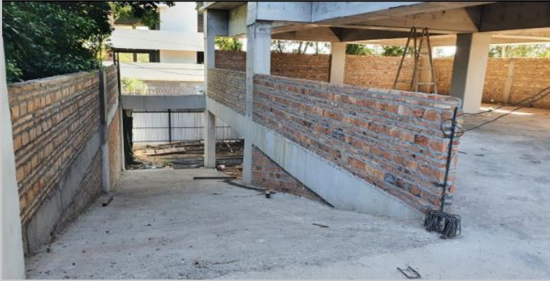
Vista actual del avance en acceso a E1
