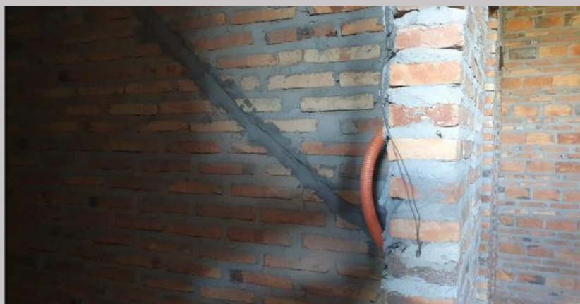
Colocación de electroductos en bauleras del E1
