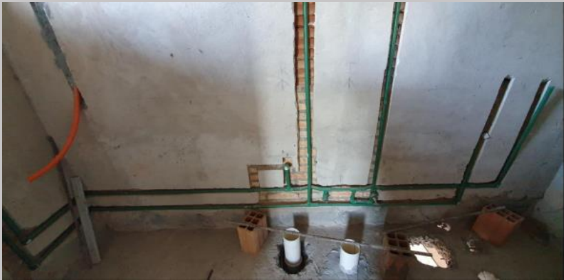
Instalación hidráulica y pasantes cloacales baño del 1D
