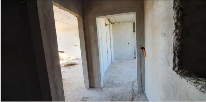
Revoques en piso 1
