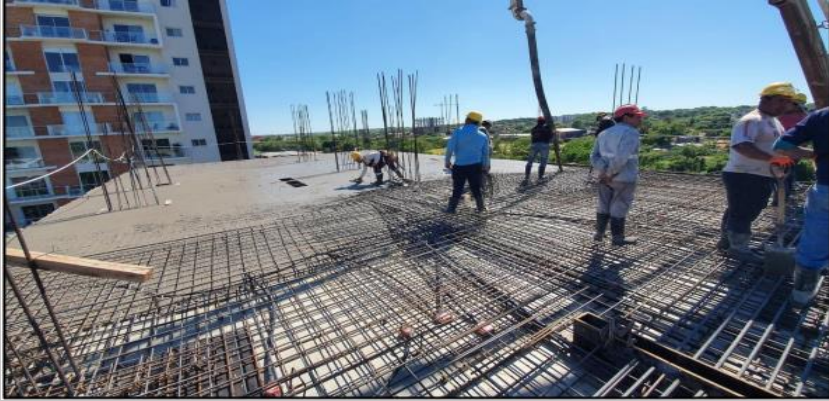
Hormigonado del piso 4 de departamentos
