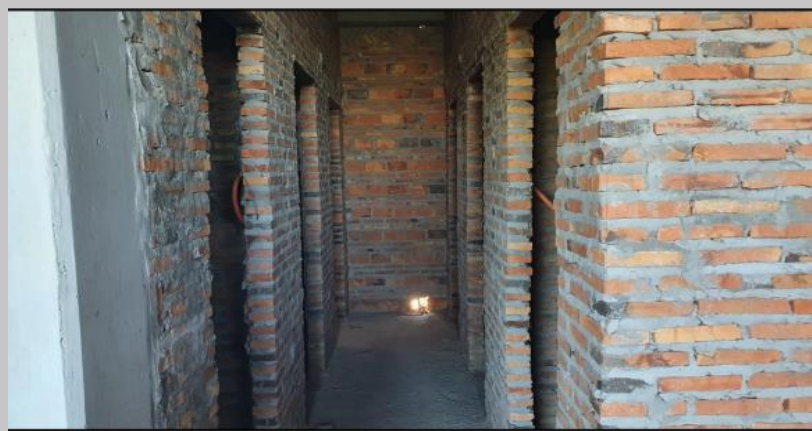
Vista actual de la mampostería de las bauleras
