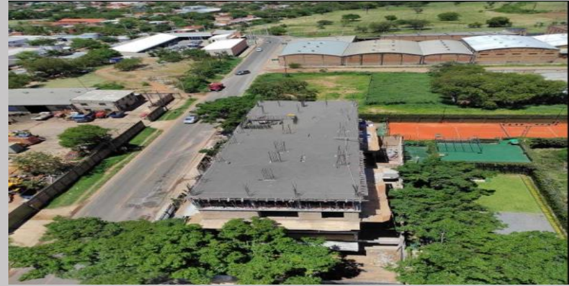
Losa del nivel 4 de departamentos ya totalmente hormigonado
