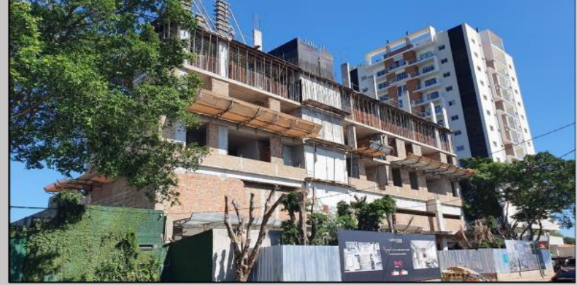
Vista actual desde la Av. Laguna Grande
