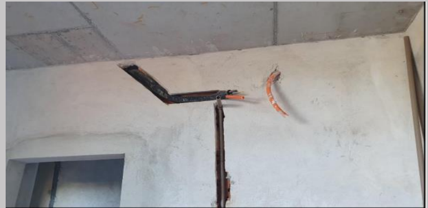
Ducteado para AA y desague en el 1D
