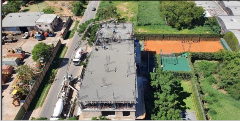
Una vista panorámica del avance del cargamento de la losa del piso 4
