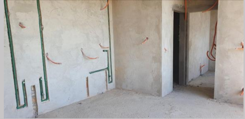
Revoque, instalación hidráulica y electroductos en el 1F
