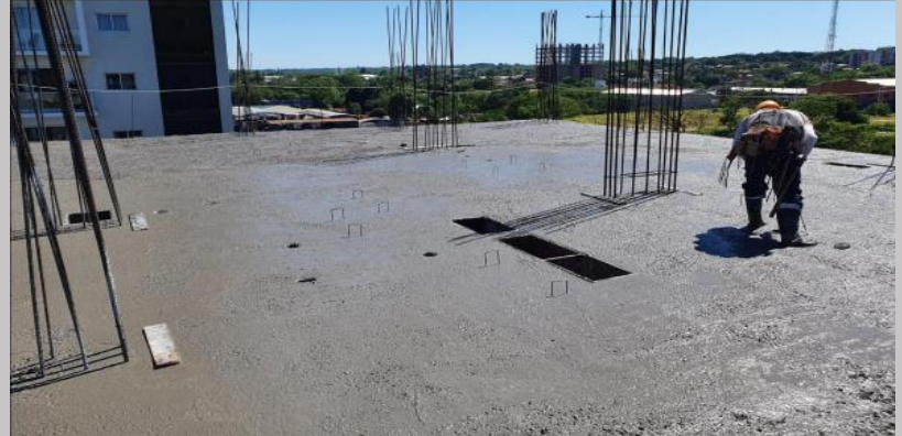
Sectores ya terminados
