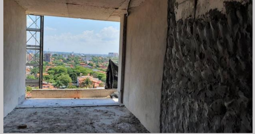
Inicio del revoque de paredes en el piso 7
