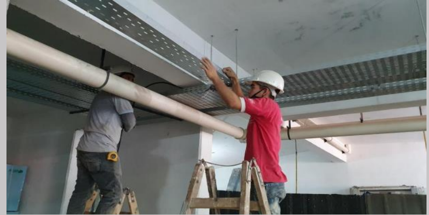
Cableado en planta baja
