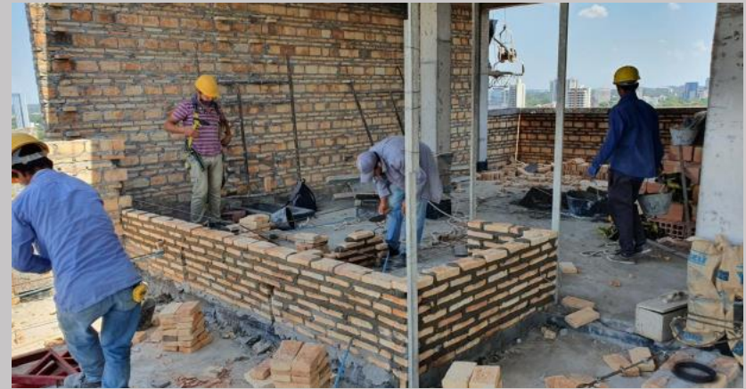
Vista actual del avance de los cerramientos en azotea
