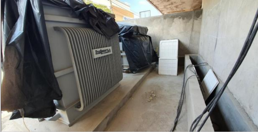
Trabajos acondicionamiento sector de PD y medidores en planta baja
