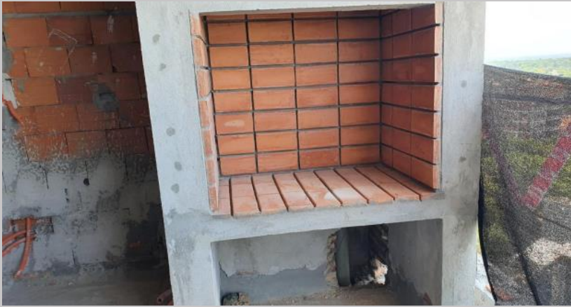
Refractario en parrillas del piso 7
