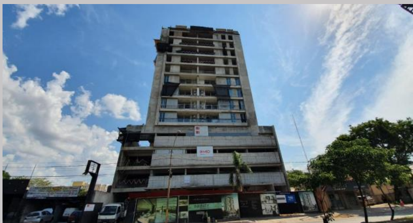
Vista actual fachada principal
