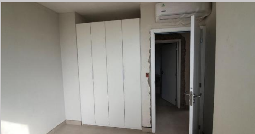
Colocación de placar en el 3C
