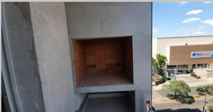
Revestido frente parrilla en el piso 3
