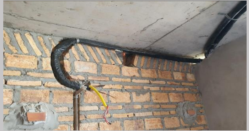
Ducteado de AA y desagüe en el 8C
