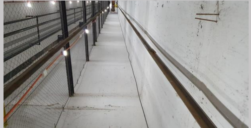
Montaje de las guías lado derecho
