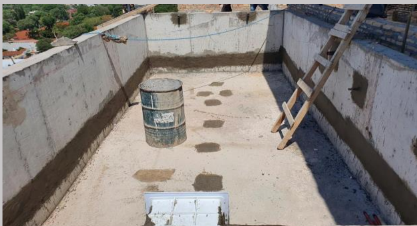
Trabajos de regularización y prolijado del hormigón de la piscina
