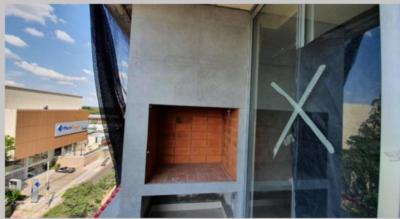
Revestido de parrilla en el 3C
