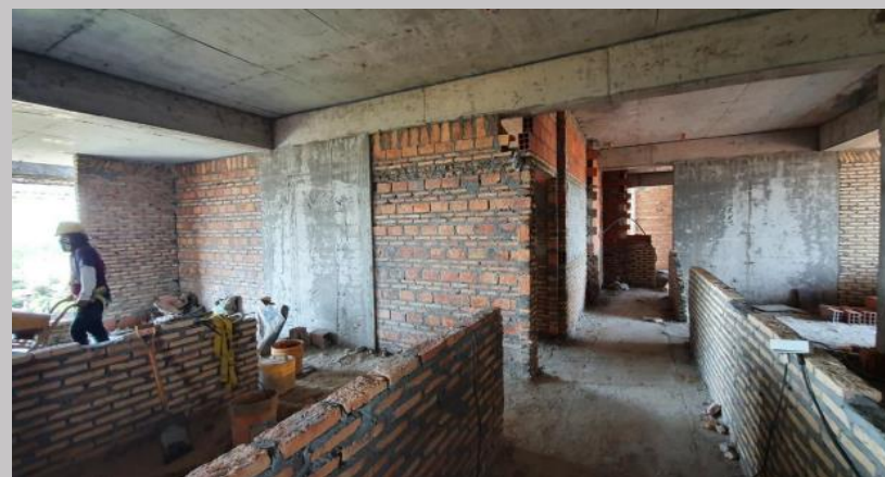
Mamposterías en el piso 9
