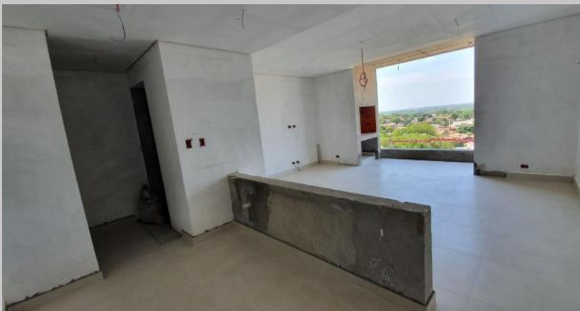
Cielorraso, piso y una mano de enduido en el 5B
