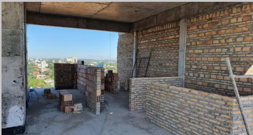
Mampostería de azotea
