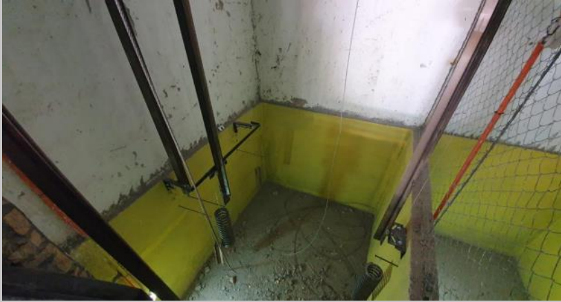
Montaje ascensor lado izquierdo
