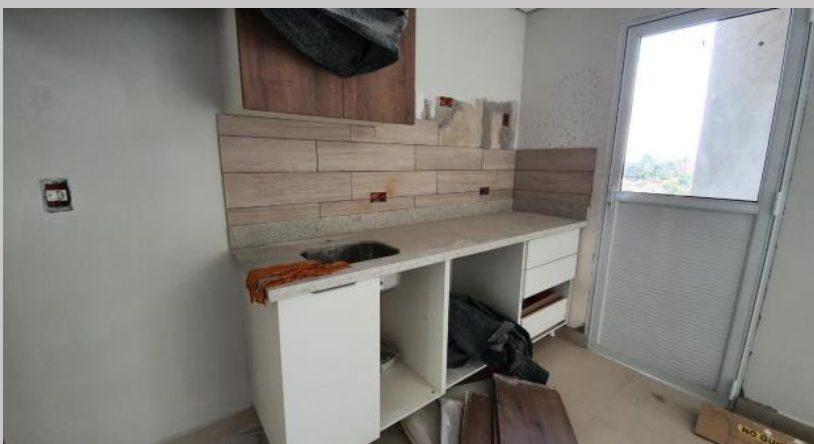
Revestido cocina en el 2A
