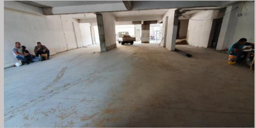
Hormigón de terminación helicopteado en circulación de planta baja
