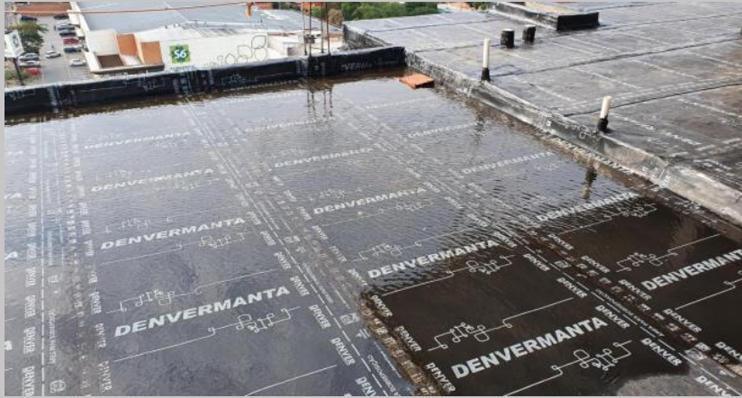
Prueba de agua de la aislación en azotea
