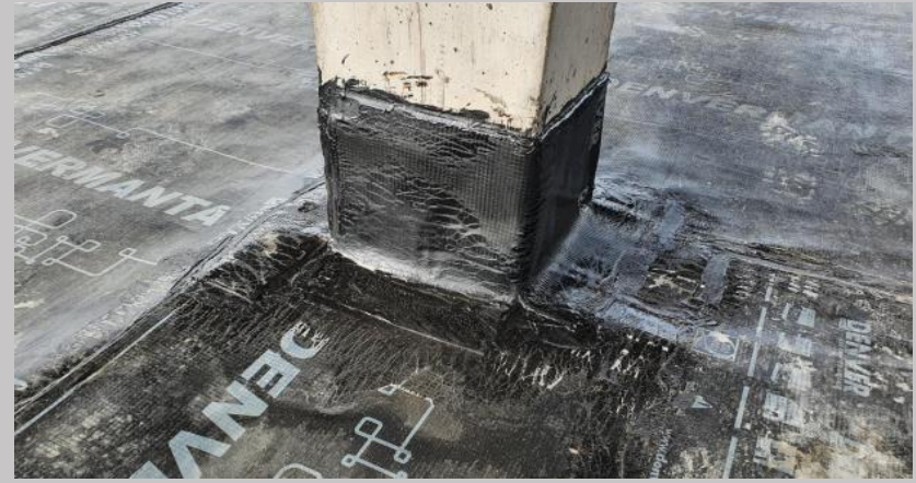
Detalles de membrana asfáltica en azotea
