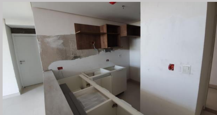
Montaje de muebles en departamentos del piso 3
