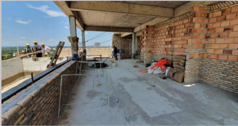
Avances en la mampostería de azotea
