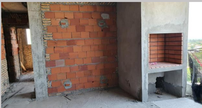
Refractario en parilla del piso 8
