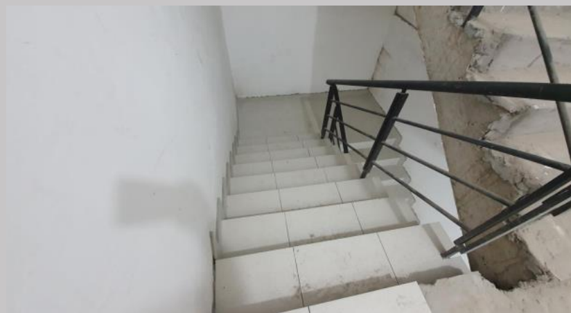
Colocación piso en escalera actualmente hasta el piso 4to
