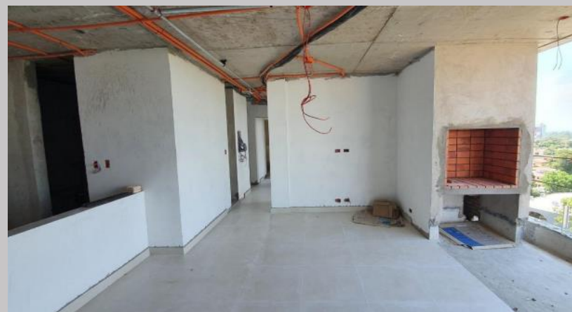
Piso e instalaciones en el 6B
