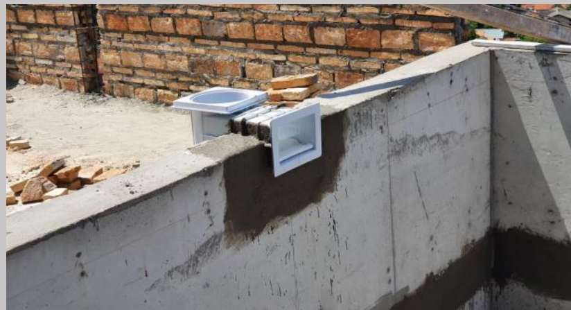
Colocación de accesorios de filtro previo a la impermeabilización de la piscina
