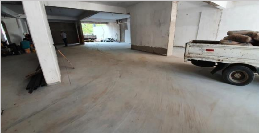
Piso de hormigón terminado en planta baja
