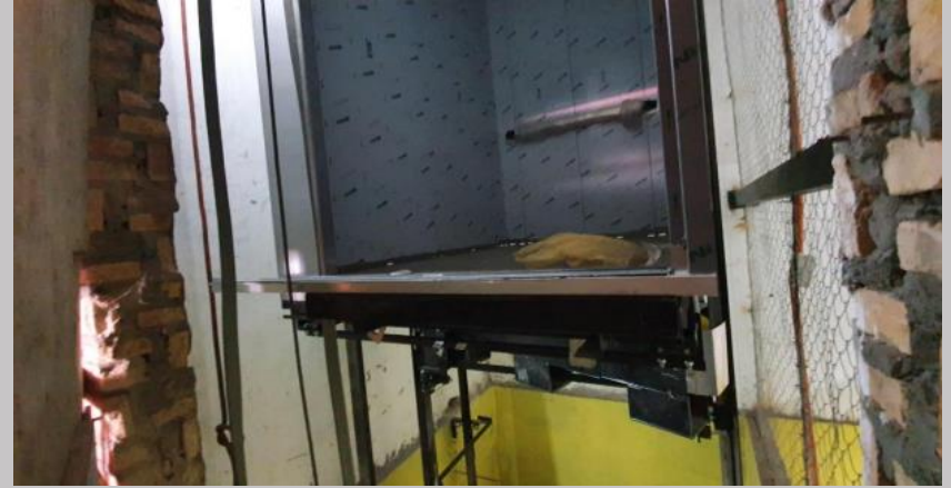
Montaje ascensor izquierdo
