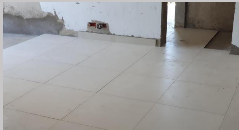
Colocación de piso en el 5E
