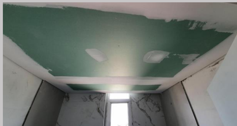
Cielorraso en baños del piso 4
