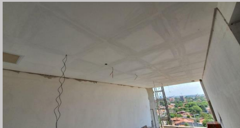
Colocación de cielorraso en el 5D
