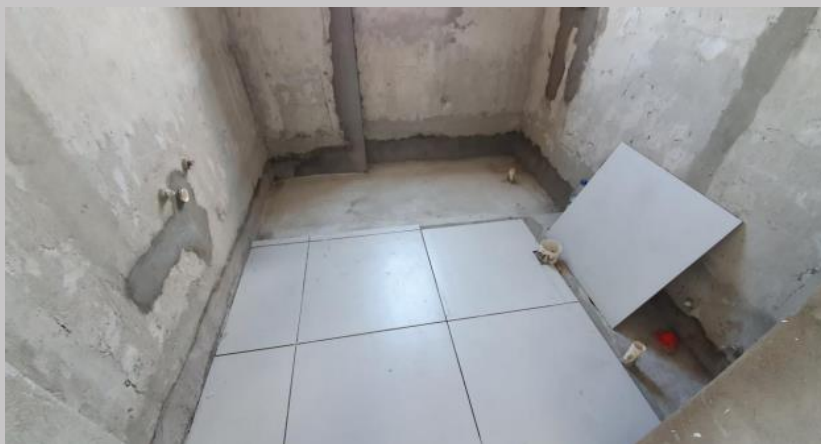
Colocación de piso en baños del piso 5
