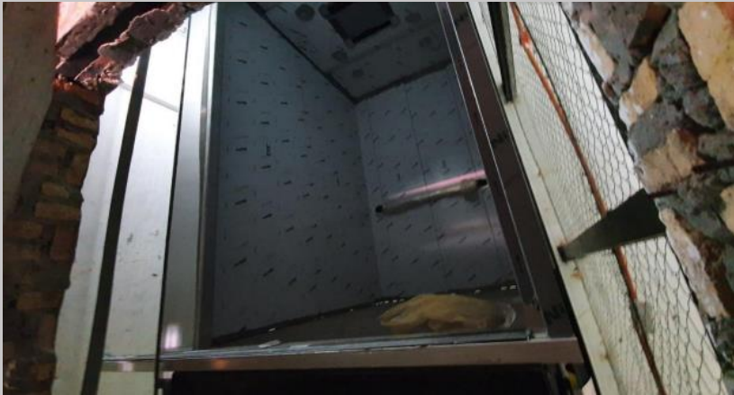
Ensamblado de cabina lado izquierdo
