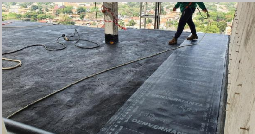
Aislación losa de azotea
