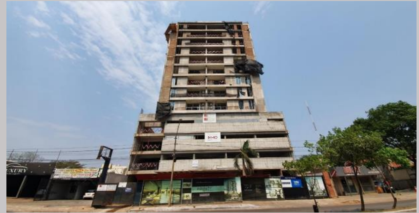
Avances actual desde fachada principal
