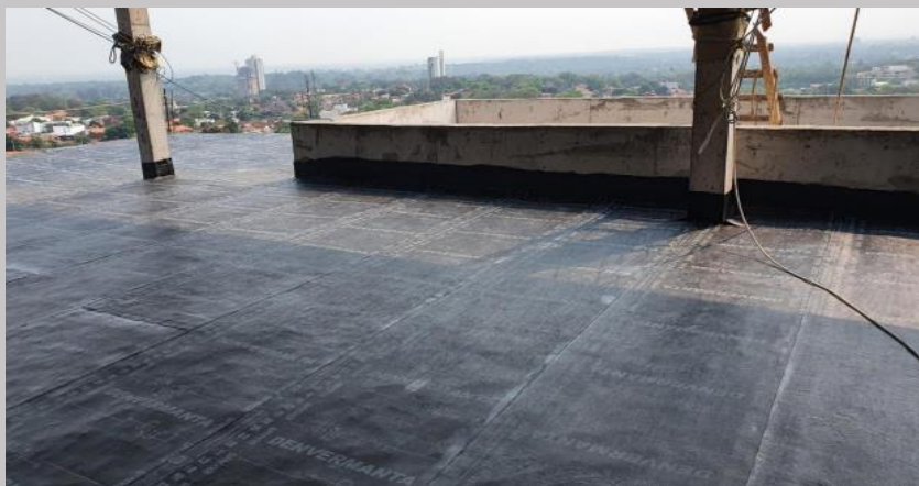
Aislación en azotea
