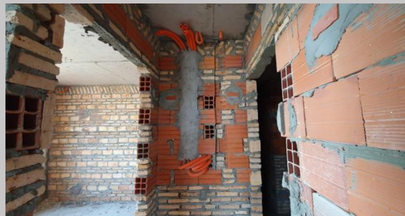
Mamposterías en el piso 8
