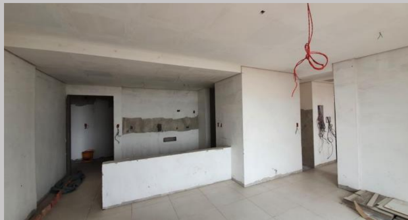
Cielorraso y enduido una mano en el 5B
