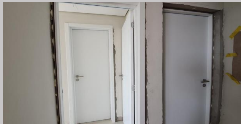
Colocación de puertas en el 3C
