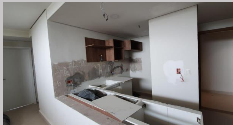
Montaje de muebles de cocina 1C
