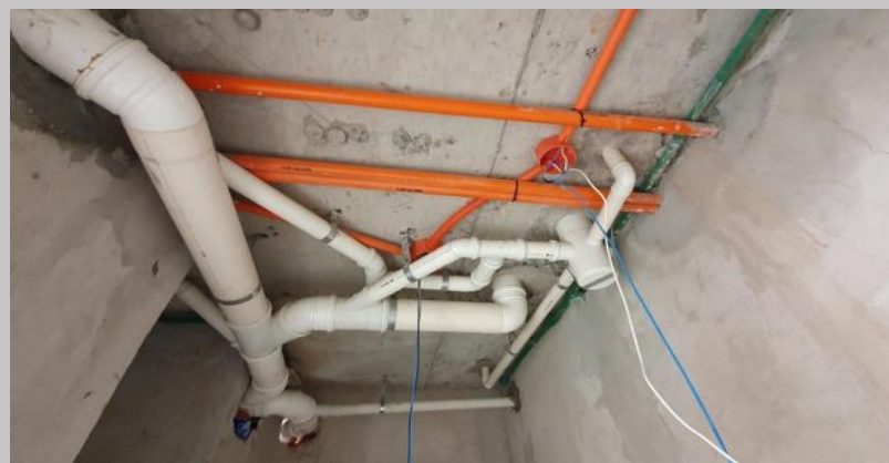
Desagües cloacales baños del piso 6
