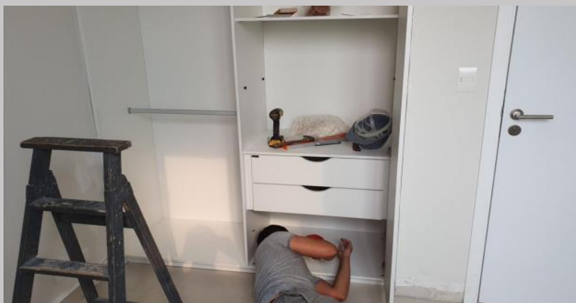
Montaje de placar en el 2A
