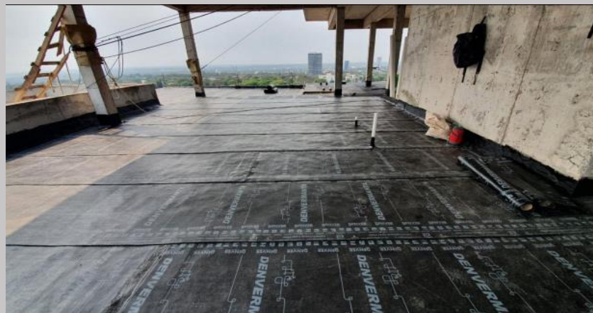
Pegado de membrana de 4mm en losa azotea
