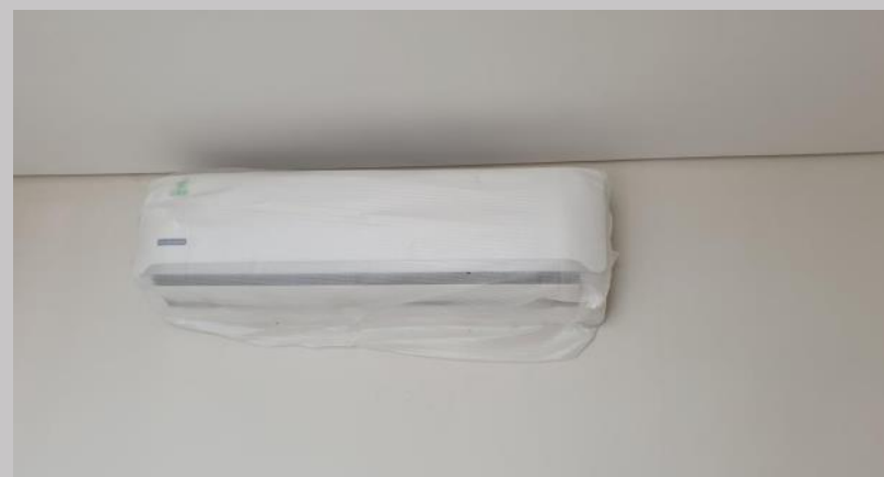
Colocación de evaporadores de AA en el piso 3
