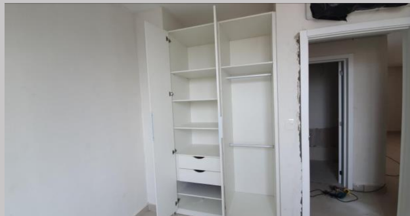
Montaje de placares piso 2
