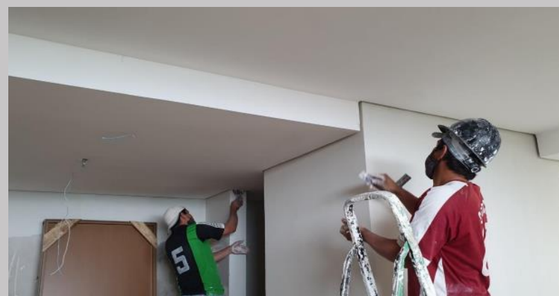
Enduido y detalles piso 3
