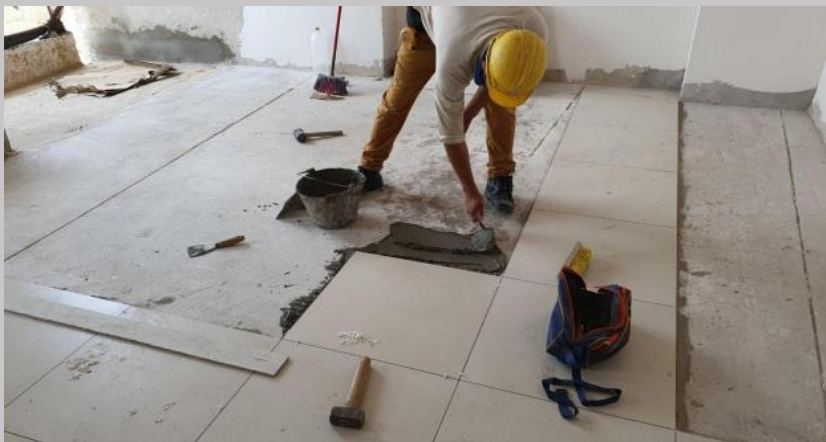
Colocación de piso en el 5A
