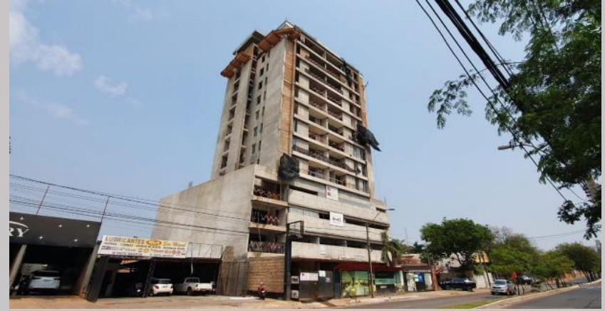
Vista actual de una de las fachadas
