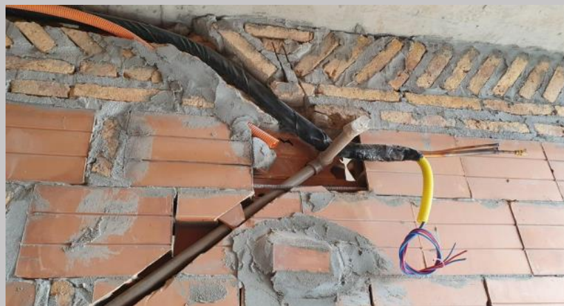
Ducteado de AA y desagüe piso 7
