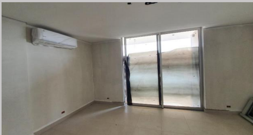
Una mano de enduido, aberturas y AA en el 4C
