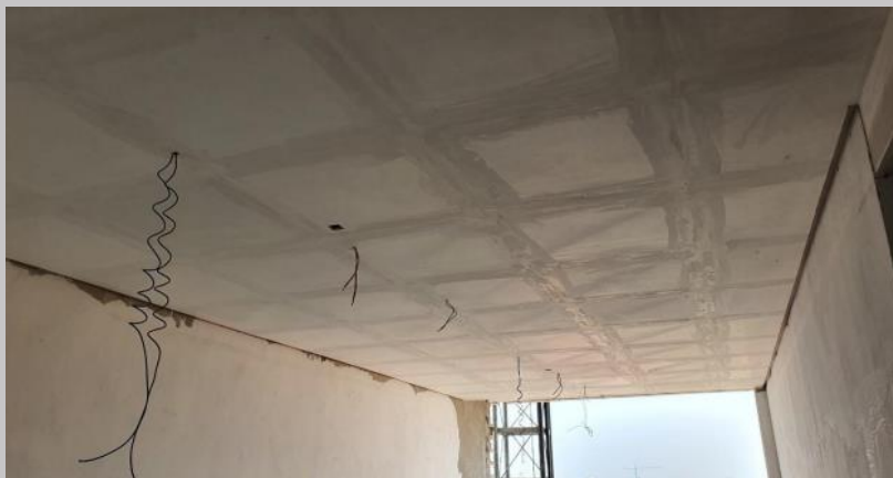
Cielorraso en el 5D
