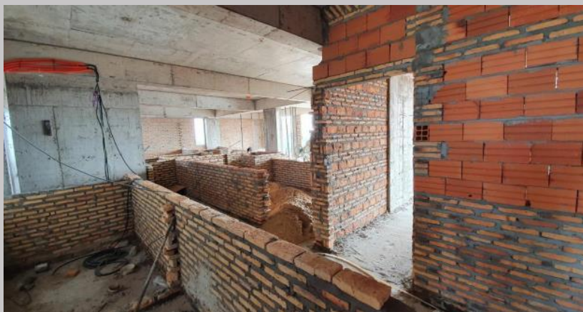
Mamposterías en el piso 9
