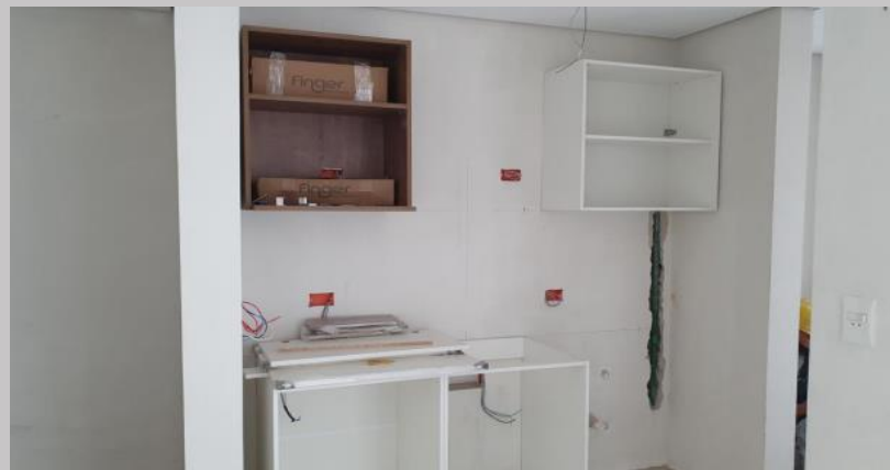
Inicio del montaje de muebles de cocina en el 2E
