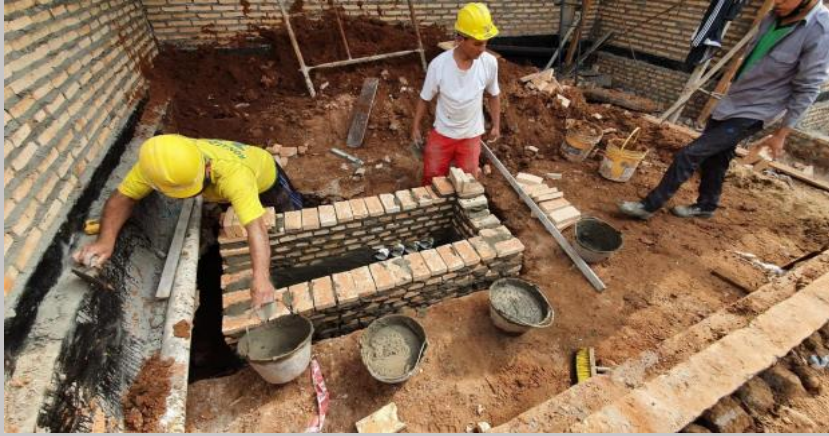
Trabajos en zona de montaje de los transformadores
