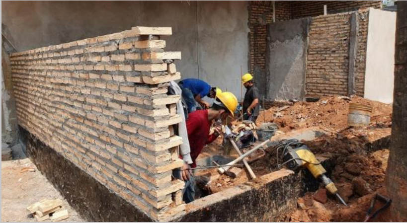
Trabajos acondicionamiento sector de PD y medidores en planta baja
