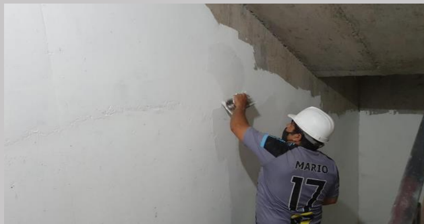
Enduido caja de escalera
