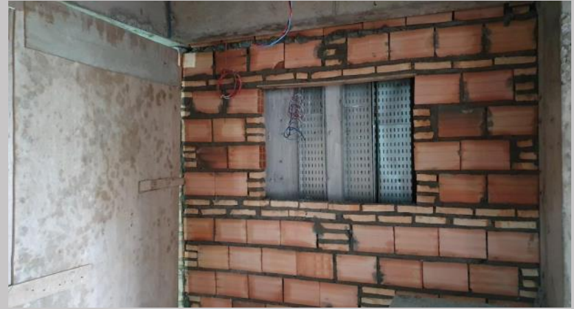
Cerramiento de mampostería para montantes
