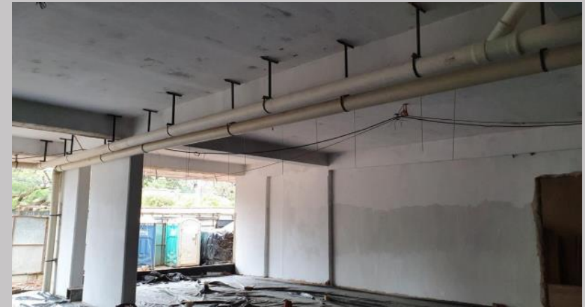
Enduido de paredes en planta baja
