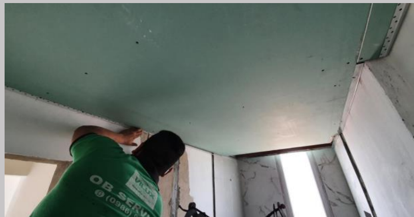
Cielorraso baño del 4E
