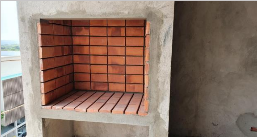
Revestimiento refractario en parrillas
