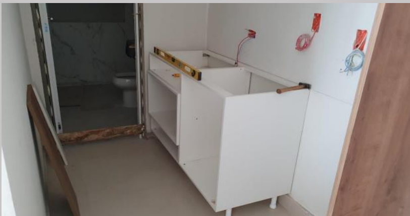
Colocación muebles de cocina piso 2
