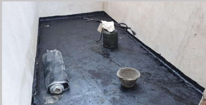
Aislación de base del piso en depósito de basura en planta baja
