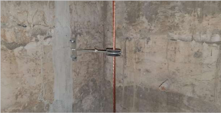
Línea de cable de cobre desnudo para el sistema de pararrayos
