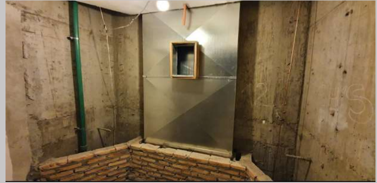
Salida de aire en descansos para presurización de caja de escalera
