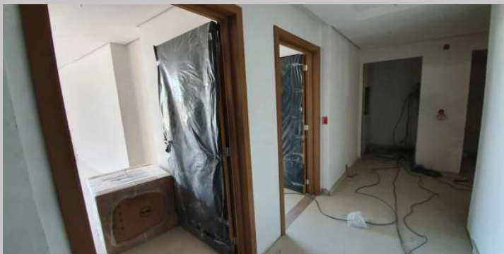
Montaje de puertas en el piso 5
