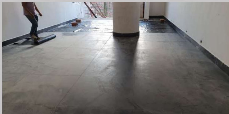
Piso en recepción planta baja
