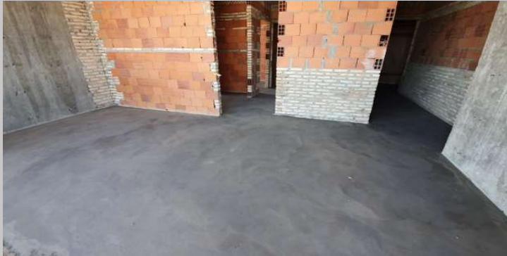
Contrapiso y carpeta en el 10A
