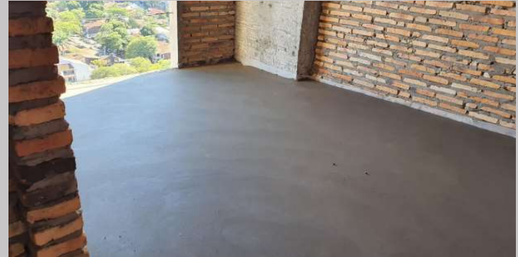
Contrapiso y carpeta en el piso 11
