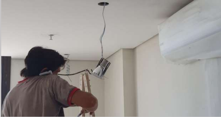
Montaje de artefactos en el 3F
