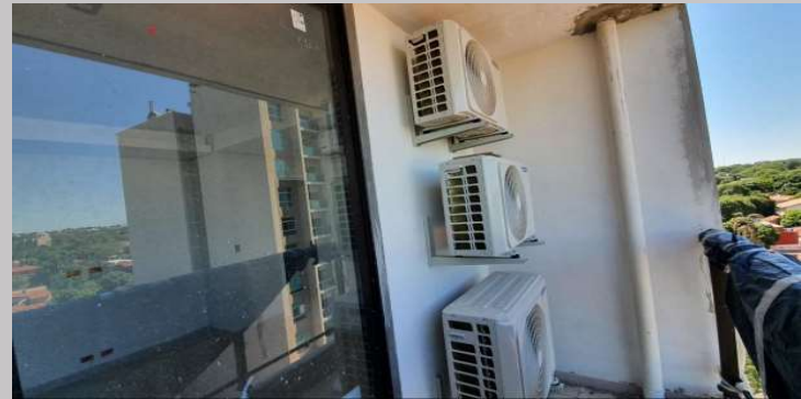
Montaje de compresores en el piso 4
