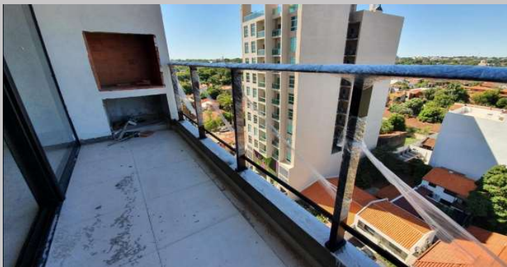
Piso de balcón y baranda en el piso 6
