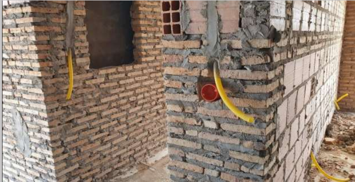
Electrodutos y cajas eléctricas del sector
