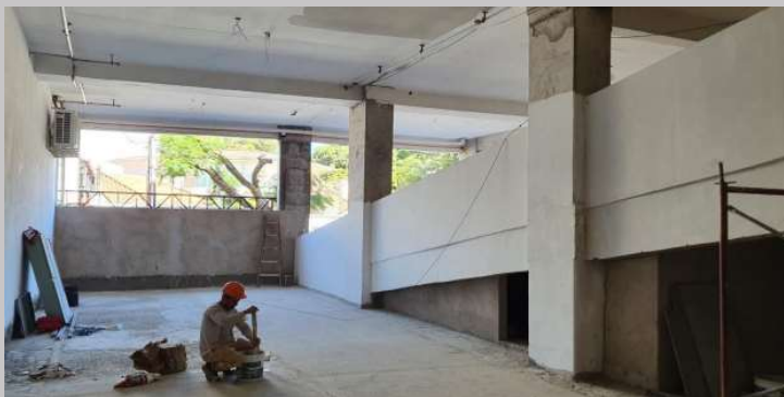
Terminación de enduido y pintura en sectores de planta baja
