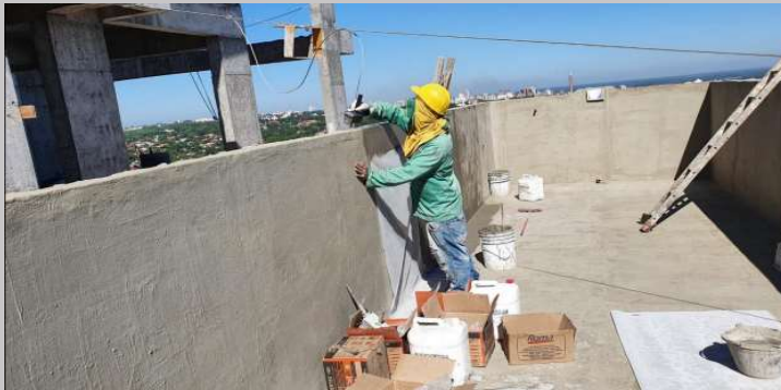
Aislación de piscina azotea
