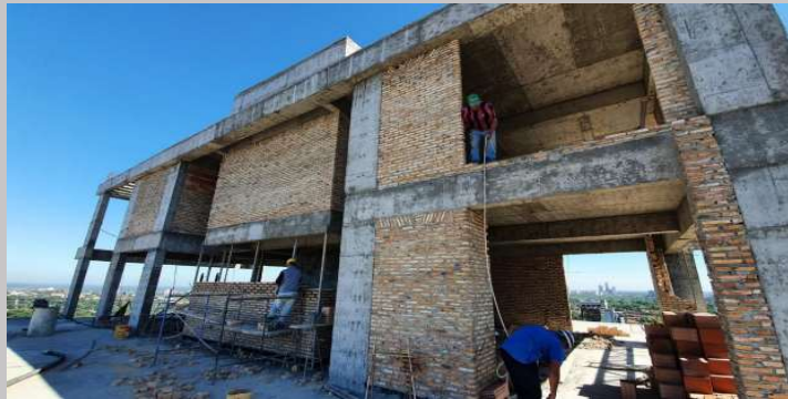
Vista de los cerramientos en azotea y sector gym
