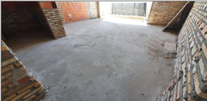
Contrapiso y carpeta en el 9F
