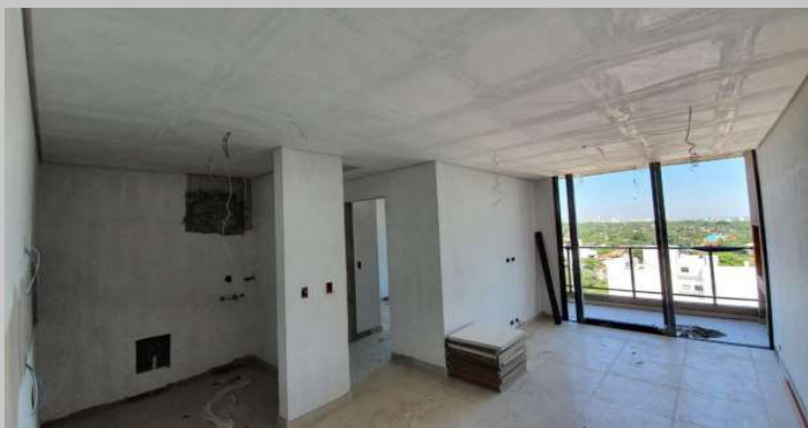
Piso y cielorraso en el 7B
