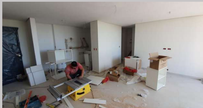
Inicio del montaje de muebles de cocina en el 5F
