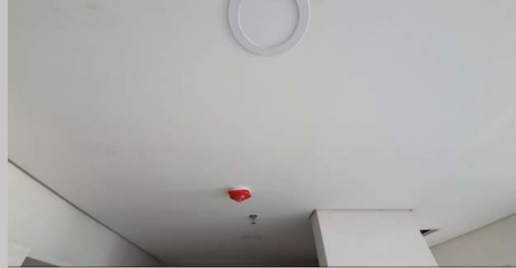
Artefactos de iluminación piso 4
