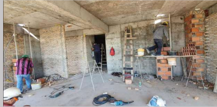
Mampostería en sector gym y sauna
