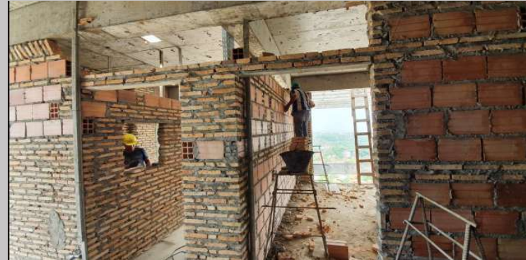
Avance de los cerramientos en azotea
