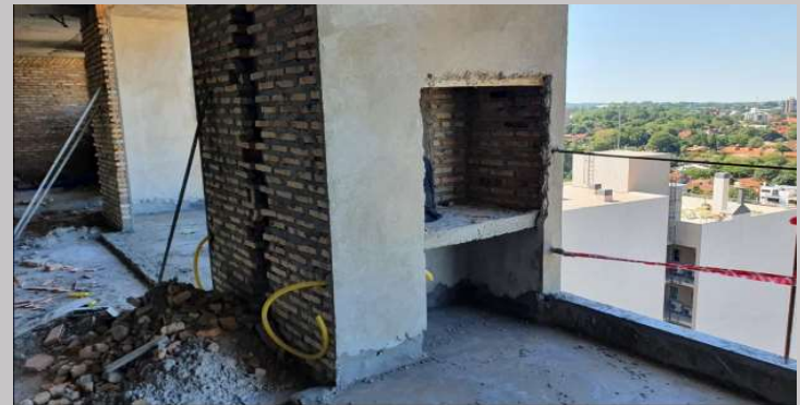
Mampostería y losa de parrillas en el piso 12
