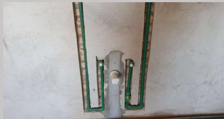
Alimentación para cocina y desagüe en el 8B
