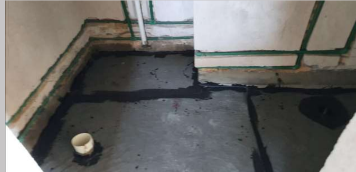
Aislación de losas de baño piso 8
