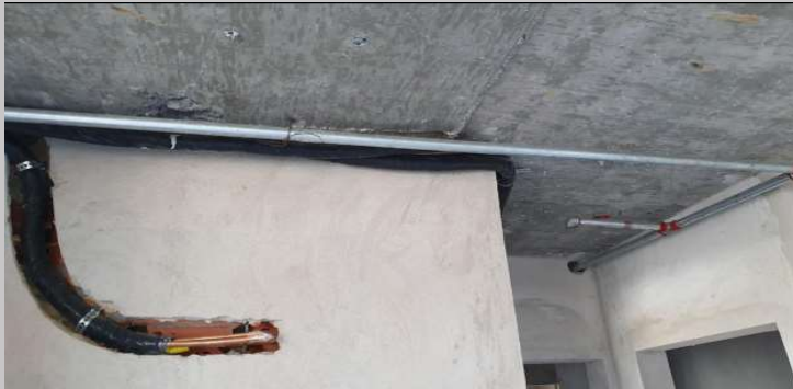
Alimentación de AA y PCI en el piso 8
