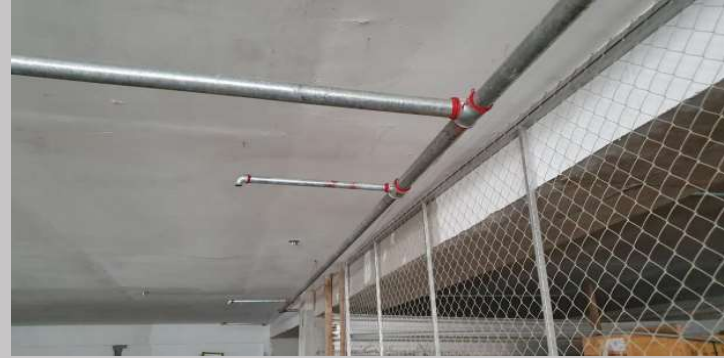
Red de rociadores contra incendios en estacionamiento de PB
