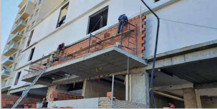
Losa marquesina y mampostería en frente acceso principal
