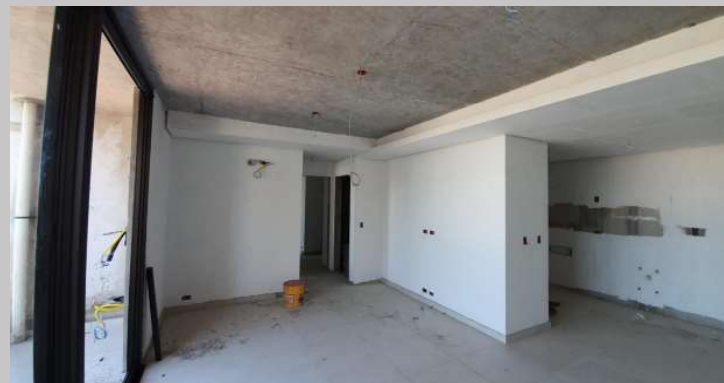
Aberturas, enduido y cielorraso en el 6C
