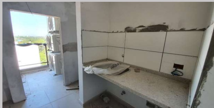
Revestido y mesada en el 5A
