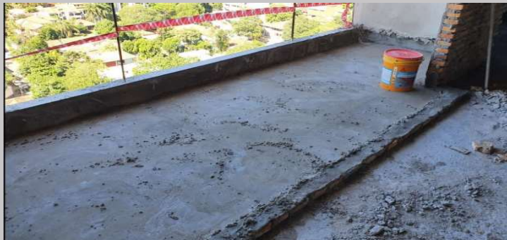
Aislación de losa balcones piso 12
