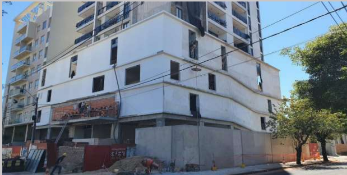
Vista de los cerramientos de estacionamientos
