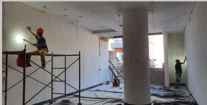
Enduido, cielorraso y terminaciones en zona de recepción planta baja
