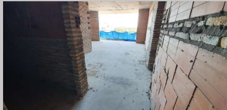
Carpetas terminadas en el piso 9
