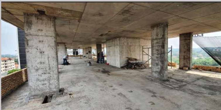
Una vista actual del nivel 4
