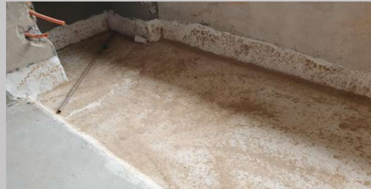
Aislación de losas de balcones piso 1
