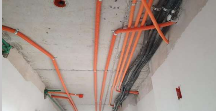
Instalaciones bajo losa techo piso 1
