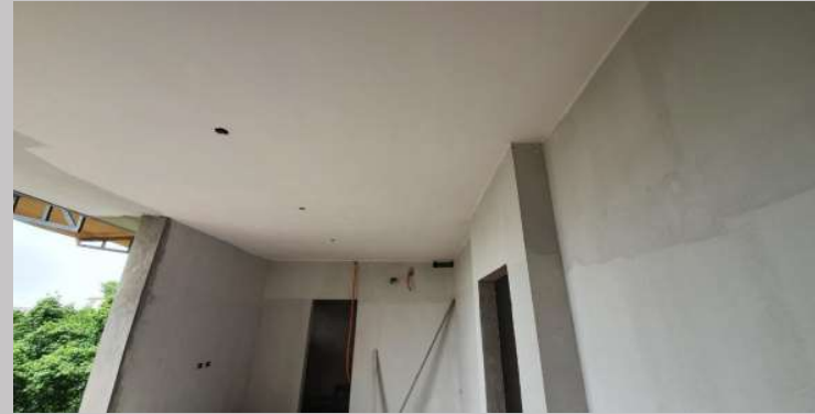
Enduido de paredes y fondos de losa primer piso
