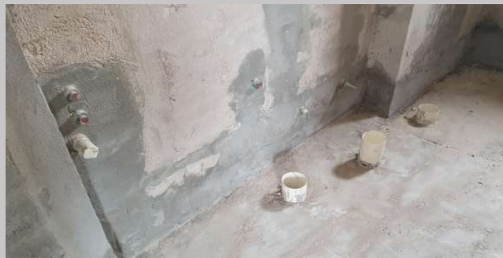
Instalación de agua y desagües baños piso 1
