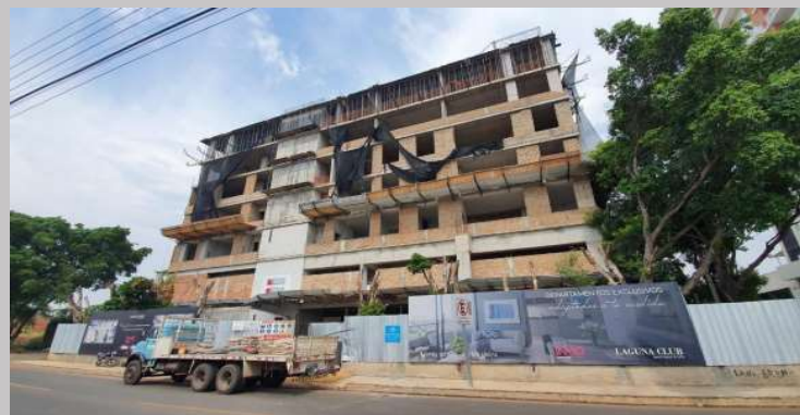
Vista actual de el avance
