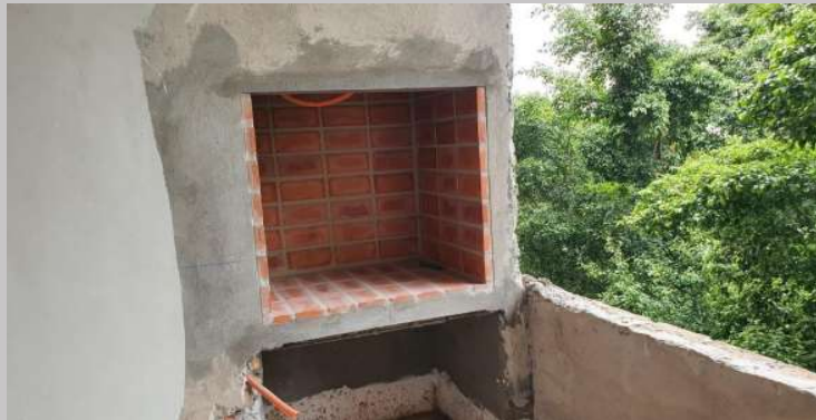
Revestido refractario en parrillas piso 1
