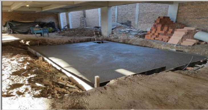
Tapa de tanque ya terminada
