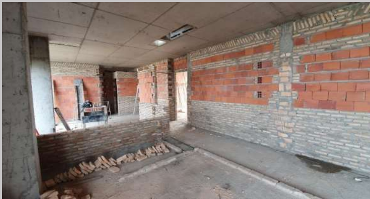
Avance de los cerramientos de mampostería piso 3
