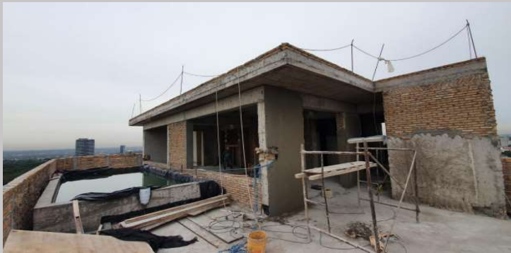
Vista del sector
