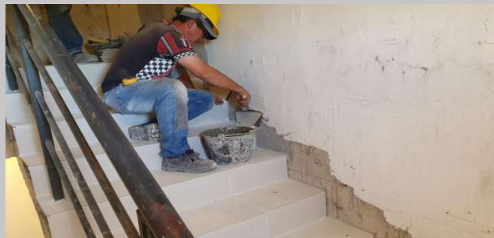
Piso y zócalo de escalera
