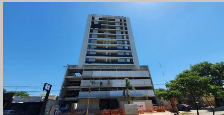
Vista actual de la fachada principal
