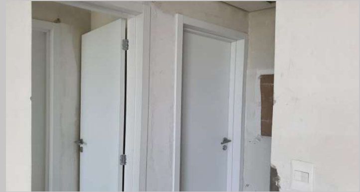
Colocación de puertas en el piso 4
