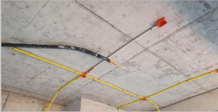
Tendido del circuito de ductos para AA
