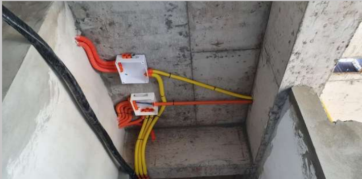
Cajas y electroductos
