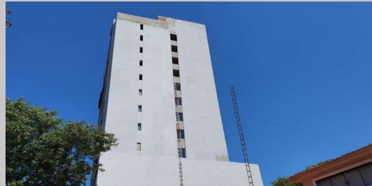
Vista de una de las fachadas laterales y su primera mano de texturado
