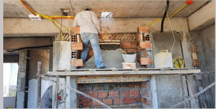
Mampostería y campana de parrillas del quincho
