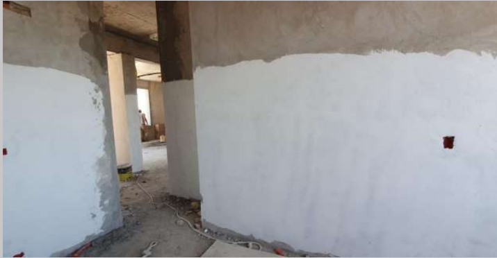
Revoque y una mano de enduido en paredes
