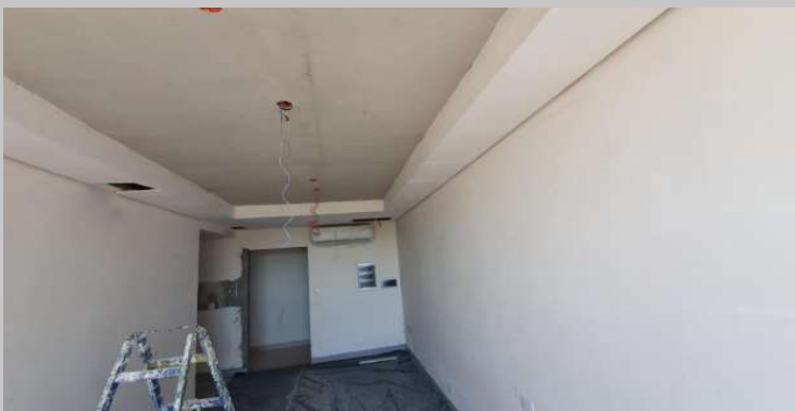
Cielorraso en el 3D
