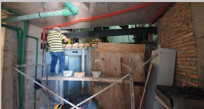
Terminaciones para acceso de ascensores en la azotea
