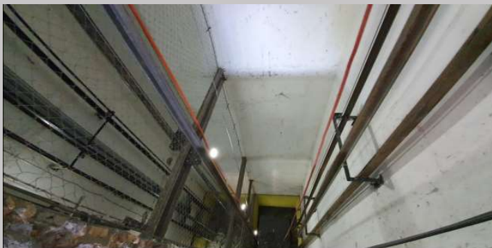
Montaje ascensor derecho
