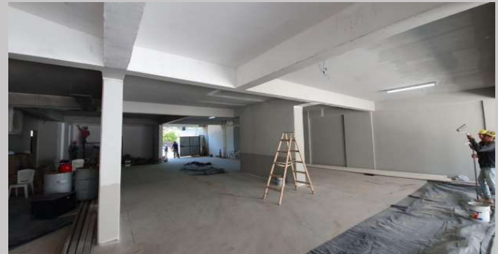
Circulación en planta baja
