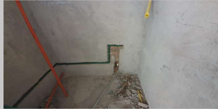
Instalación hidráulica en baños
