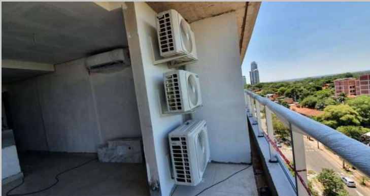
Montaje de compresores en el 5C
