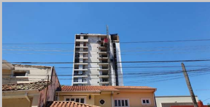
Vista actual fachada posterior
