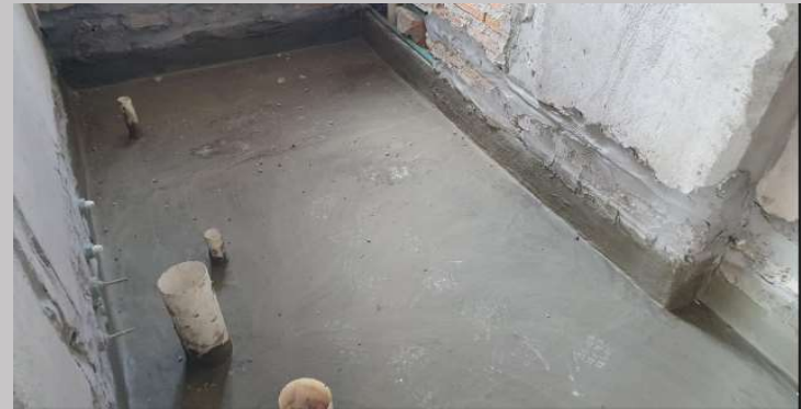
Aislación de baños en el piso 6
