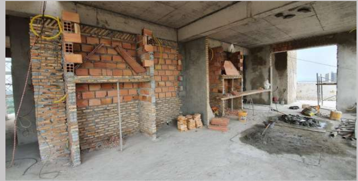
Vista del avance en las parrillas
