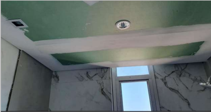
Cielorraso baños del piso 4
