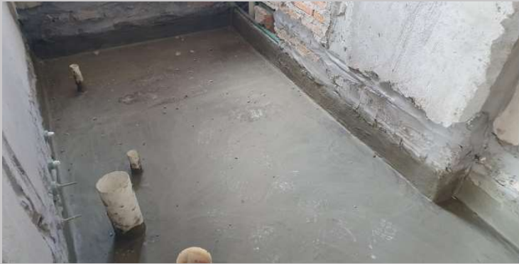
Aislación de baños en el piso 6
