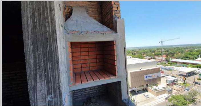
Parrillas en piso 9
