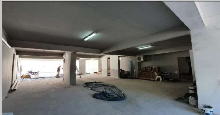
Enduido de paredes, vigas y losas en estacionamiento de PB
