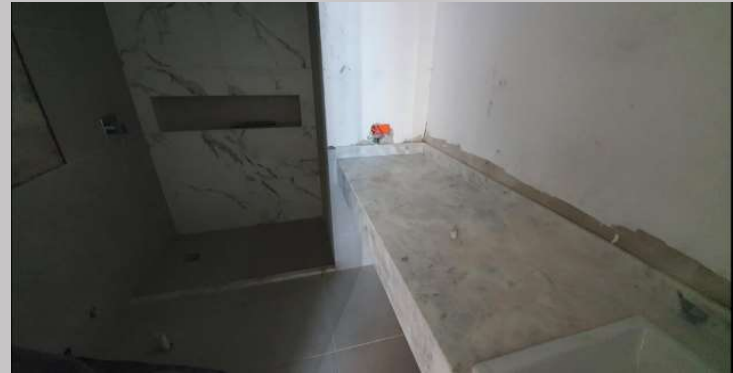
Mesada, revestido y piso en el baño del 4A
