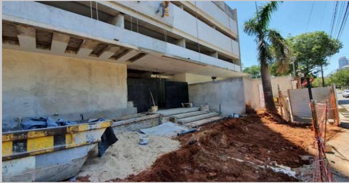
Trabajos actuales en zonas de accesos principal
