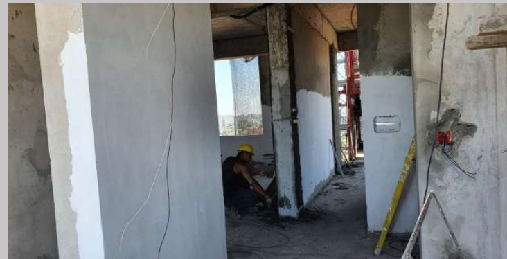
Avances en el revoque
