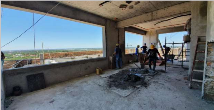
Revoque y mocheta de aberturas sector del quincho
