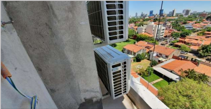
Compresores de AA en el 4E
