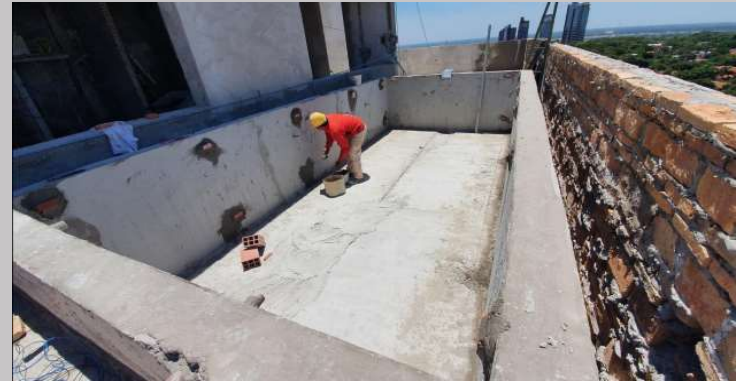
Trabajos de aislación de la piscina
