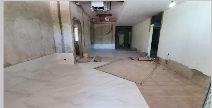
Piso, cielorraso y montaje de AA en recepción
