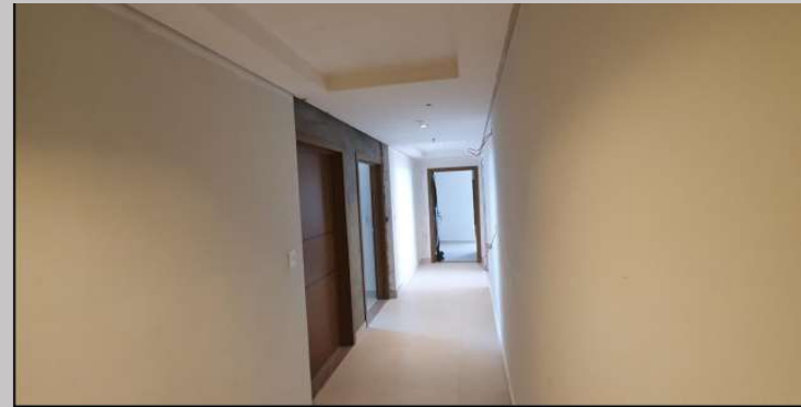
Palier del piso 4 y su estado actual de terminaciones
