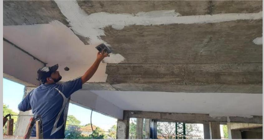
Trabajos de prolijado y enduido de los fondos de losa en estacionamientos
