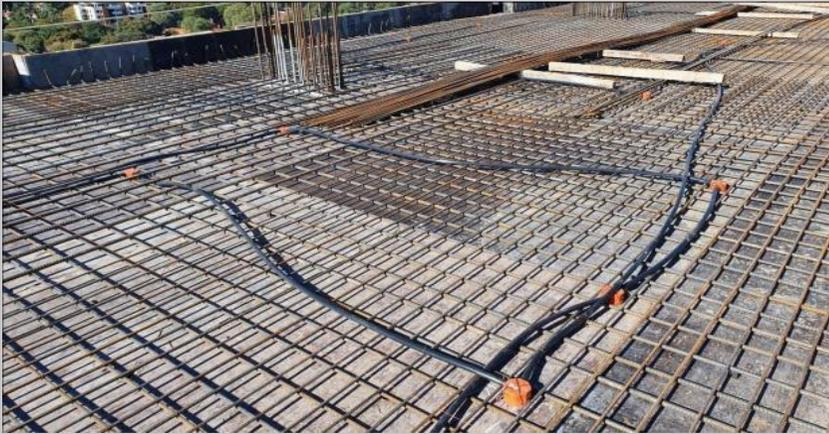
Armaduras e instalación eléctrica en losa de la azotea
