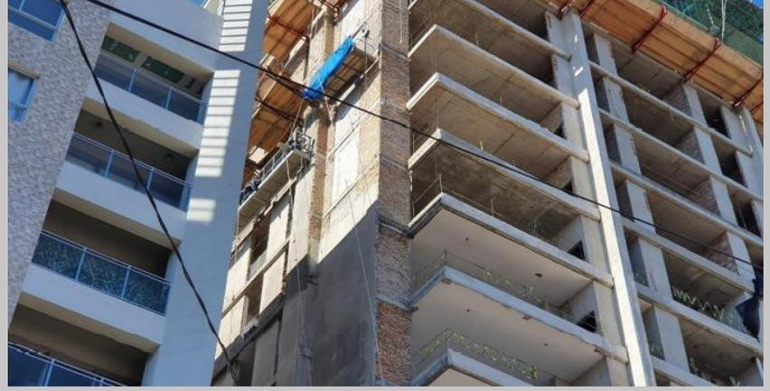
Avance del revoque exterior en fachada lateral
