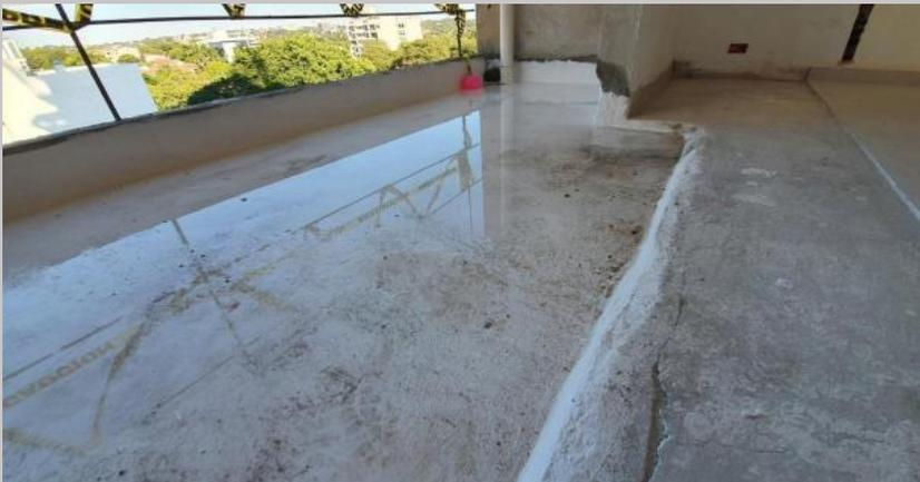
Prueba de aislación en balcón del piso 4
