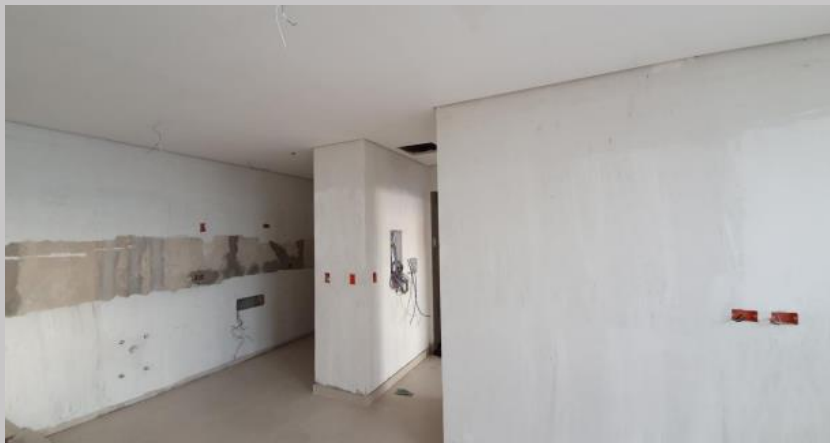
Enduido una mano y cielorraso en el 3B
