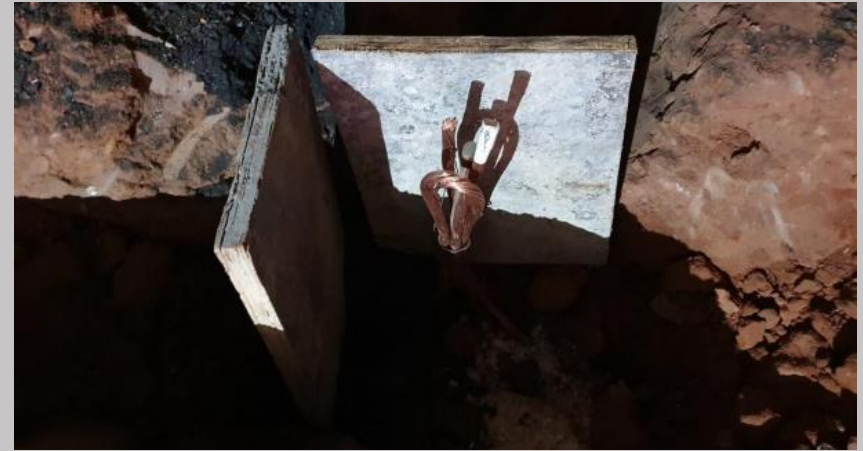
Trabajos de puesta a tierra sub suelo
