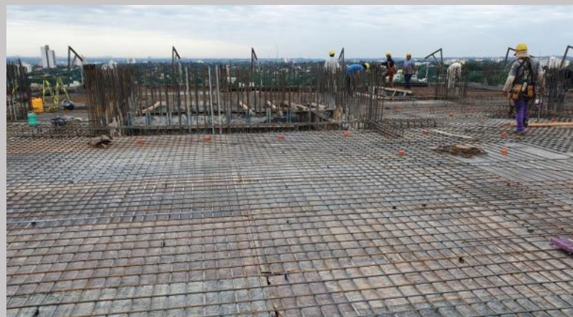
Avance del encofrado piso 13
