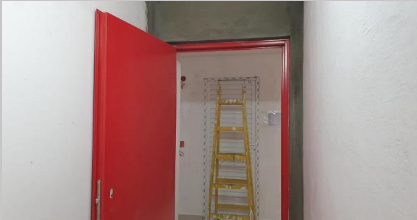
Colocación de puertas cortafuego
