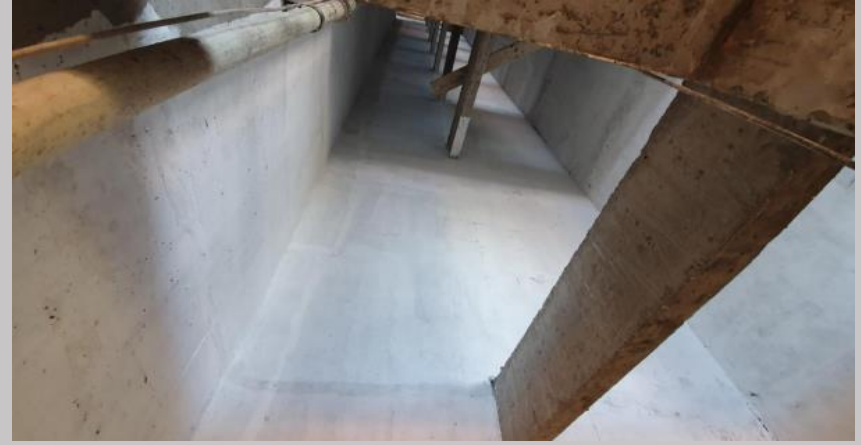
Prolijado y pintado de la caja de ascensores
