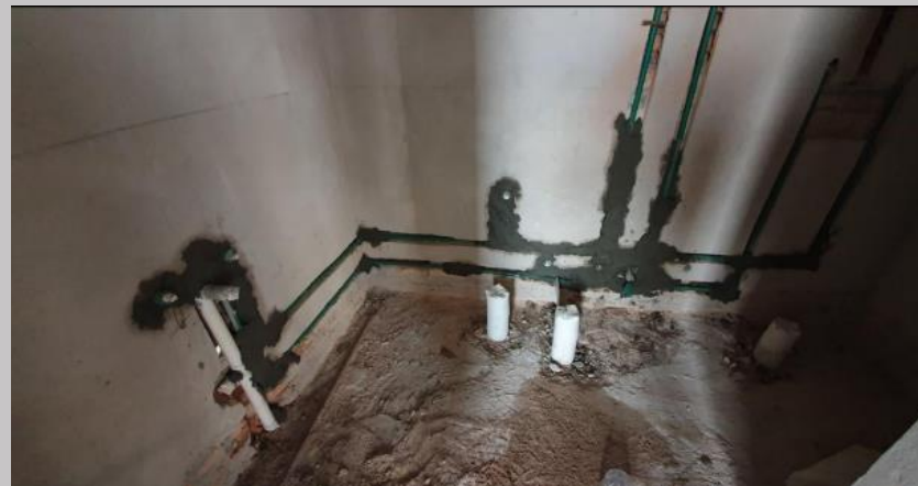
Agua y desagües en baños del piso 5
