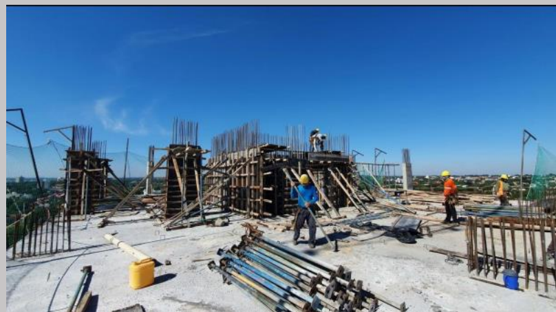
Encofrado y hormigonado de los pilares hasta nivel del piso 13
