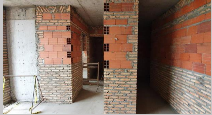
Mampostería en el 7E
