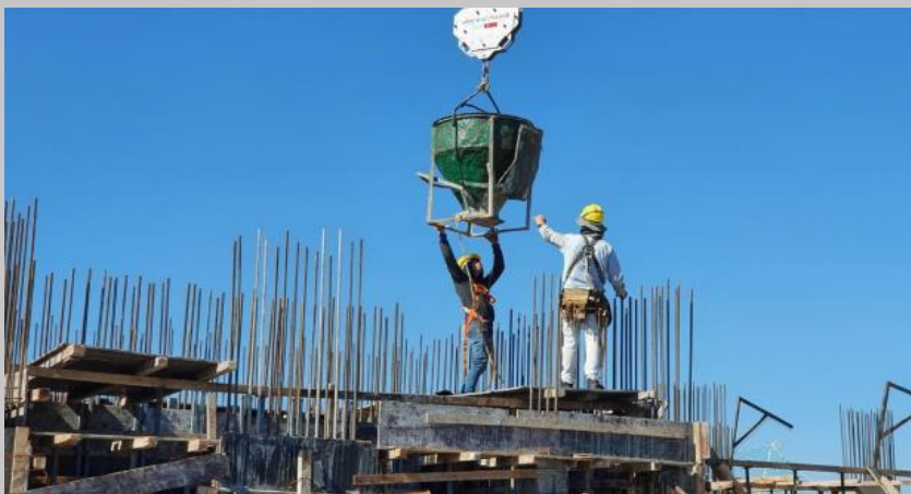
Hormigonado de la caja de escalera y ascensores hasta piso 13
