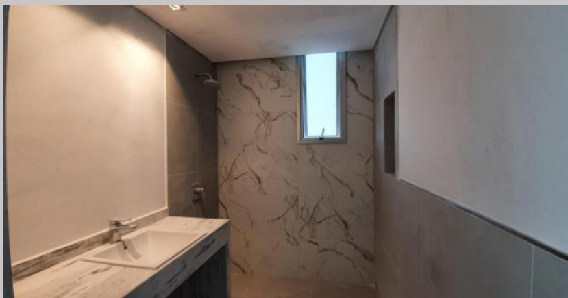
Terminaciones en baño del 1E
