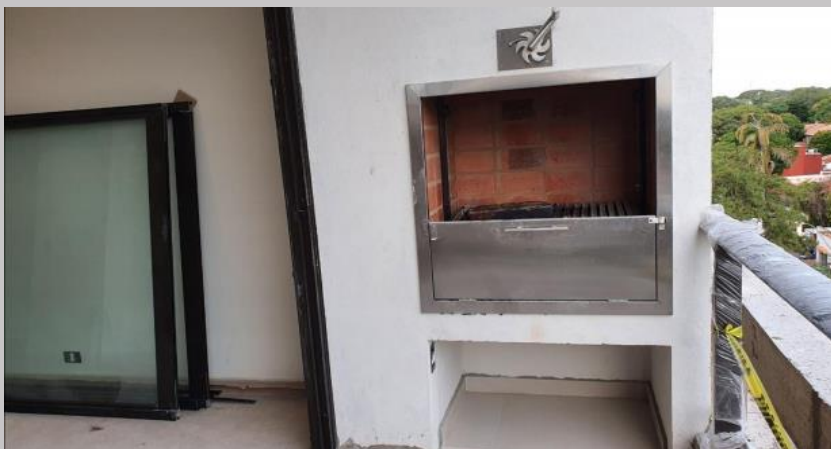
Montaje de parrilla en el primer piso
