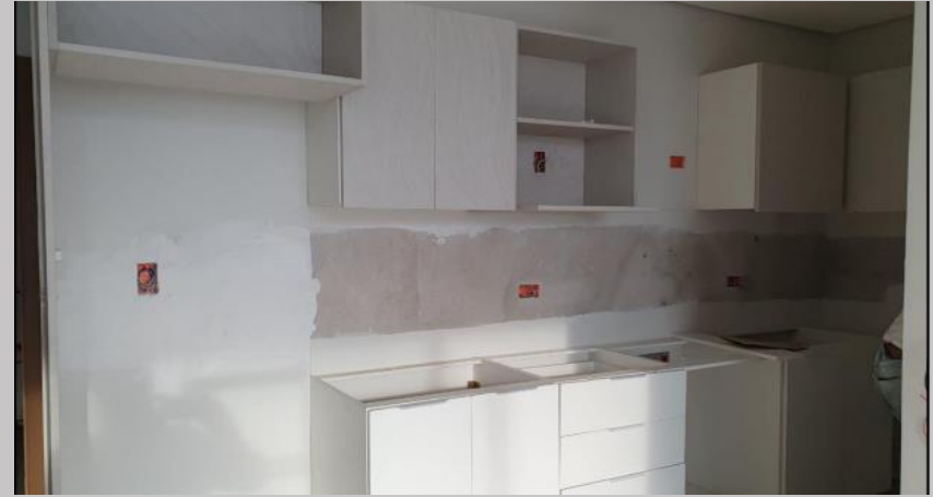
Montaje de muebles de cocina en el 1B
