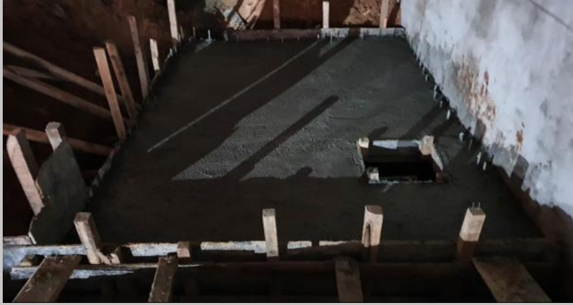
Tanque sumidero cloacal en el sub suelo
