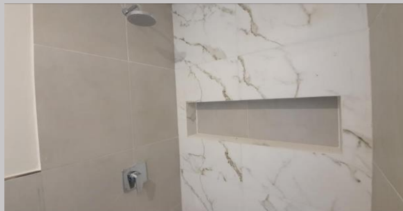
Detalles de la mezcladora y nicho en el baño del 1A
