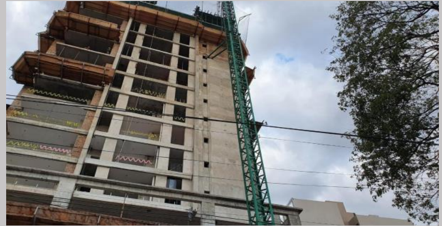
Una vista del avance en el revoque y mochetas de fachadas
