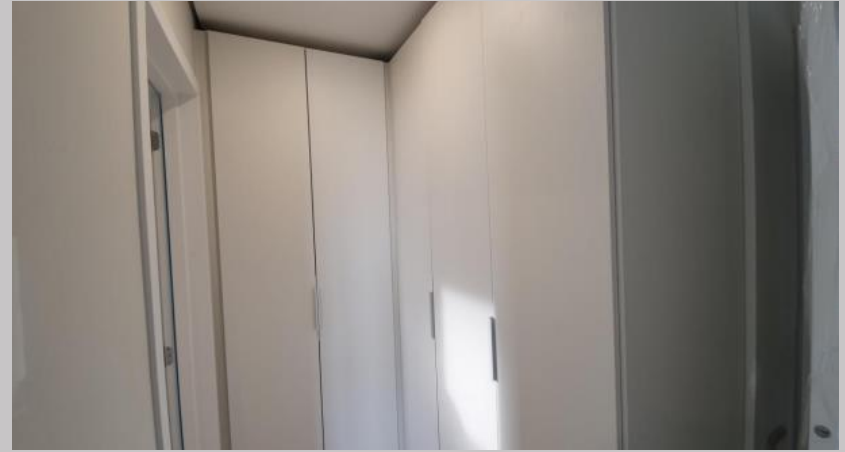
Montaje de placares en el 1C
