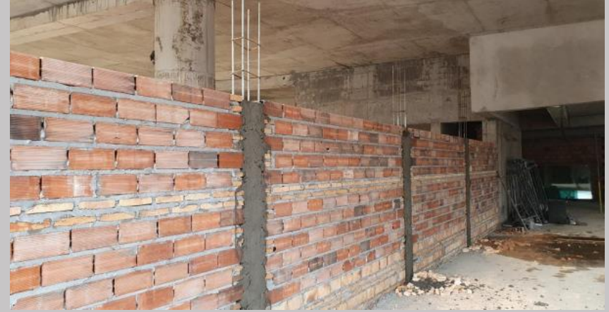
Cerramiento en acceso planta baja
