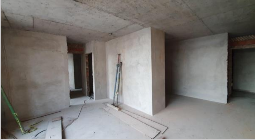
Carpeta piso y revoque de paredes en el 6C
