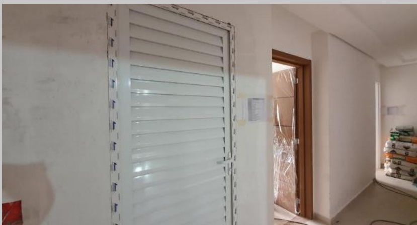
Puerta acceso a baulera en palier del piso 1
