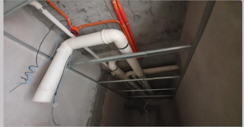
Desagües en baño del 2E
