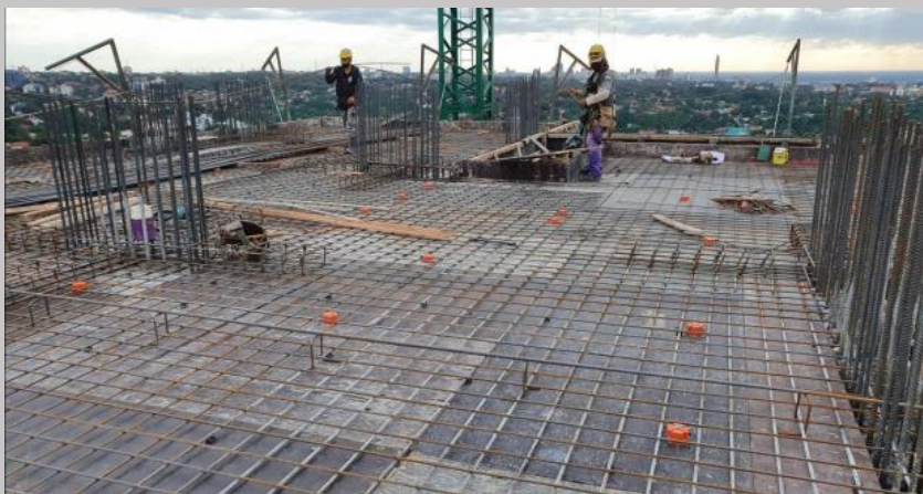
Encofrado, armaduras e instalaciones para la losa del nivel de piso 13
