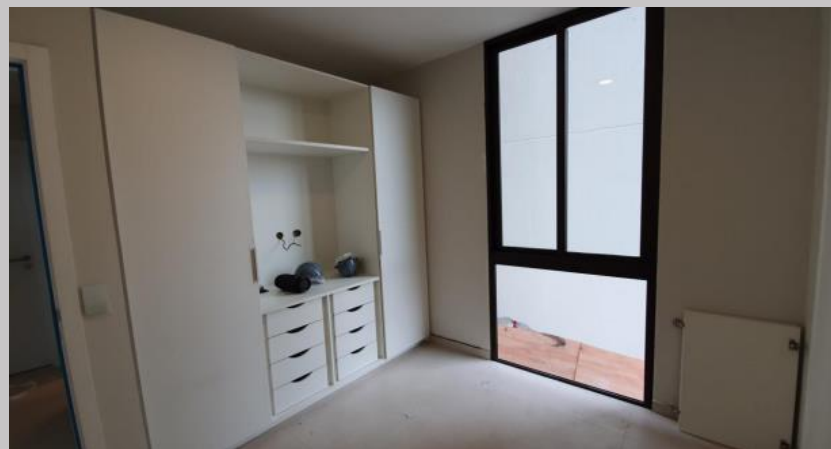
Montaje de placar y aberturas en el 1F
