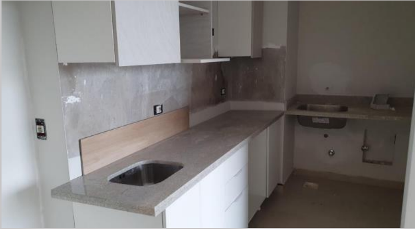
Montaje muebles de cocina, mesada y bacha en el 1F
