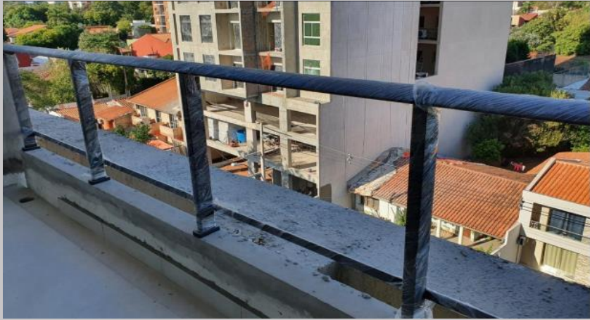
Montaje de barandas en el piso 1
