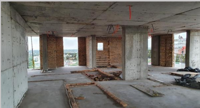
Cerramientos en linderos del piso 9
