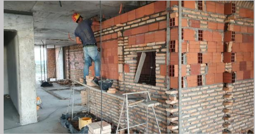
Avance de las paredes en el piso 8 de departamentos
