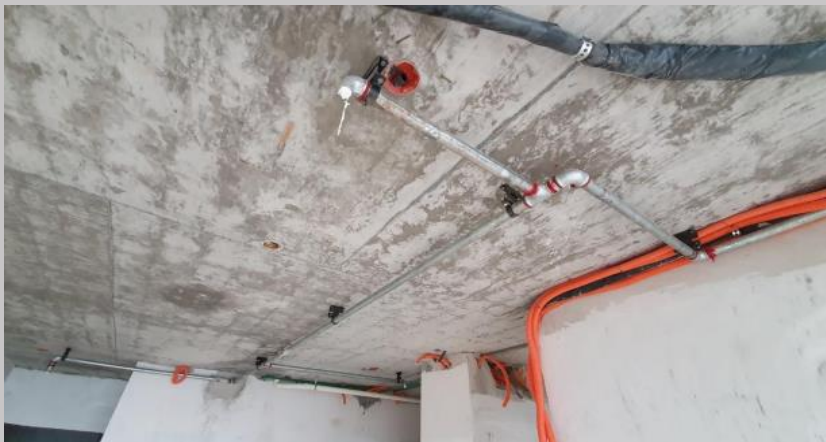
Colocación PCI piso 4
