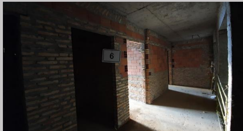
Vista actual palier piso 6
