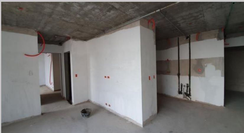
Enduido una mano e instalaciones en el 5C
