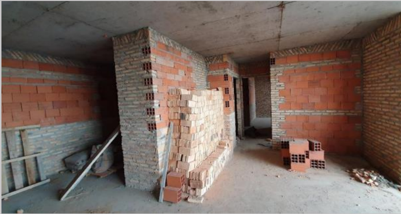
Mampostería en el 7D
