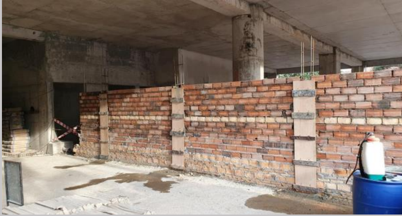
Mampostería pilarizada y envarillada en acceso planta baja
