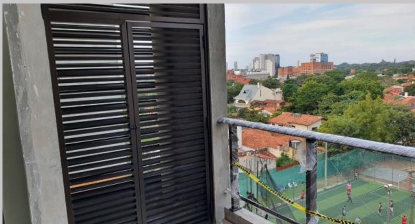
Detalle de la abertura acceso a sector técnico de compresores piso 1
