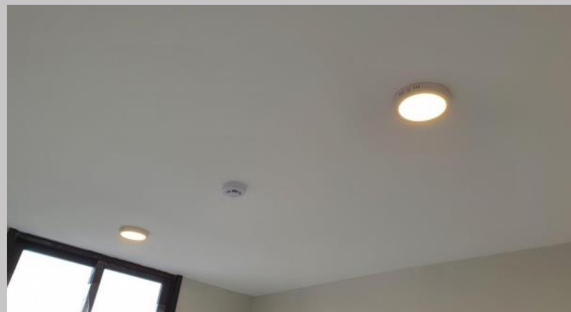
Artefactos de iluminación y sensor H/C piso 1
