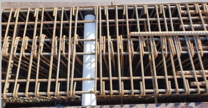
Pasantes pluviales y eléctricos dejados en las vigas maestras
