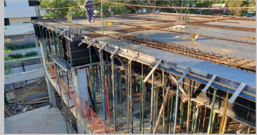
Encofrado de la primera planta de departamentos
