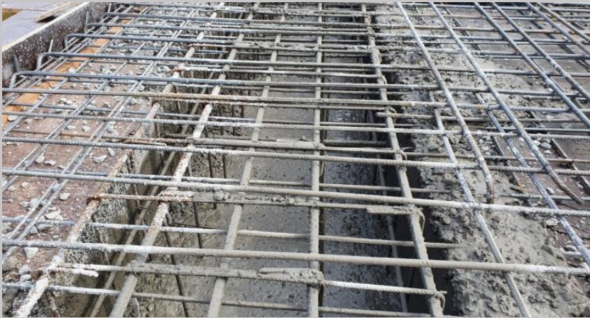
Etapa de llenado de las vigas cada tercio de su altura por vuelta
