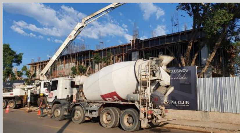
Logística para la jornada de hormigonado del nivel
