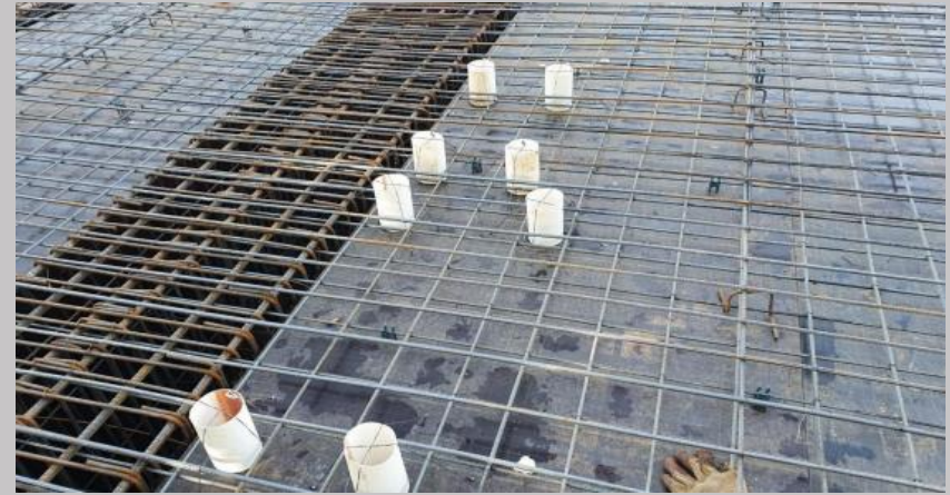
Viga de transición y pasantes sanitarios en posición
