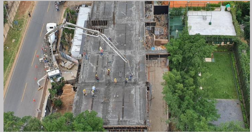
Una toma en altura del hormigonado primeramente de todas las vigas
