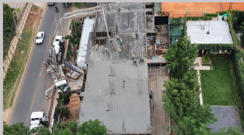
Vista aérea del avance del hormigonado de la losa
