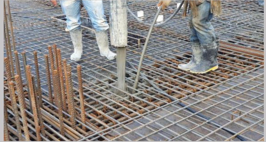
Hormigonado de vigas con el vibrado mecánico del hormigón
