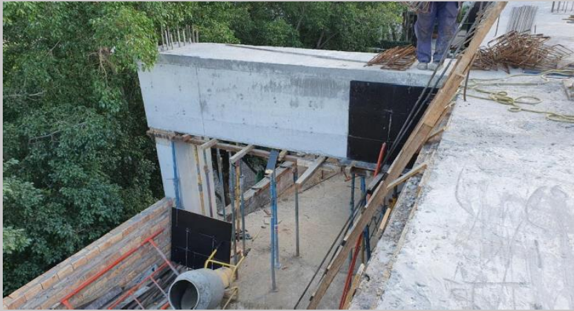
Vista de una de las vigas maestras ya sin el encofrado lateral
