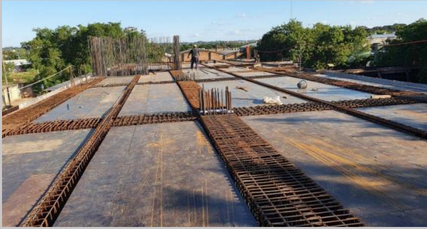
Vista de las armaduras de las llamadas vigas maestras o de transición
