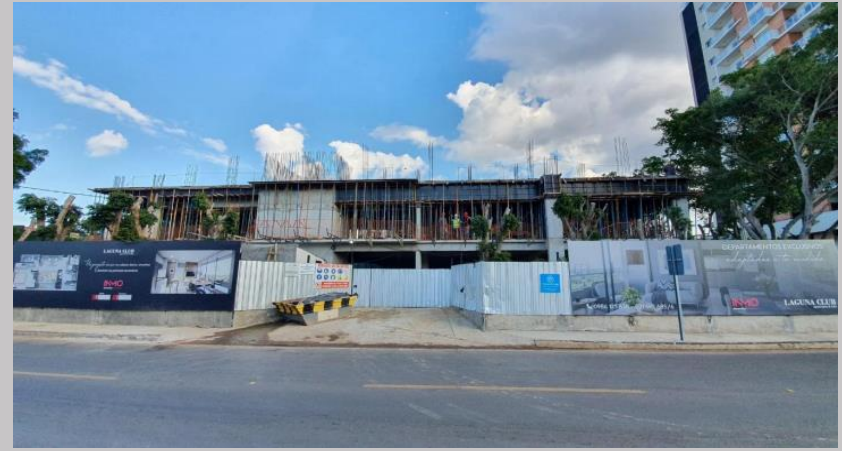
Una vista actual del avance en la estructura
