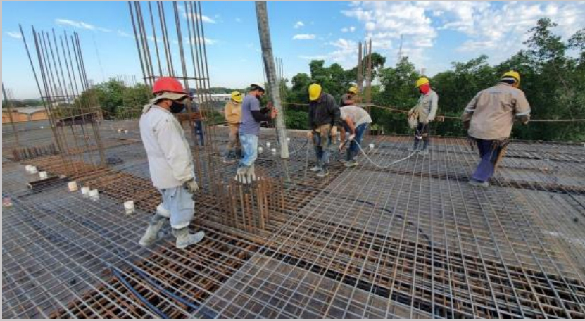
Inicio con el hormigonado de las vigas
