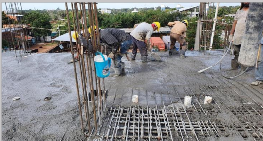
Hormigonado y terminación de las losas del primer piso
