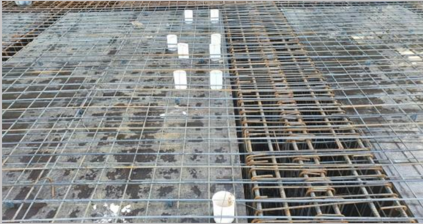
Armatura de las losas y colocación de los pasantes sanitarios
