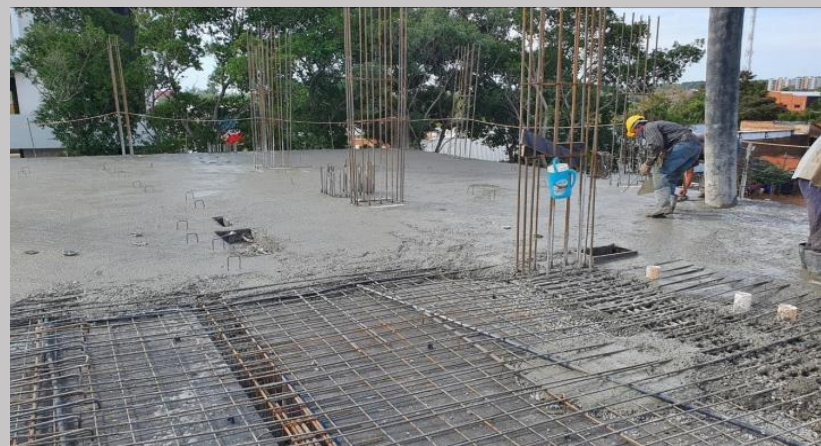
Avance del cargamento con el cargado del nivel de la losa
