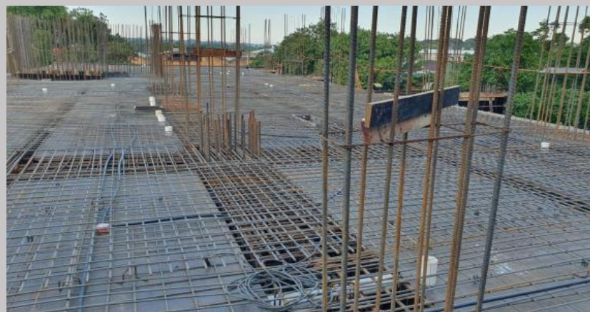
Instalación de cajas y electroductos y los arranques de los pilares que nacen
