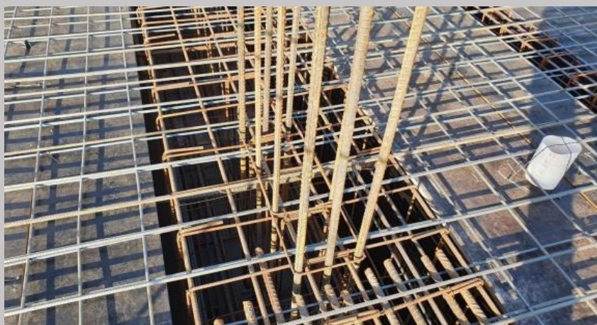
Arranques de los nuevos pilares ya para las siguientes plantas
