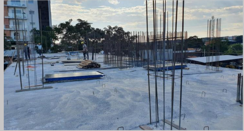
Trabajo actual de preparación de los pilares para el siguiente nivel
