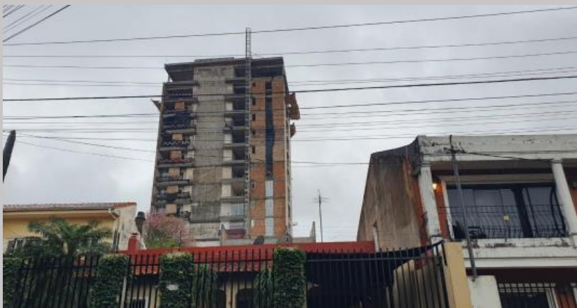
Vista actual de la fachada posterior
