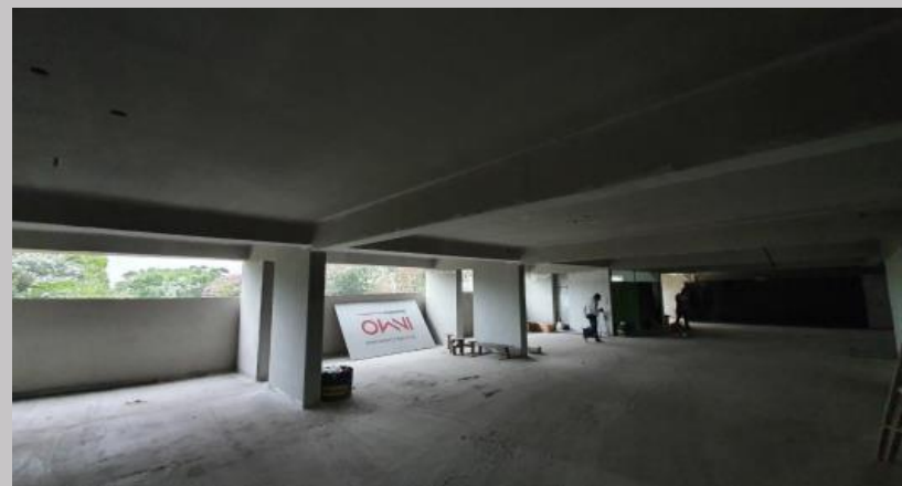
Vista actual del estacionamiento 2
