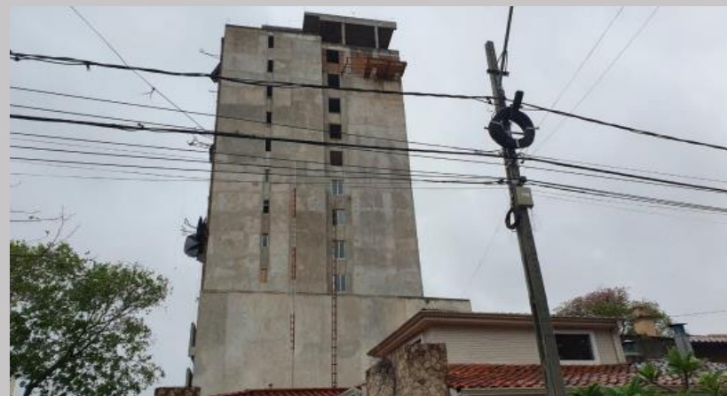
Revoque de otra de las fachadas laterales
