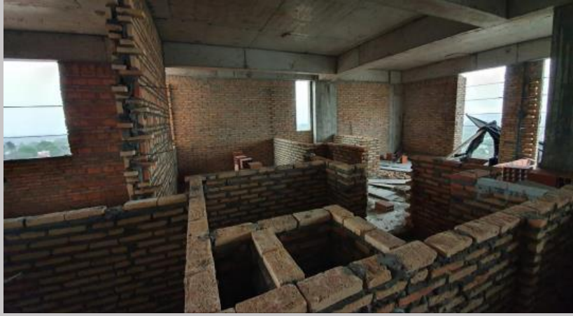
Cerramiento en el piso 9
