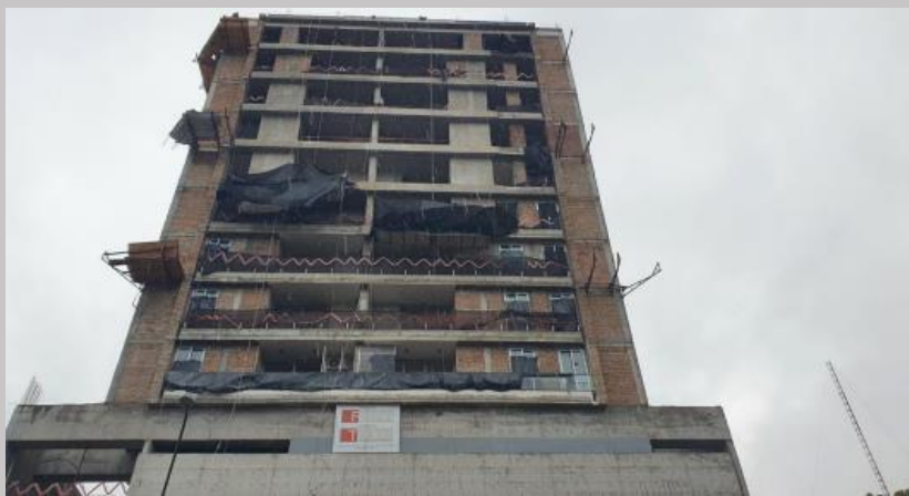
Vista actual de la fachada principal
