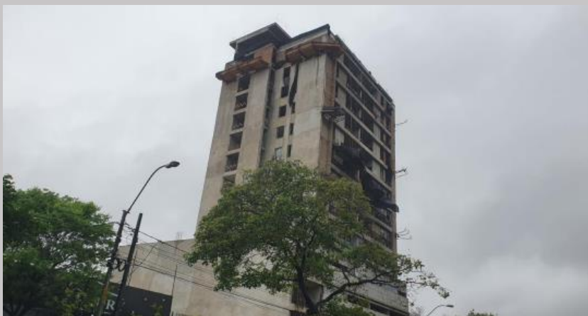
Vista actual del avance en el revoque de una de las fachadas
