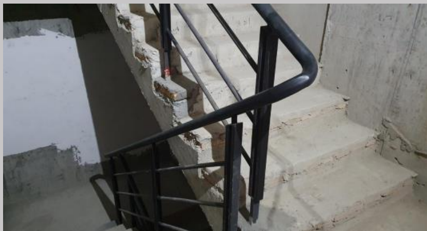
Colocación de baranda
