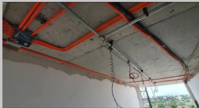
Eléctrica, AA y PCI en el 5D
