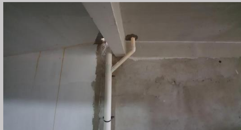
Cañerías de bajada pluvial
