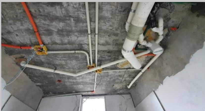
Instalación cloacal piso 5
