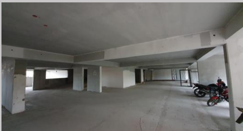
Vista actual del nivel de estacionamiento 1
