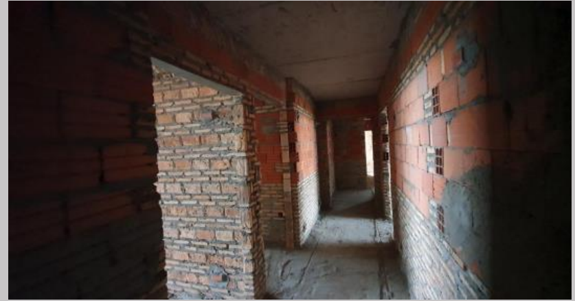
Vista actual de las mamposterías en palier del piso 8
