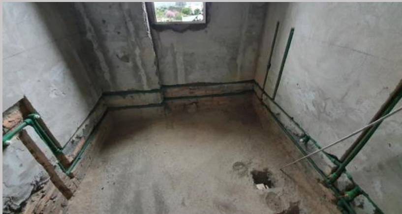
Instalación de agua en baños del piso 6
