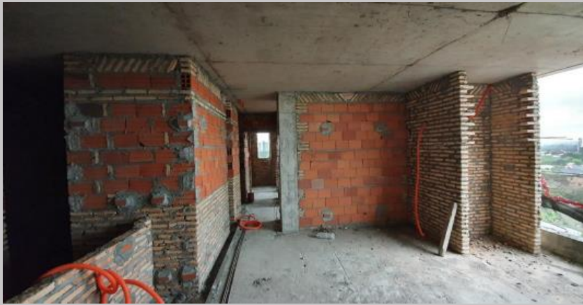
Cerramientos de mampostería en el piso 8 dpto. B
