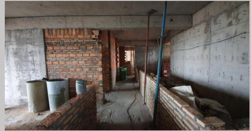
Avance de la mampostería en el piso 9
