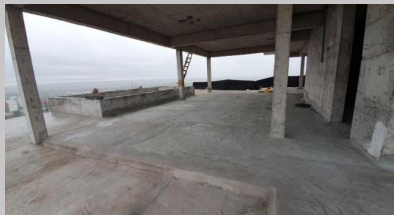
Vista de la zona del quincho en azotea
