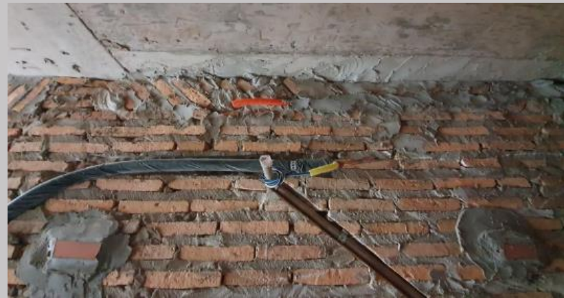
Ducteado de AA y desagüe en piso 7
