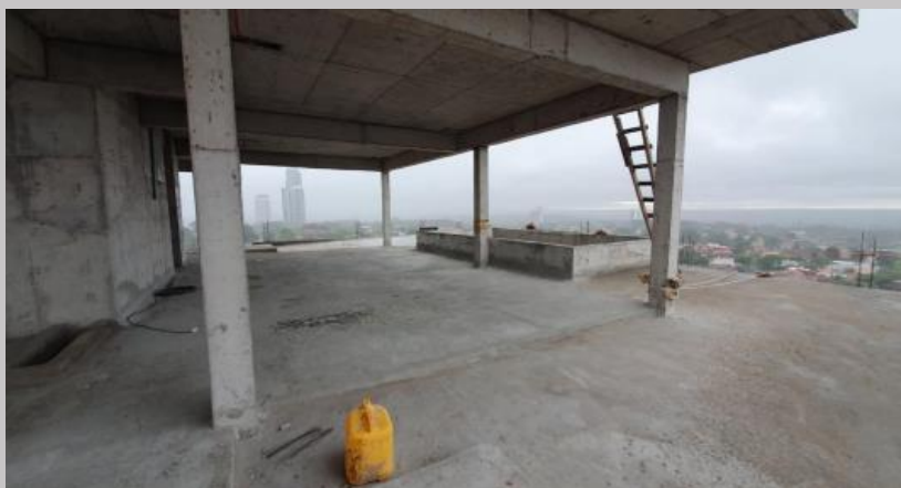
Vista de la azotea
