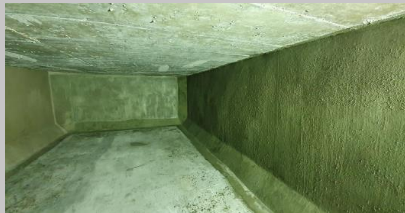
Tratamientos de impermeabilización en tanque inferior de agua
