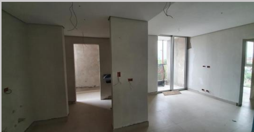
Cielorraso, piso y una mano de enduido en el 2E
