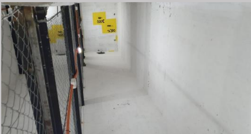
Instalaciones previas al montaje de los ascensores
