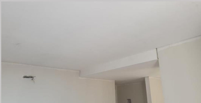
Colocación de cielorraso en el 4E
