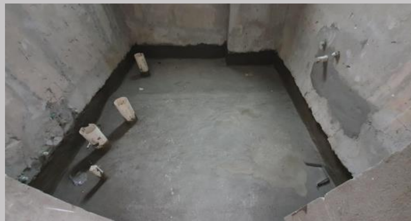
Tratamiento de aislación baños del piso 4
