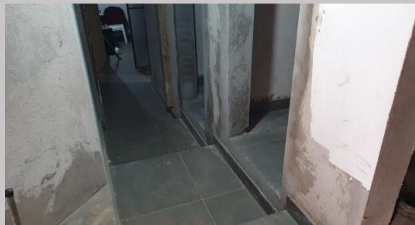
Sector de bauleras, deposito y baño en planta baja
