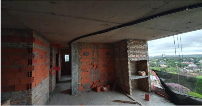
Mamposterías, contrapiso y AA en el 7D
