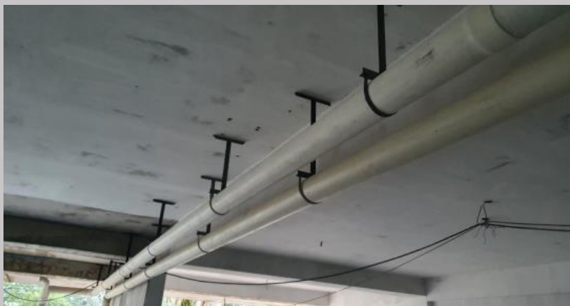
Líneas de cañería pluvial fijadas bajo losa techo de planta baja
