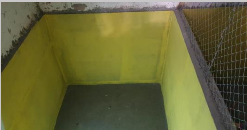
Trabajos de aislación y pintura en bajo recorrido de los ascensores
