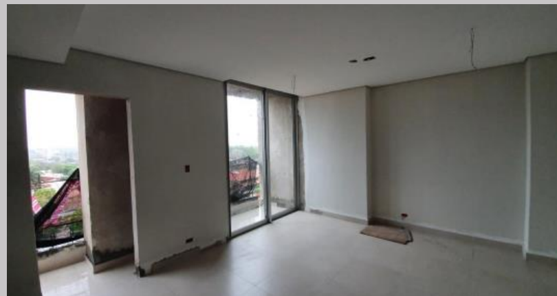
Aberturas, vidrio, piso y cielorraso en el 4A
