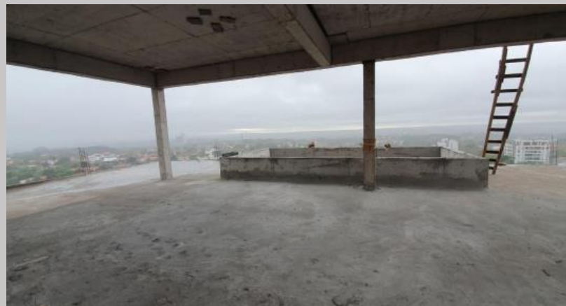
Vista actual del avance en azotea
