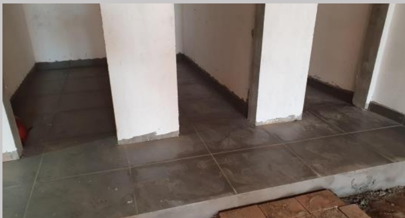
Piso en bauleras de planta baja
