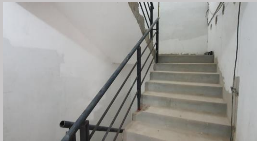
Enduido una mano y colocación de baranda en caja de escalera
