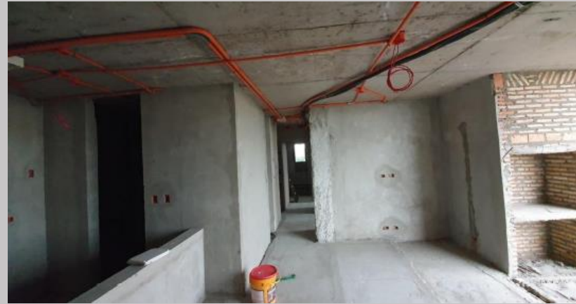
Revoques e instalaciones en el 6B
