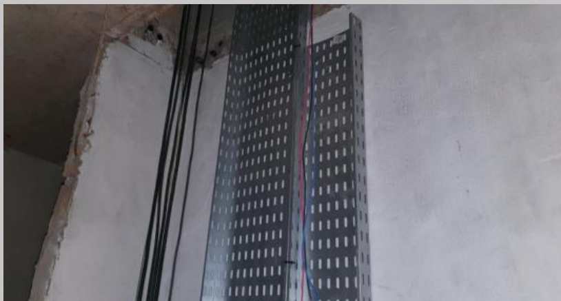
Montajes en la montante eléctrica
