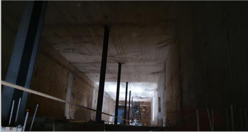
Vigas metálicas en T para soporte de las guías en cajas de ascensores
