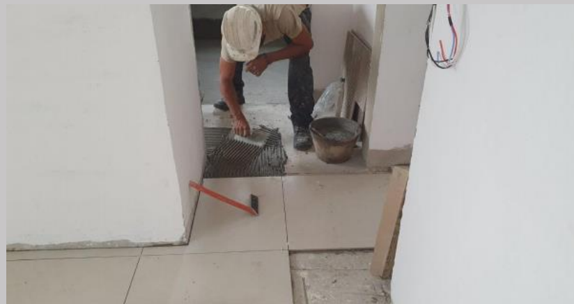
Colocación de piso en el 3C
