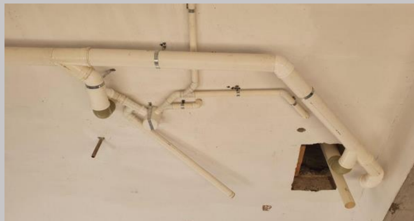
Desagües cloacales bajo losa de los baños del piso 1
