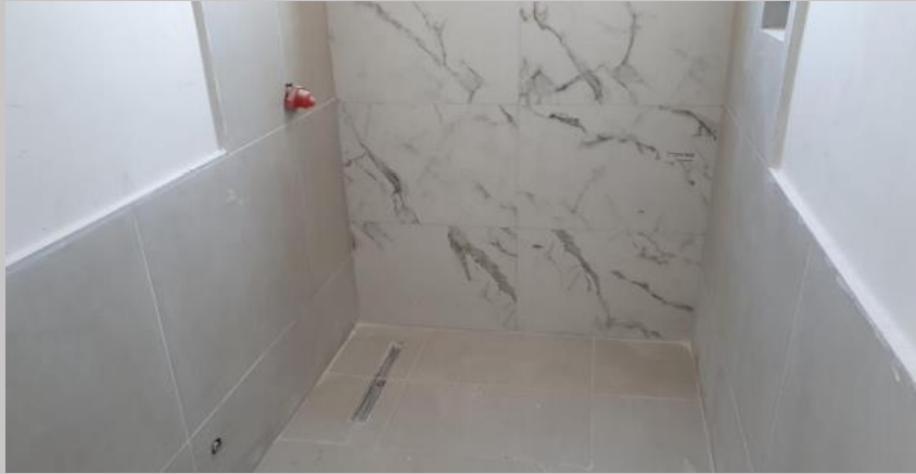
Detalle de revestido en baño del piso 2
