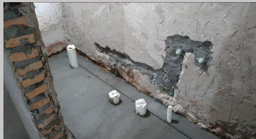
Instalación sanitaria en baños de planta baja
