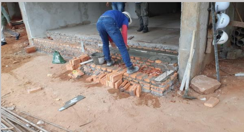
Trabajos en sectores del acceso
