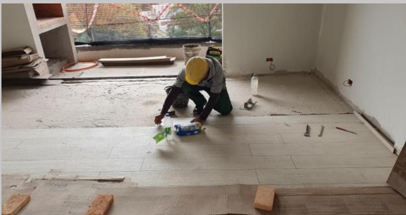
Colocación de piso en el 2B
