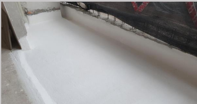
Aislación del balcón en el 3C
