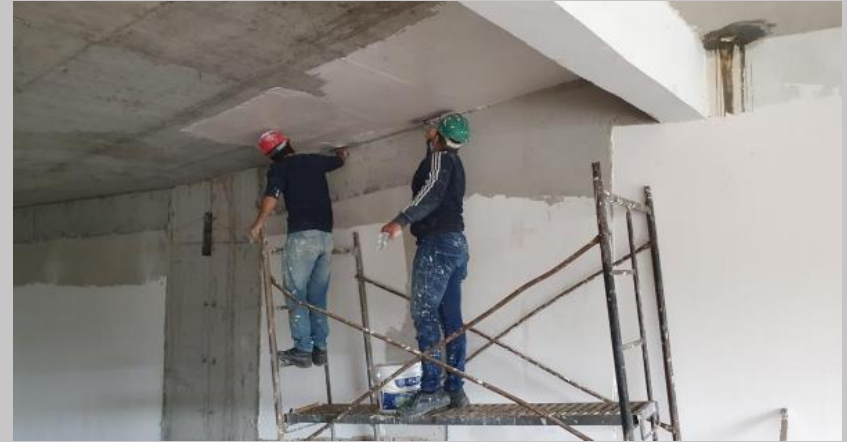
Regularización y enduido fondo de losa techo en E1
