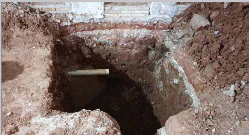
Excavación para sumidero cloacal en planta baja
