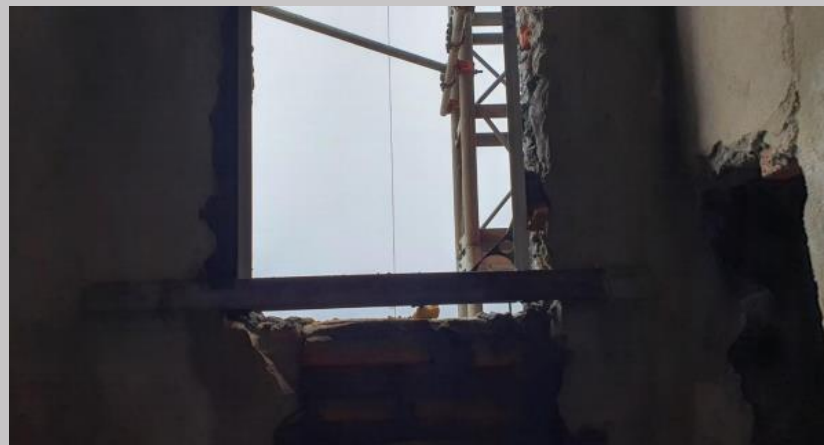
Colocación de pre marcos de aberturas en el piso 4
