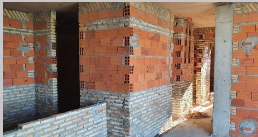
Mamposterías en el 6B
