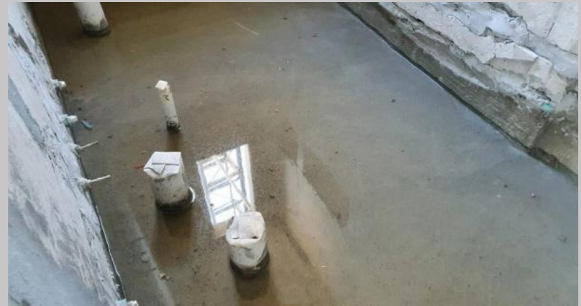
Prueba de estanqueidad de aislación en baños de piso 4
