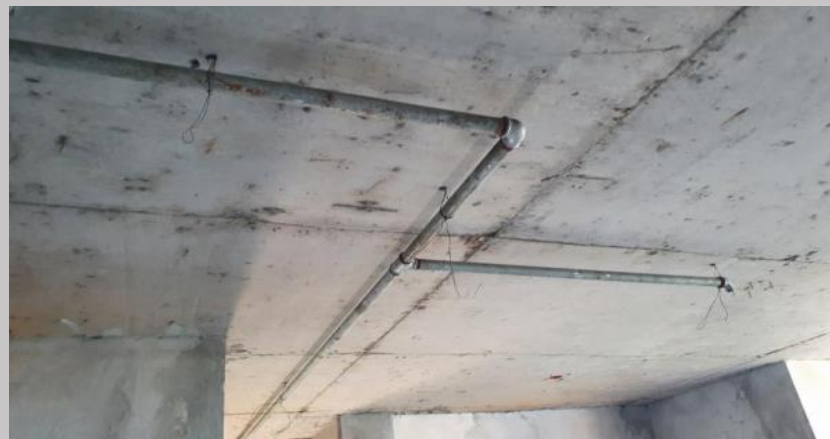
Ducteado galvanizado para PCI en el 5B
