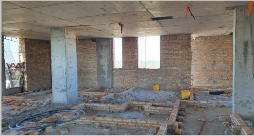
Cerramiento laterales en linderos del piso 8
