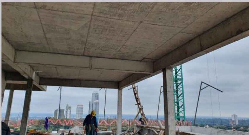
Losas de techo ya totalmente desencontradas
