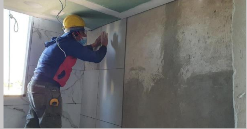
Revestido de baño en el 3C
