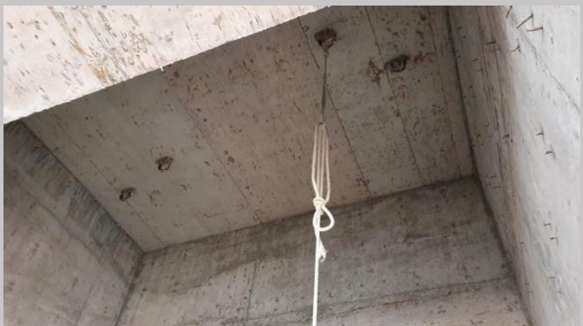
Tapas de losa del sobre recorrido y ganchos para montaje de los ascensores ya terminados
