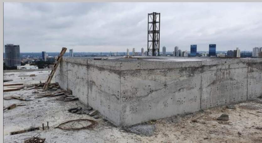
Tanque superior de agua y tapas de ascensores y escalera
