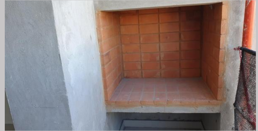
Parrilla en el piso 2
