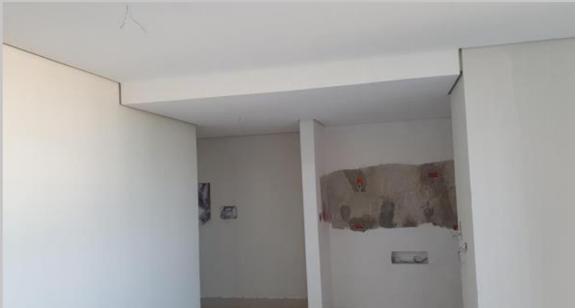
Enduido de paredes y cielorraso en el 3E
