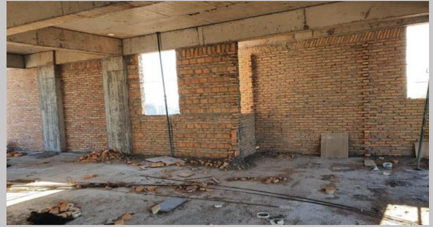
Cerramientos laterales en linderos del piso 9
