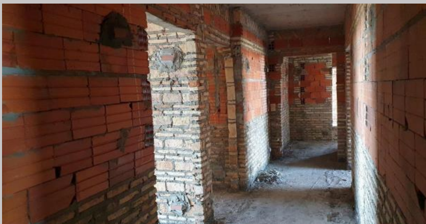
Mamposterías en el piso 6
