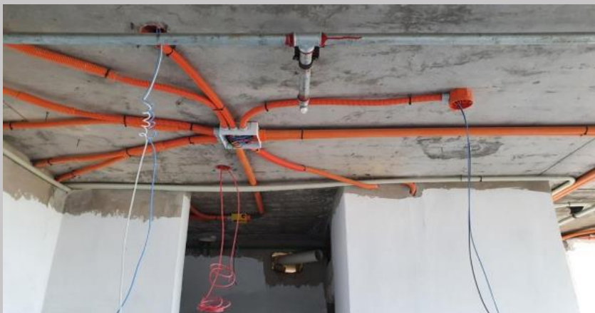
Instalación eléctrica y cableado en departamentos del piso 4
