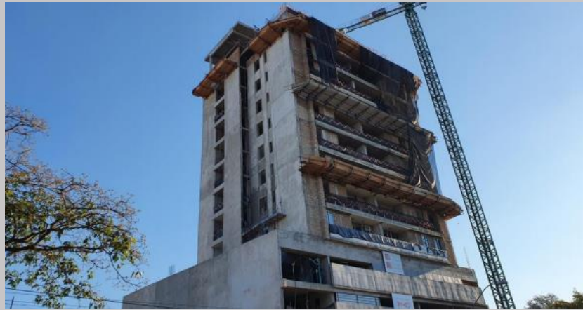
Una vista del avance del revoque en una de las fachadas laterales
