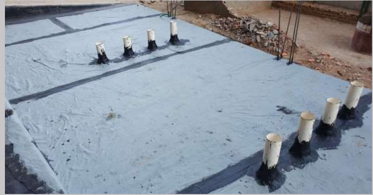
Aislación y pasantes eléctricos previos al posicionamiento de los transformadores
