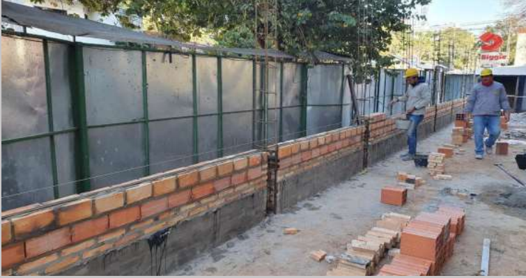
Mamosterías exteriores hacia calle Pacheco en planta baja
