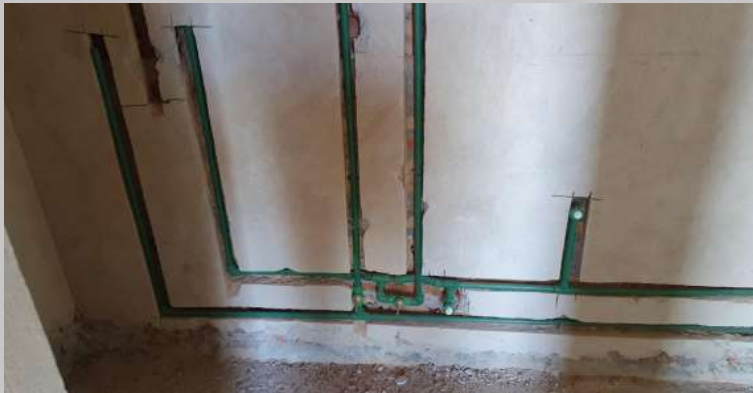
Instalación de agua cañerías por termofusión en el piso 6
