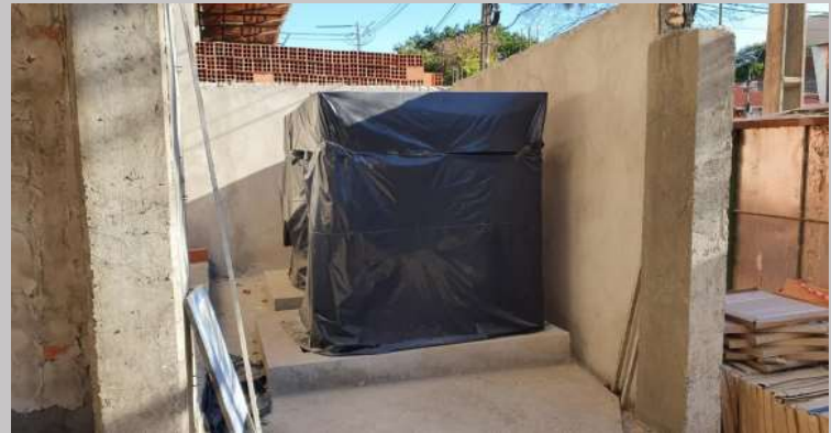
Trafos ya en su sitio con su base y mamposterías
