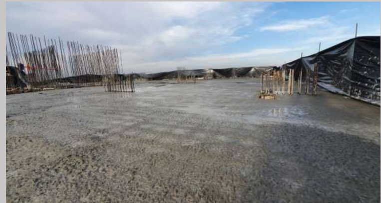
Vista de la losa ya totalmente hormigonada- nivel piso azotea
