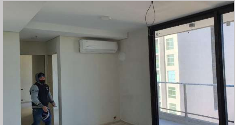
Aberturas, vidrios y artefactos en dpto. del piso 2
