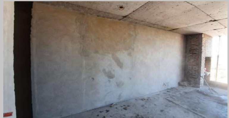
Revoque de paredes en el 7C
