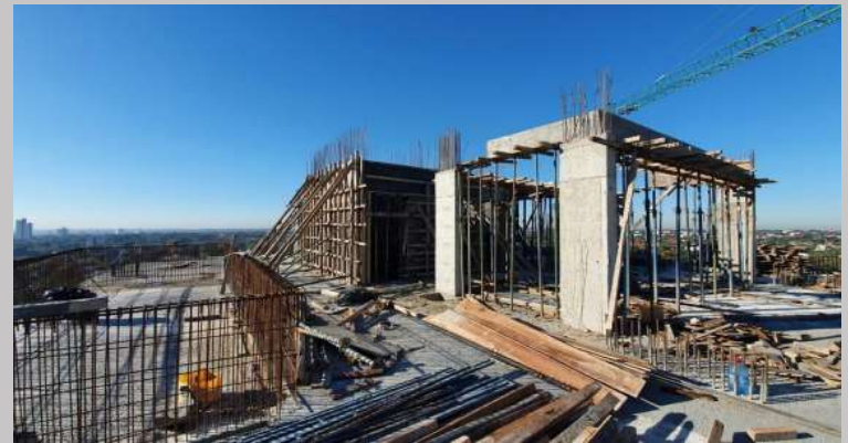
Una vista del avance actual de los trabajos sobre azotea
