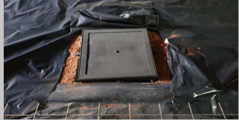
Ubicación de las tapas metálicas para registros y sumideros
