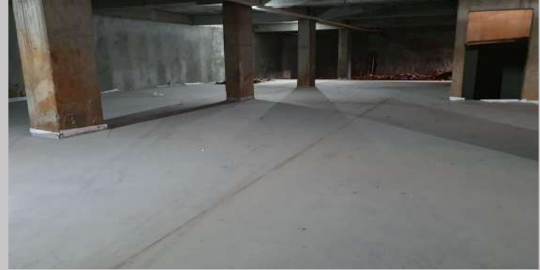
Piso de hormigón helicopteado ya terminado
