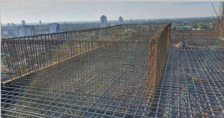
Arranques para los tabiques de la piscina
