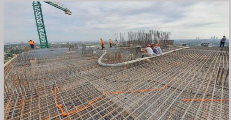
Losa de azotea lista a ser hormigonada
