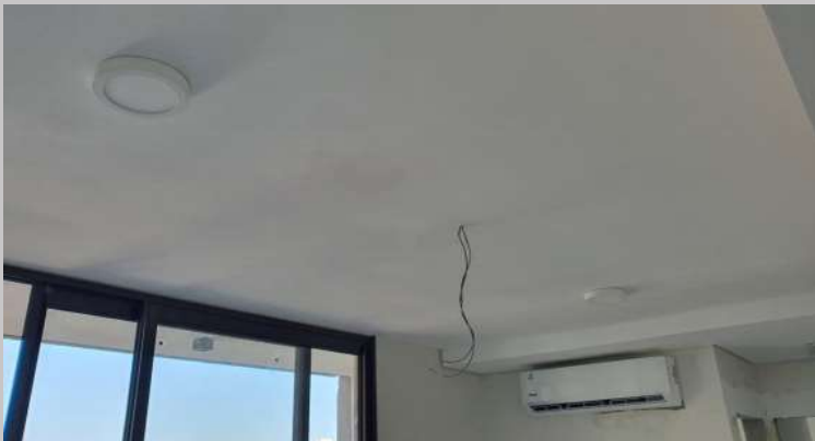
Colocación de artefactos de iluminación en el piso 2
