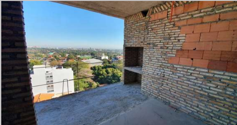
Mamosterías y parrilla en el 8B
