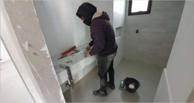
Colocación de mesada en el segundo piso
