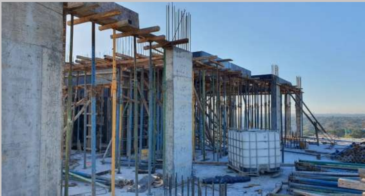
Pilares, vigas y fondo de losa quincho
