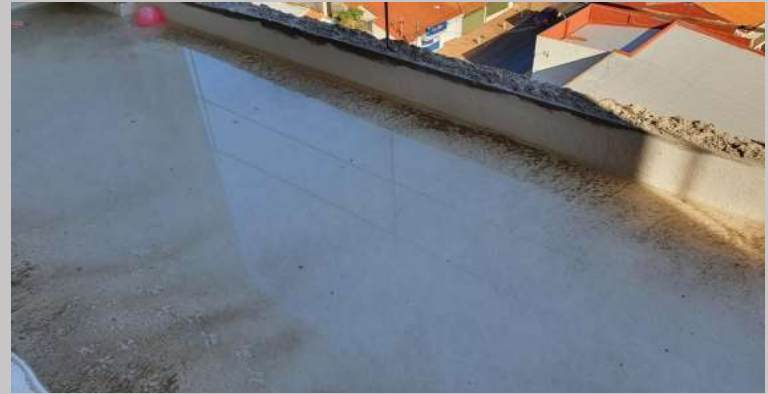
Prueba de la aislación balcones del piso 5
