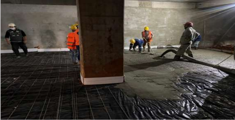
Hormigonado del piso en el sub suelo
