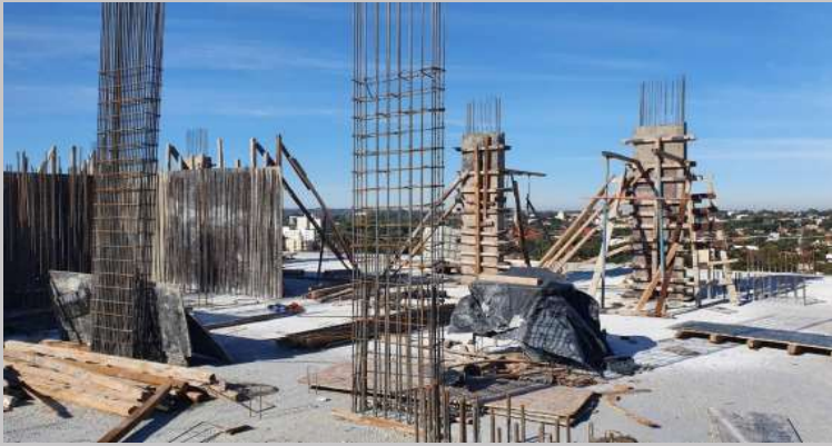
Ya sobre losa los primeros trabajos de pilares y taquiques hasta techo quincho
