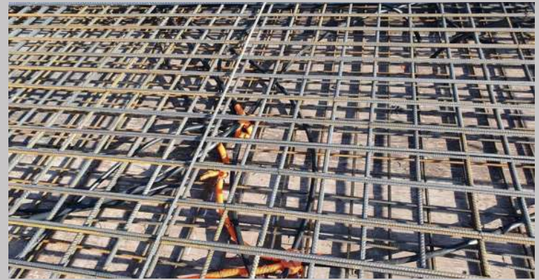
Electrodutos y cajas eléctricas y señales débiles
