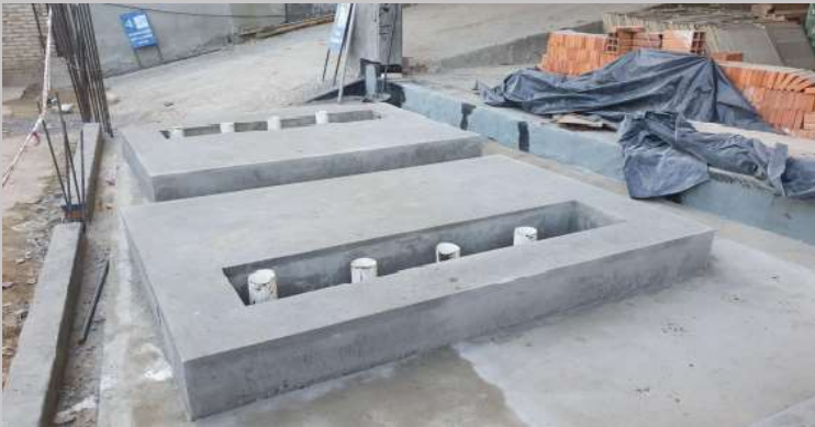
Instalaciones para sector de los trafo listas en PB
