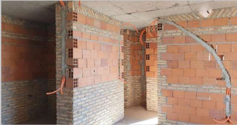
Mamosterías e instalación de electroductos en el 7F
