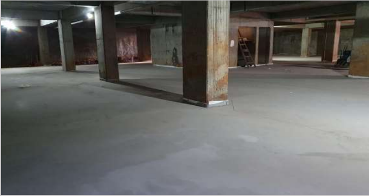
Vista actual del sub suelo
