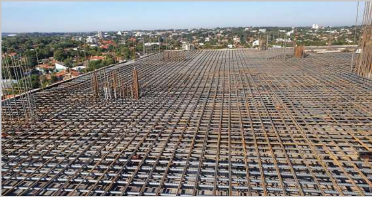
Losa techo del piso 13 o losa azotea con las armaduras de calculo
