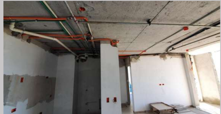
Instalaciones bajo losa del 4F
