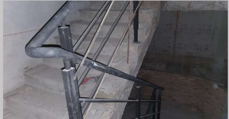
Baranda en caja de escalera presurizada- piso 10
