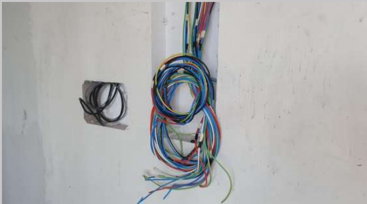
Cableado hasta los tableros en el cuarto nivel
