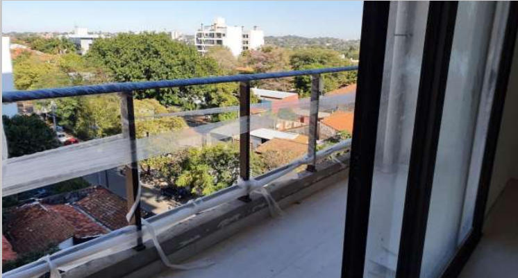
Terminaciones en perfilería de aluminio, barandas y vidrios 2C
