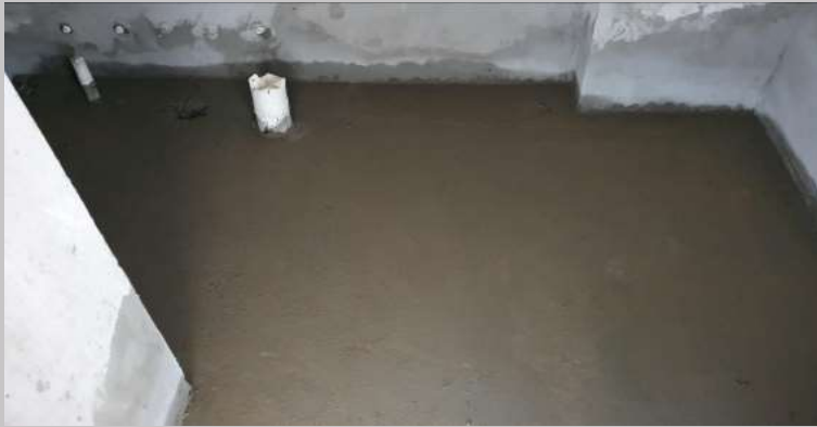
Prueba de agua para la aislación baños del piso 5
