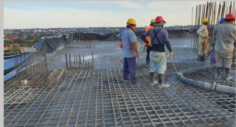
Avance en el cargamento ya en su etapa hasta altura final de la losa
