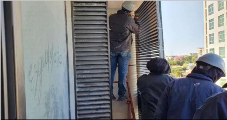
Avances en sectores para los equipos de AA en balcones
