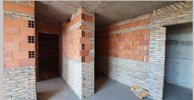
Mamosterías en el piso 9
