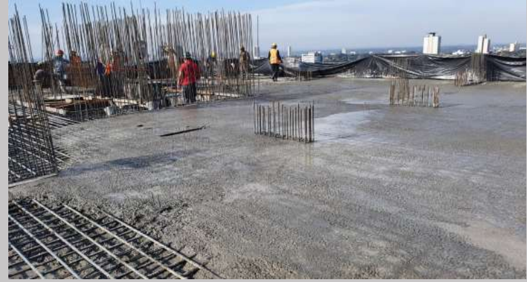
Hormigonado de la losa de azotea ya en su etapa final
