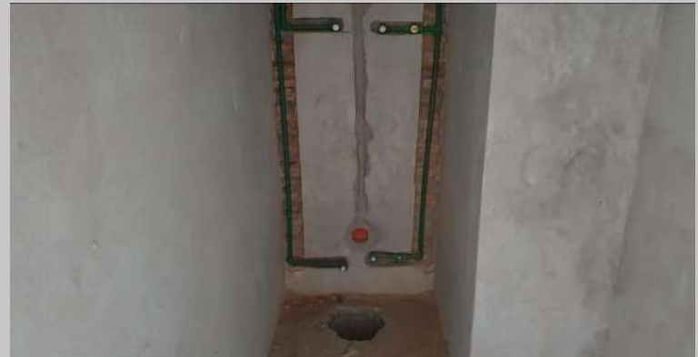
Instalación de agua y desagüe en sector de calefones piso 6
