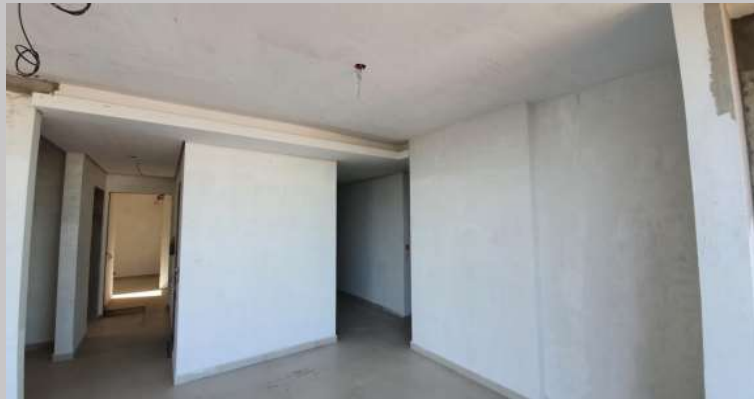
Avance en enduido, piso y cielorraso del tercer nivel
