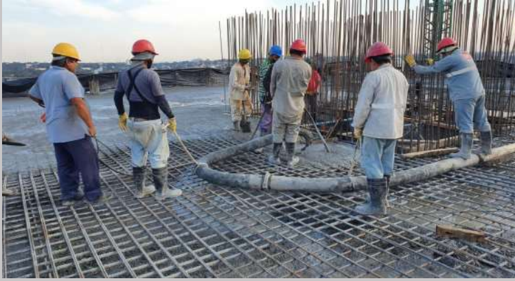
Se van completando los sectores de la losa azotea
