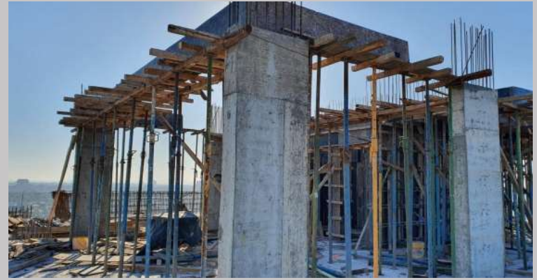
Trabajos de encofrado para la losa quincho primer nivel
