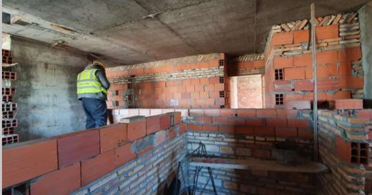
Avance en las mamposterías del piso 10
