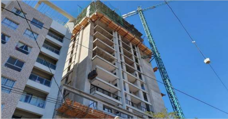
Vista actual desde calle Torreal Viera- Revoques y mochetas de fachada
