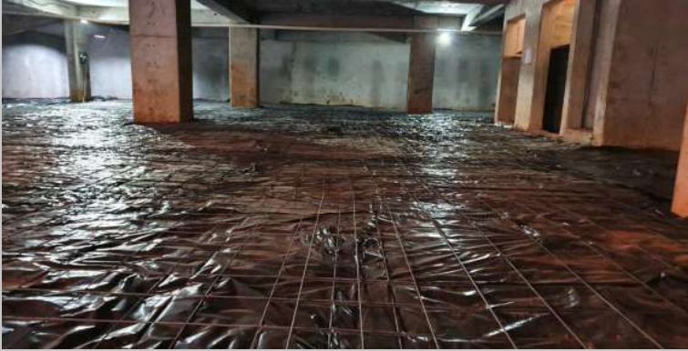
Preparación para el piso de hormigón en el sub suelo
