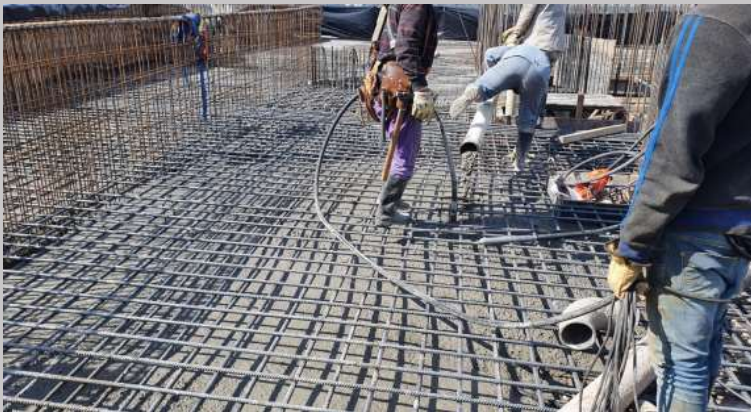
Avance del hormigonado en su primera etapa de llenado
