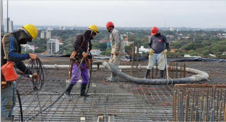
Inicio del hormigonado de la losa de azotea
