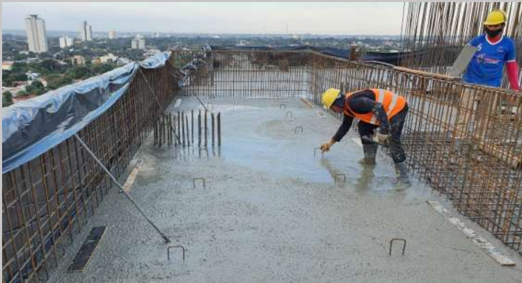
Cargado del sector de la losa fondo de la piscina
