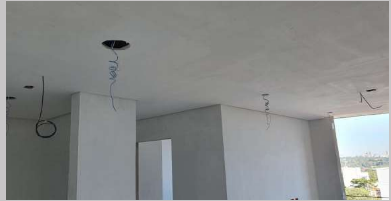
Cielorraso, enduido y cableado en el 3B
