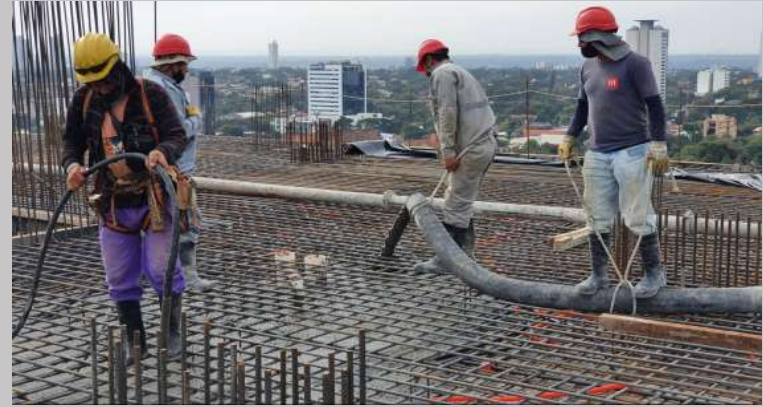
Hormigonado de la losa primeramente hasta mitad de altura - 17cms
