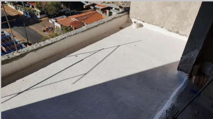
Aislación en balcones del piso 5
