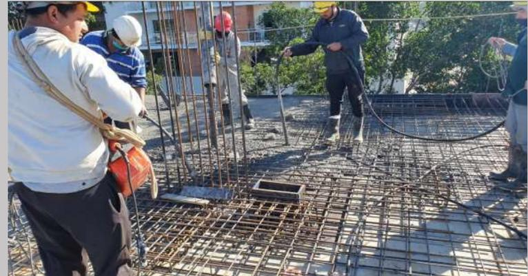
Vibrado mecánico del hormigón
