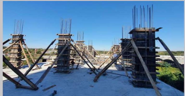
Una vista actual del avance en el encofrado de los pilares
