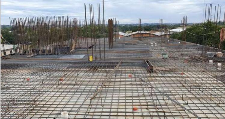
Armaduras y colocación de cajas eléctricas losa piso 2
