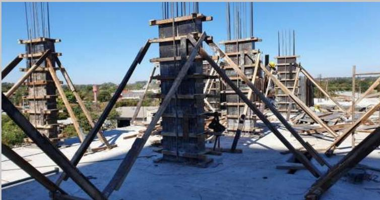
Pilares para el siguiente tramo hasta la losa del piso 3
