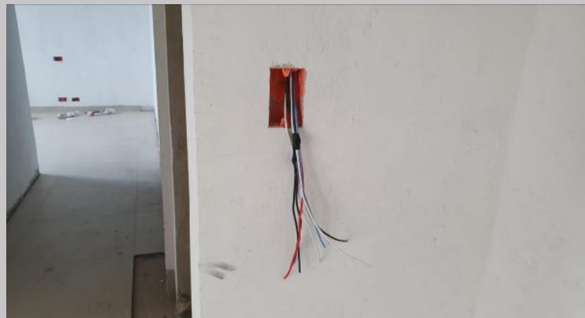
Cableado tercer piso
