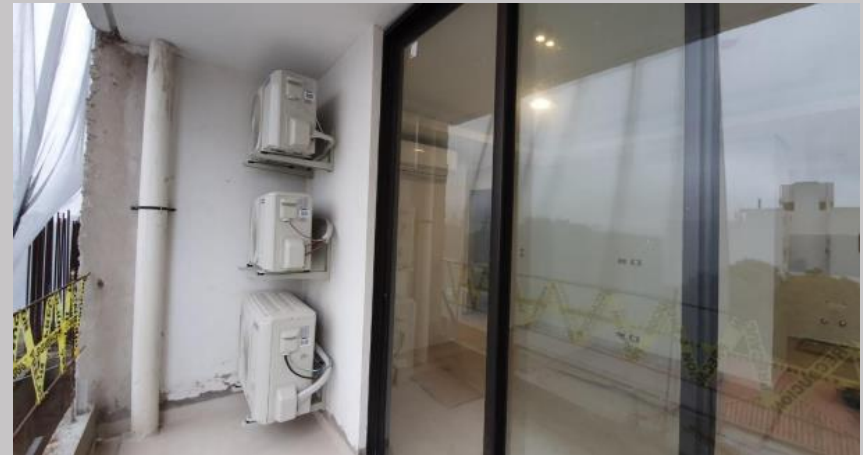
Abertura vidriada de balcón y sector técnico de compresores
