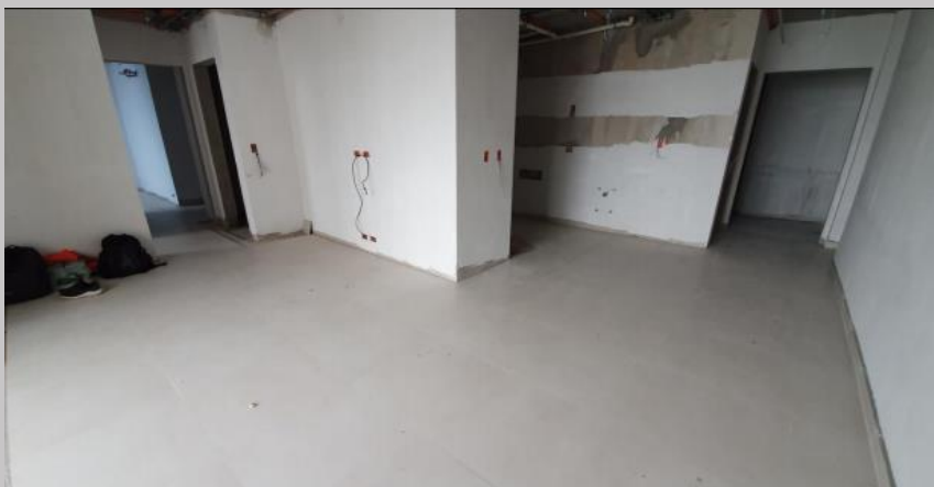
Colocación de piso en el 3C
