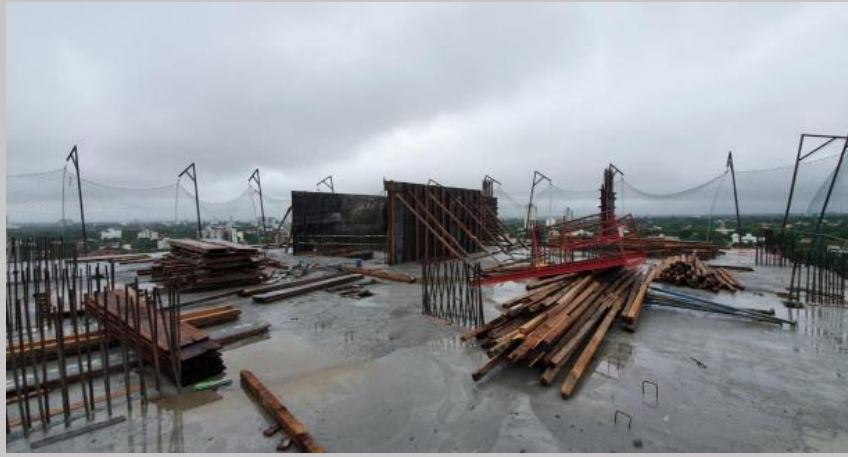
Vista actual de la última planta hormigonada piso 12
