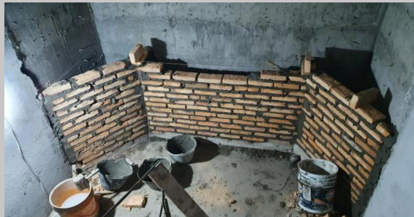
Mampostería de ducto de presurización y sanitario en caja de escalera
