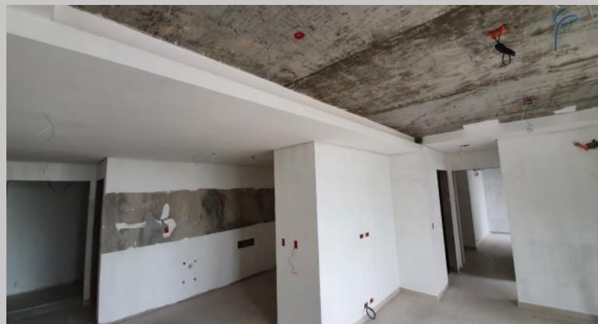
Cielorraso y enduido en el 2D
