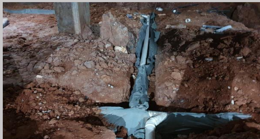
Se avanza en la red de drenaje bajo nivel de piso del sub suelo
