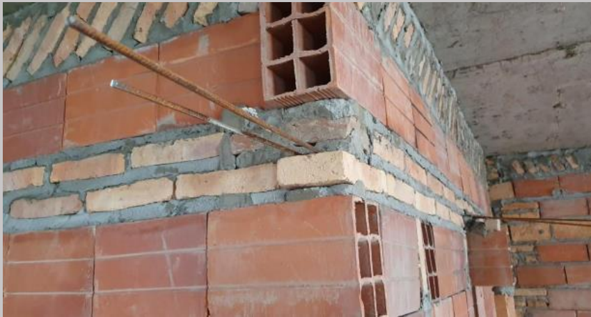
Vista del envarillado de refuerzo en todas las paredes
