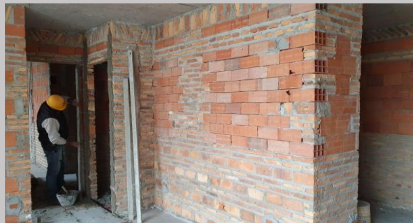
Cerramiento de mampostería piso 6
