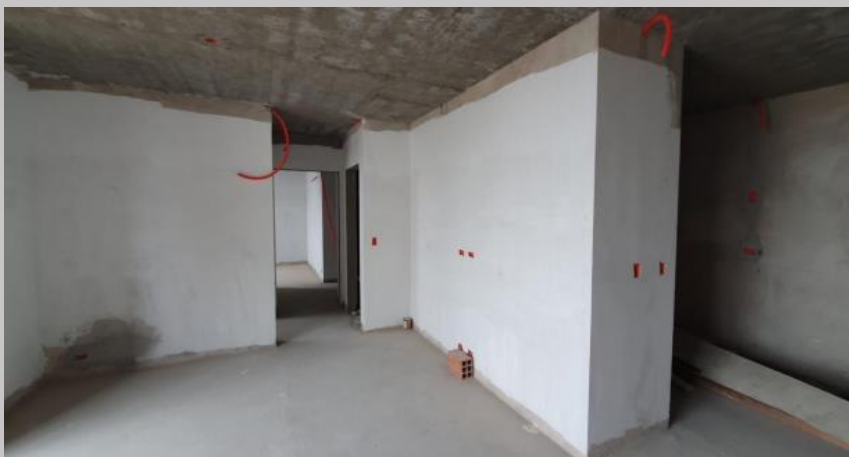
Avances en departamentos del piso 5
