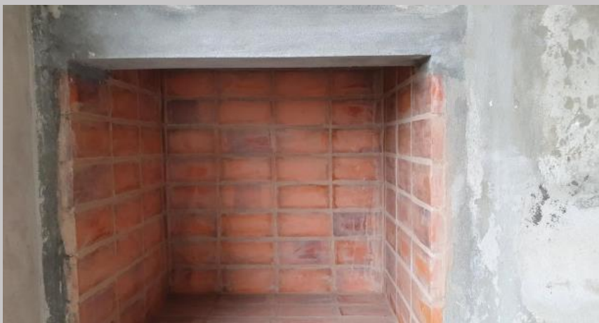
Revestido refractario en parrillas del piso 2
