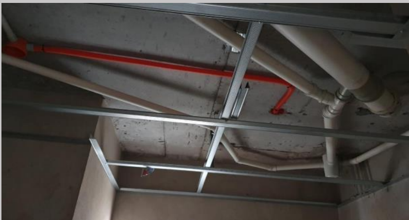
Estructura para el cielorraso en baños del piso 3
