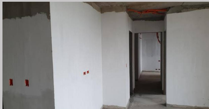
Enduido de paredes en el 5D
