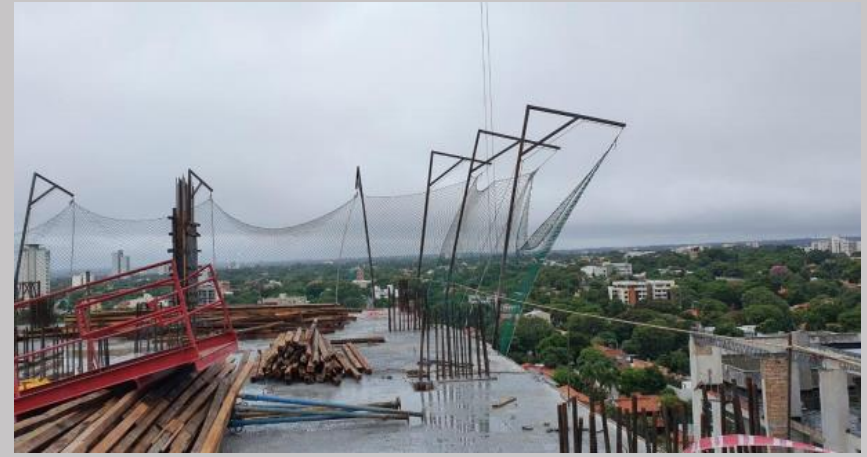
Losa del piso 12 y elementos de protección lateral en altura
