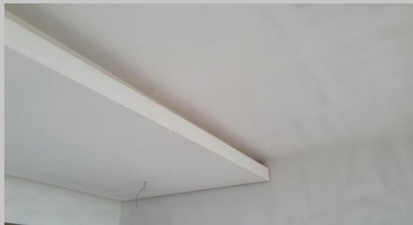
Cielorraso y enduido fondo de losa en el 2E
