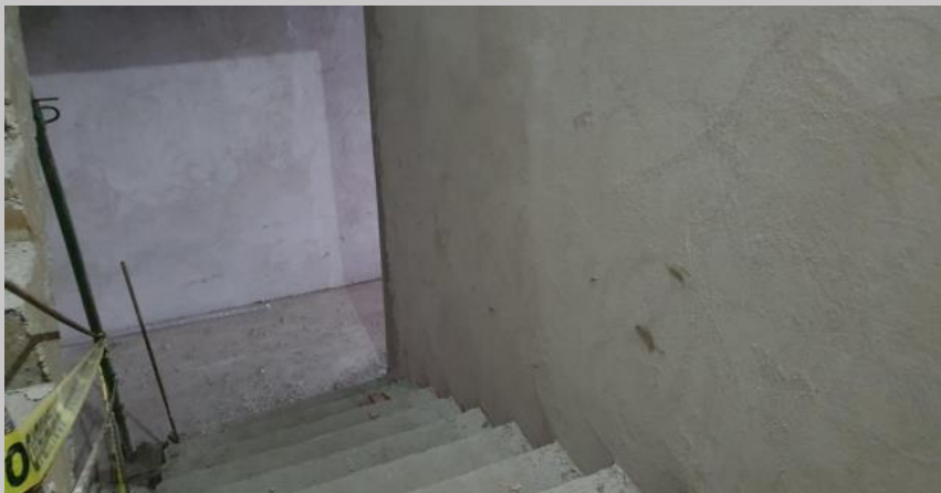
Revoque en caja de escalera
