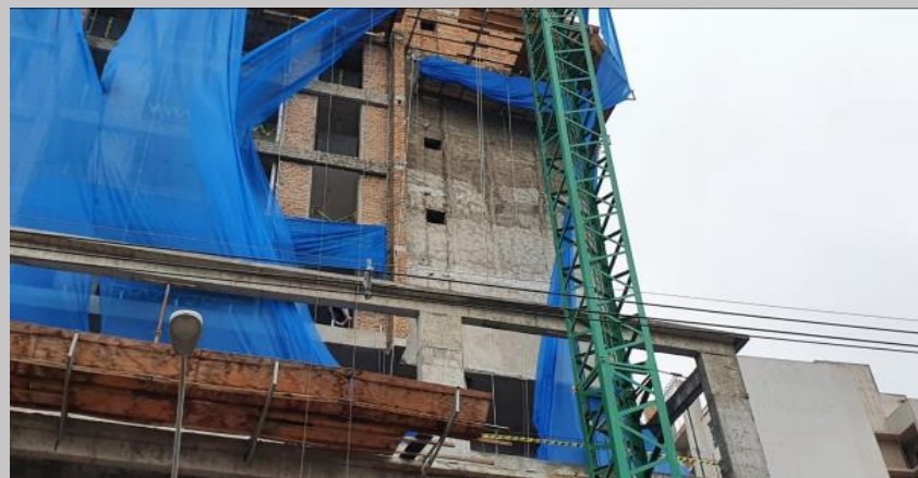
Inicio de los trabajos de revoque de fachadas
