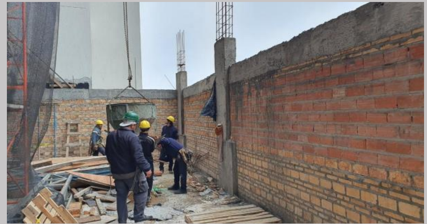
Cargamento de pilares linderos para cerramientos en E3
