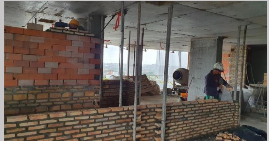
Trabajos actuales de mamposterías en el piso 7
