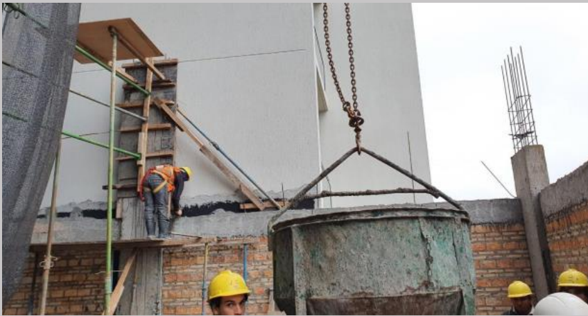
Trabajo de hormigonado de algunos pilares para amarre de mamposterías linderas E3
