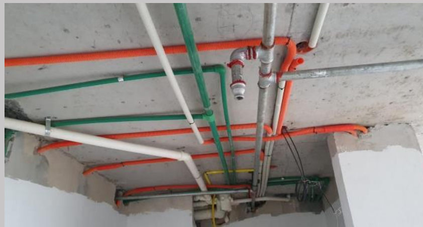
Instalación bajo losa del tercer piso
