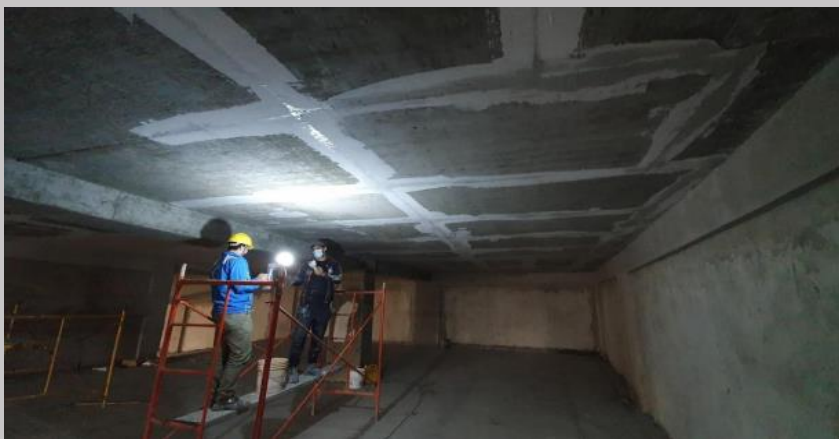
Tratamiento y prolijado bajo losas de estacionamiento
