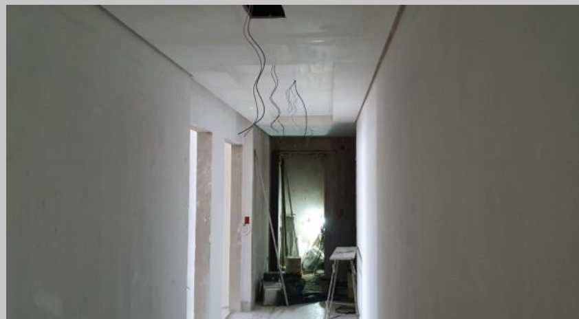
Vista actual del palier en el piso 2
