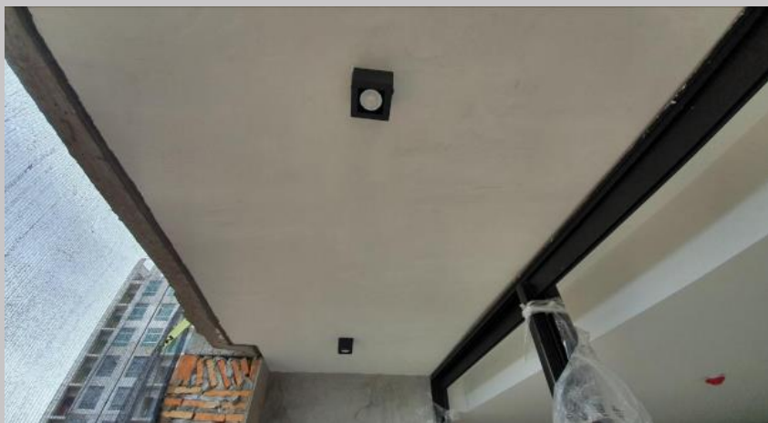
Colocación de artefactos en losa balcón 1E
