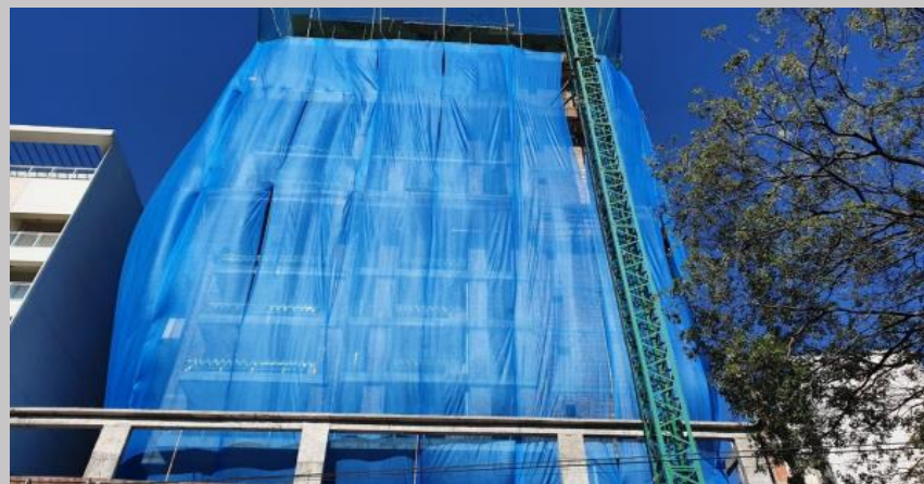
Red de protección extendida en las caras linderas
