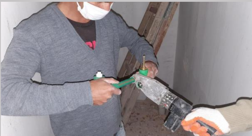
Termofusión para todas las uniones de las redes hidráulicas
