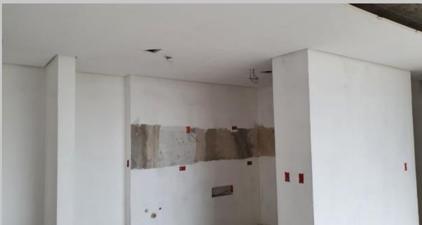
Enduido de paredes 1era mano y cielorraso en el 2F
