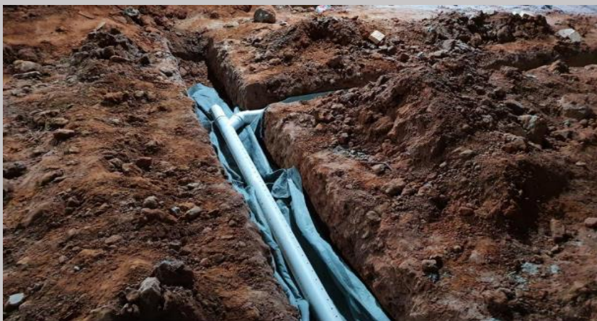
Caño de PVC perforado y tela vidim para red de drenaje sub suelo
