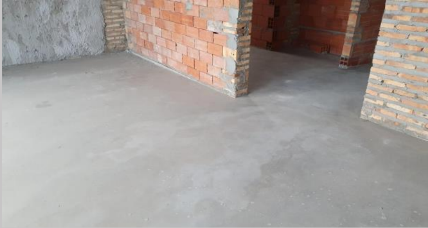
Carga de contrapiso y terminación de carpeta por bombeo en el piso 6A
