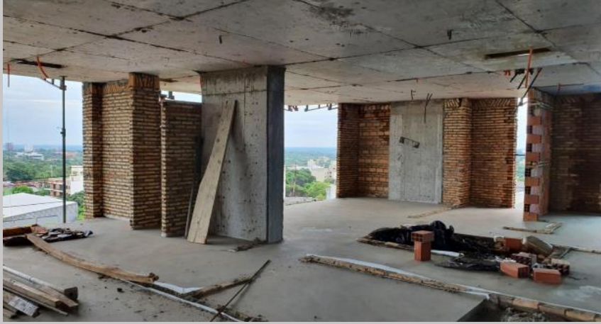
Mamposterías linderas en el piso 7
