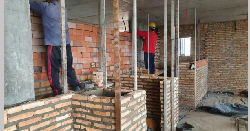
Elevación de paredes en el piso 7
