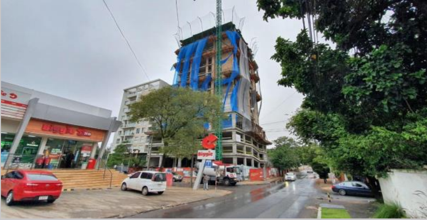
Una vista actual tomada desde calle Pacheco
