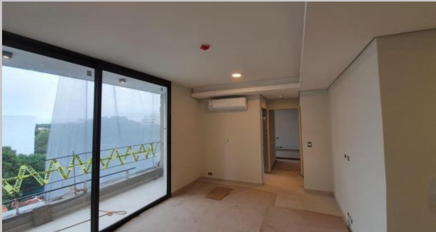
Vista actual de los detalles en el 1C
