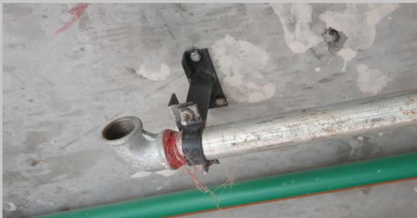
Abrazaderas metálicas para cañerías galvanizadas de PCI
