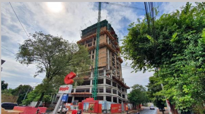
Vista del avance desde esquina de Pacheco y T. Viera
