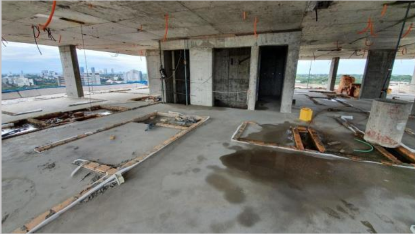
Contrapiso y carpeta bombeado en piso 8
