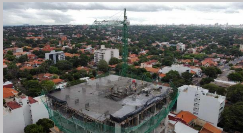
Losa del piso 12
