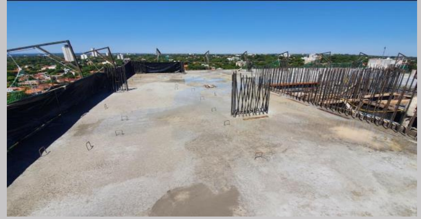
Sectores ya terminados
