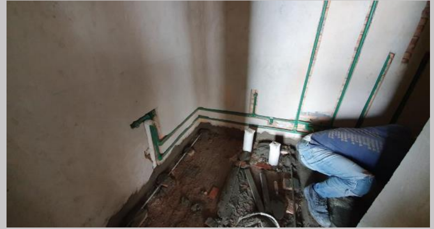
Instalación hidráulica de agua en baños del 4C
