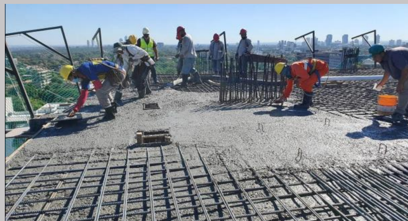
Jornada de cargamento del piso 11
