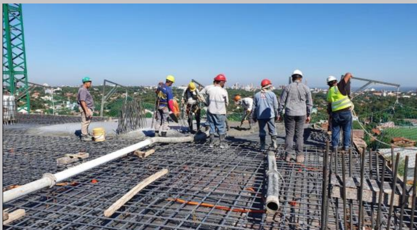
Avance del hormigonado
