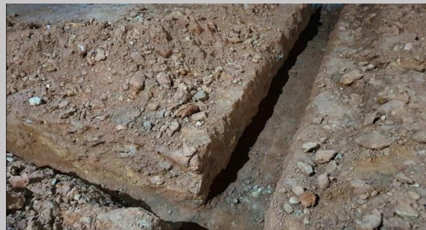
Excavación para la red de drenaje en el sub suelo
