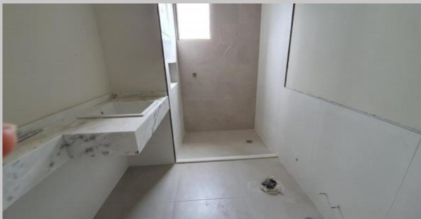
Revestido de baños y mesadas en piso 1
