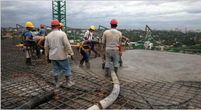
Jornada de hormigonado del piso 12
