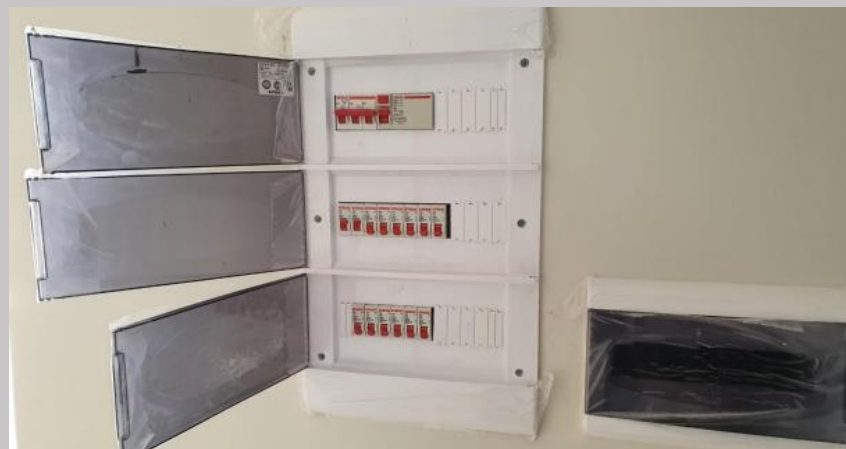
Montaje de llaves en tableros eléctricos del 1E
