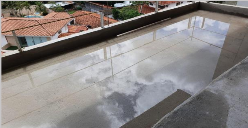
Prueba de agua en aislación de balcones piso 1
