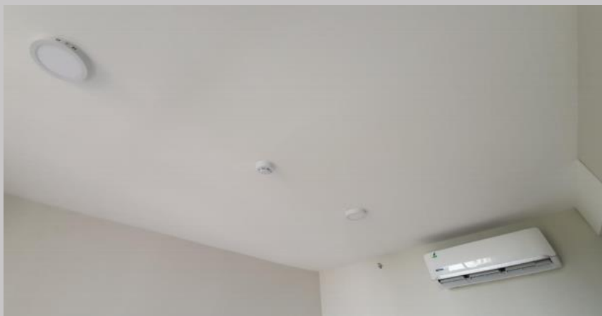
Artefactos de iluminación, evaporador de AA y detector H/C en el 1E
