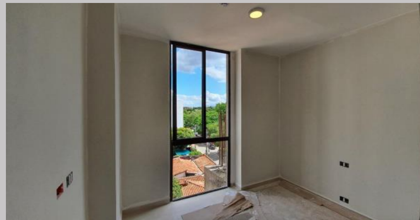
Perfilería de aluminio en aberturas del primer piso
