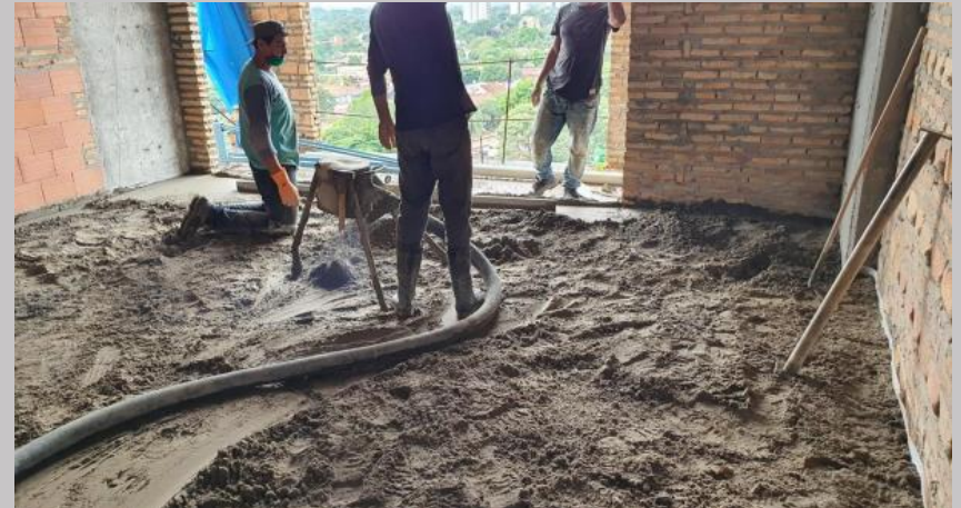
Carga de contrapiso y terminación de carpeta por bombeo en el piso 6
