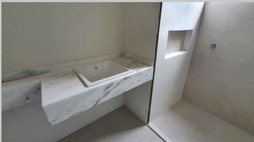
Revestido de baños en departamentos del piso 1
