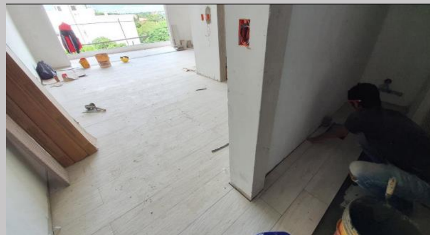
Colocación de piso en el 2C
