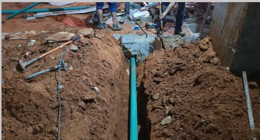
Red de alimentación al tanque de agua inferior
