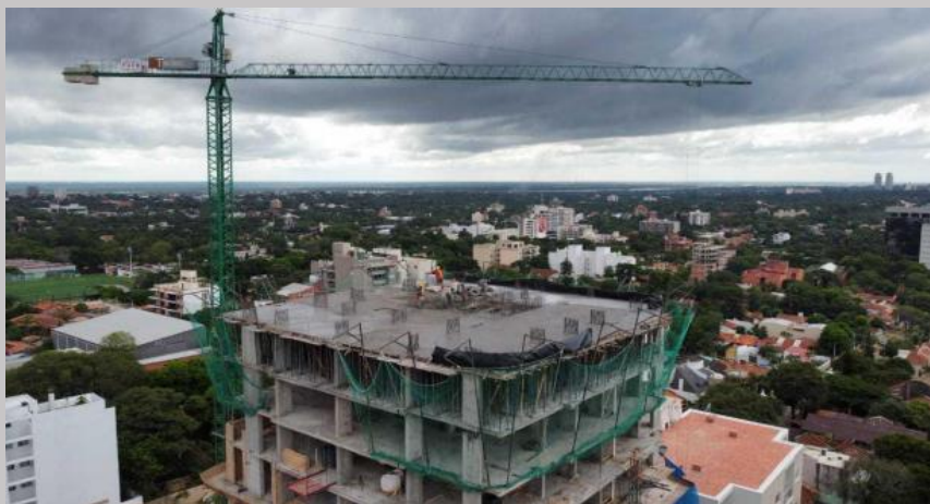
Una toma aerea durante el cargamento del piso 12
