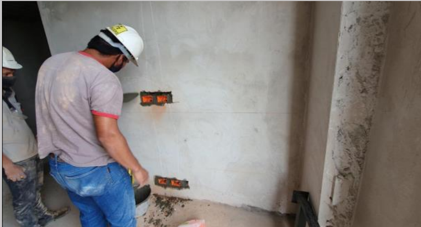
Colocación de cajas de tomas y llaves en el piso 5
