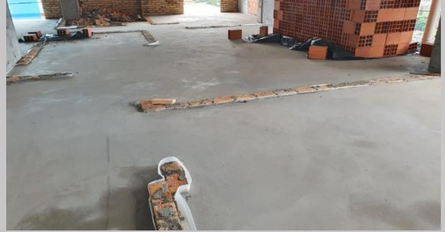
Contrapiso y carpeta bombeada en piso 7
