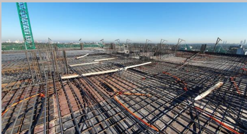
Losa del piso 11 lista a ser hormigonada
