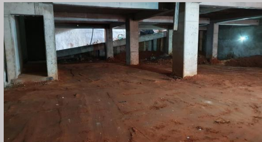
Configuración de niveles terminados y compactación sub suelo
