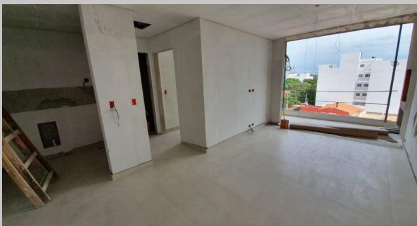
Piso y cielorraso en el 2B
