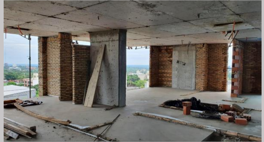
Mampostería linderas en el piso 7
