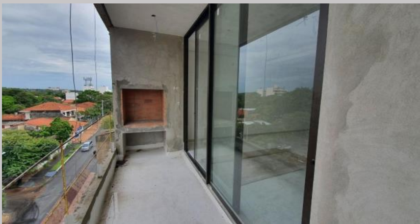
Abertura en balcón del 1D
