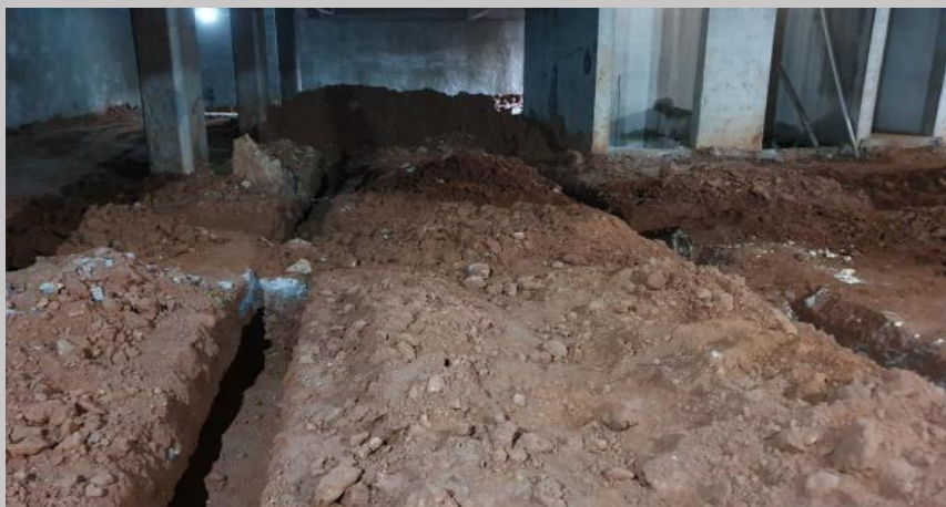
Zanjas para la red de drenaje en el sub suelo
