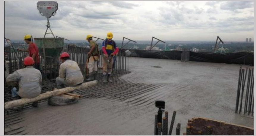
Cargamento de la losa del piso 12 de departamentos
