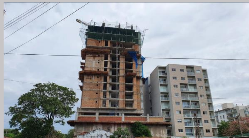
Vista actual de la fachada desde calle S. Bogarín
