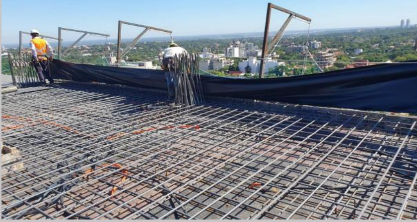
Protección linder a hacia los vecinos durante la carga
