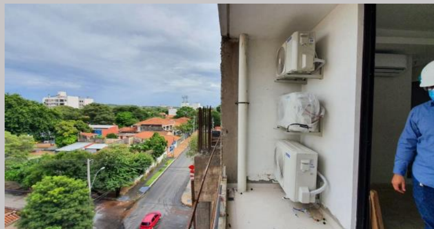
Sector de compresores en balcón del 1
