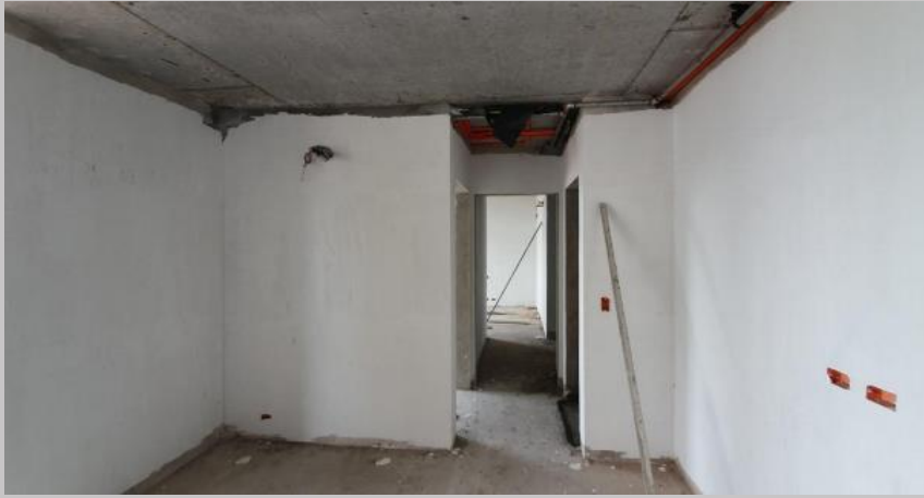
Enduido de paredes en el 3C
