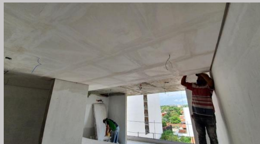
Colocación de cielorraso en el 2D
