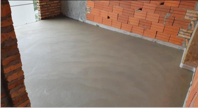
Carpeta terminada piso 6
