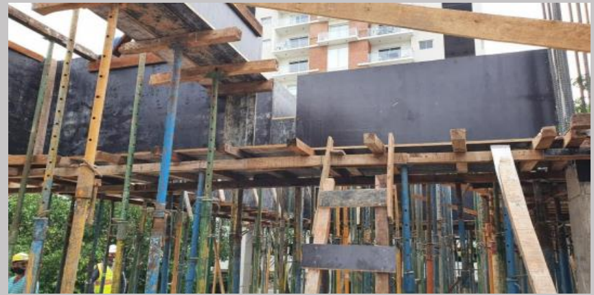
Encofrado de los fondos y costados de las vigas de la primera losa de planta tipo
