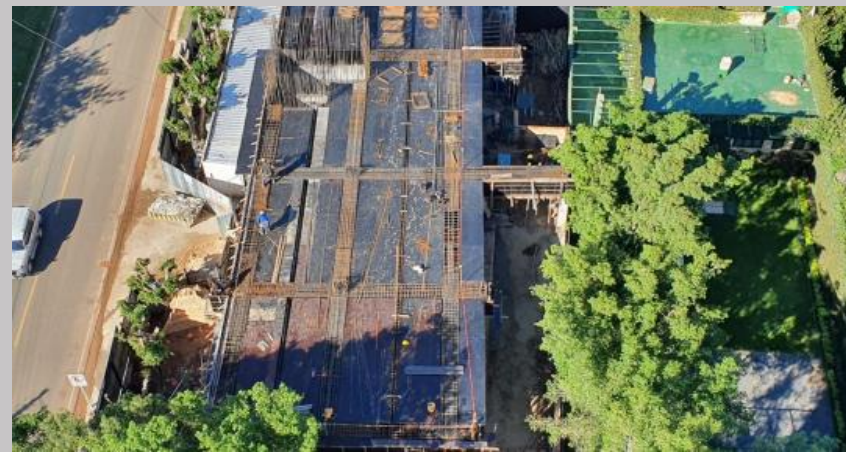
Tramo de la rampa de acceso al estacionamiento del primer piso ya hormigonado
