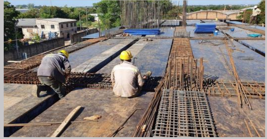
Una vista actual del avance en el armado de las vigas de la planta tipo 1
