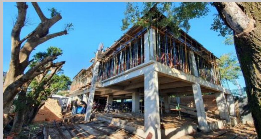
Una vista del avance actual
