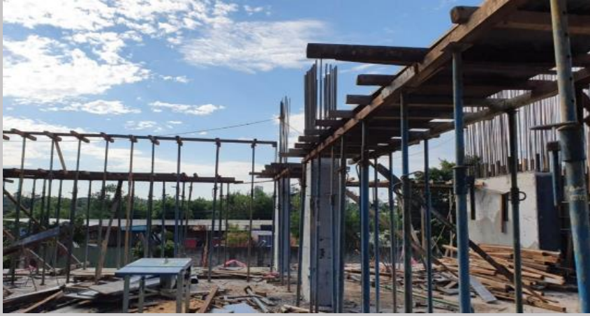
Pilares hormigonados y encofrado de las vigas de transición
