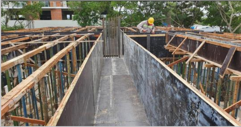
Una de las llamadas vigas de transición y el encofrado de losa
