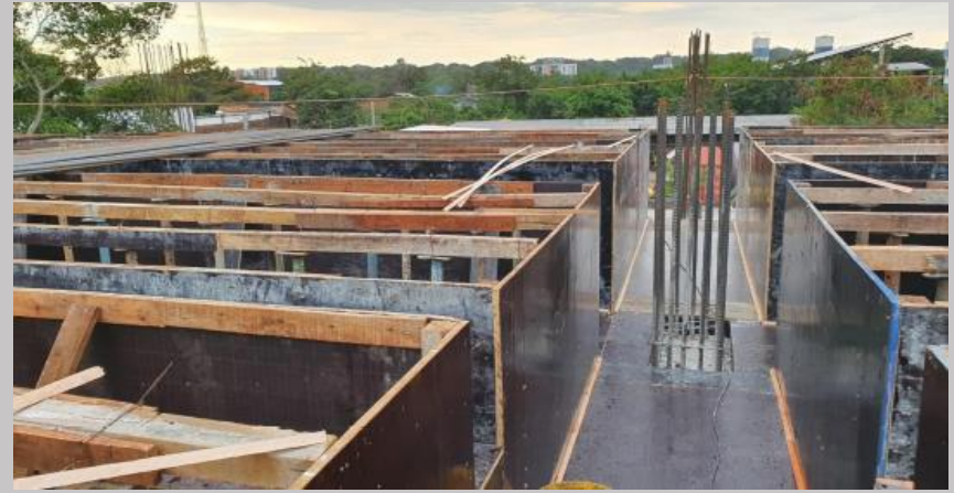
Avance en el encofrado de las vigas y losas del piso 1
