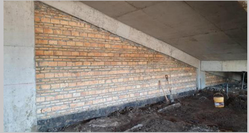
Algunos trabajos de mampostería de linderos sector bajo rampa P. Baja
