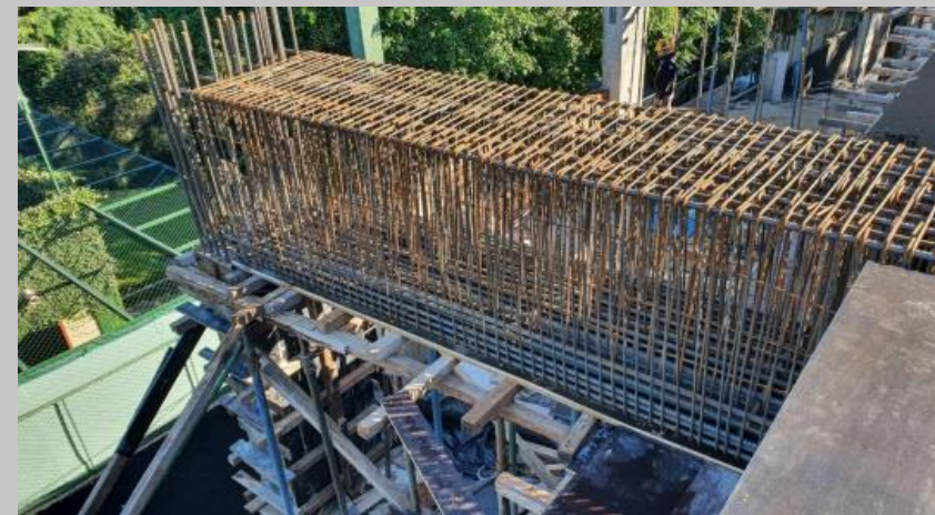
Vigas de soporte estructural de armado y encofrado de dimensiones importantes
