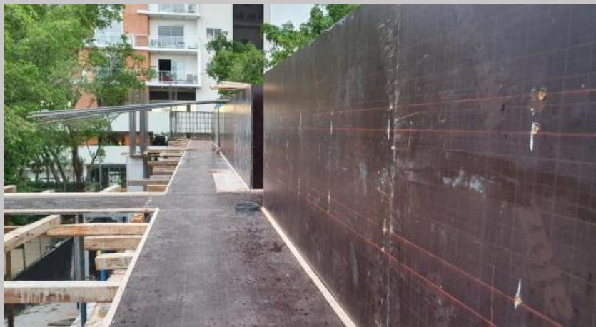
Vista del fondo y lateral de una de las grandes vigas
