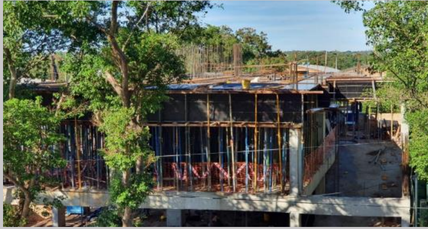
Trabajo actual de encofrado y armadura para el piso 1
