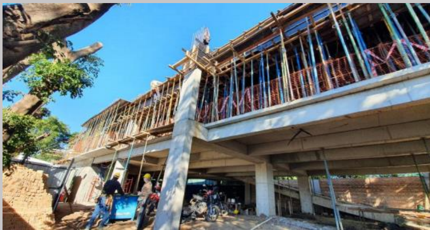
Vista actual del encofrado para la primera planta tipo
