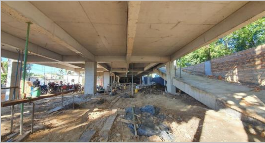
Losas y vigas del sector ya terminado del techo de planta baja
