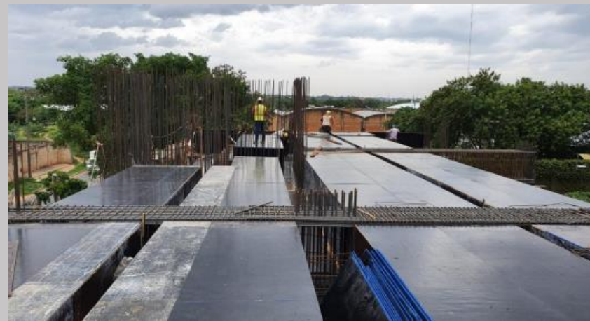
Emplacado para el encofrado del fondo de losas
