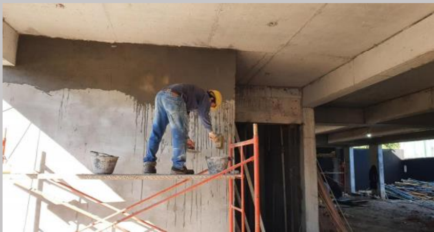
Trabajos de prolijado con cementicio en algunos sectores de la estructura vista
