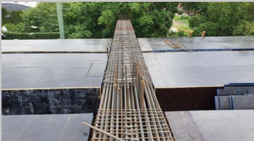
Inicio del armado de las vigas maestras
