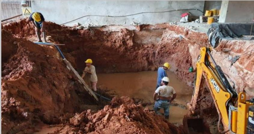
Vista actual del avance de los trabajos de excavación para el tanque enterrado
