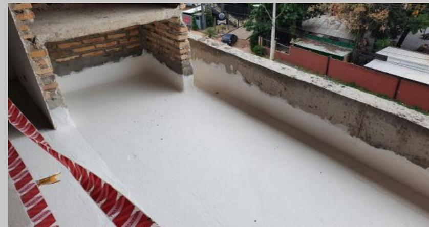
Pintura hidrófuga para aislación en balcón del 1B
