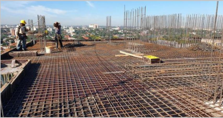
Nivel de losa para el piso 9 con el trabajo de armaduras
