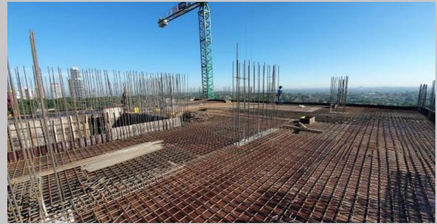
Encofrado y armado de la ultima losa de plano tipo
