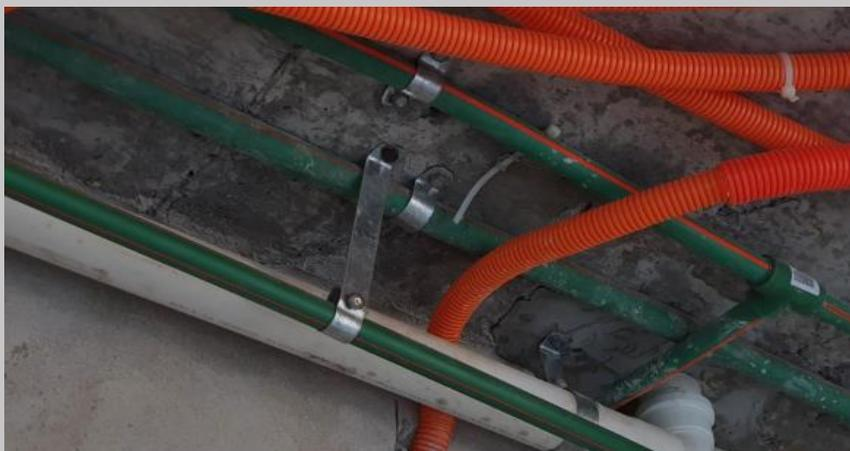
Soportes metálicos para los colgantes bajo losa
