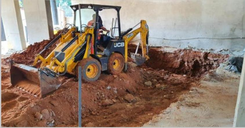
Inicio de la excavación para el tanque enterrado de agua en planta baja
